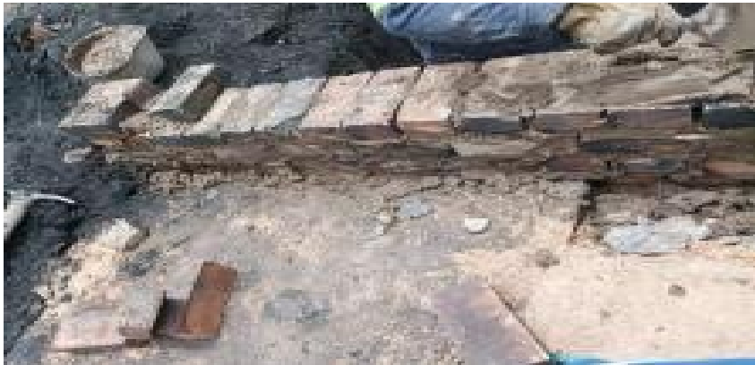
Ilustración 56. Construcción de muro en mampostería.
