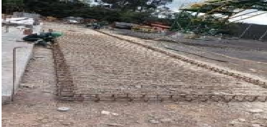
Ilustración 50. Armazón de placa cubierta.
