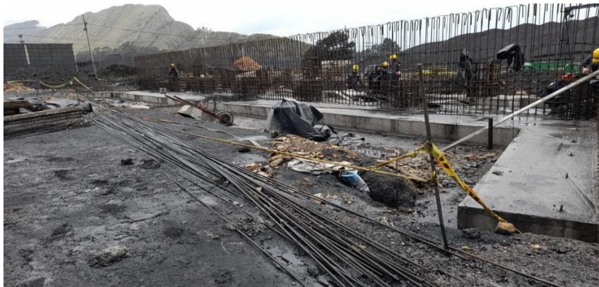
Ilustración 15. Muro de contención.
