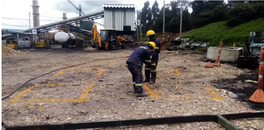
Ilustración 4. Localización y replanteo del sistema de molienda.
