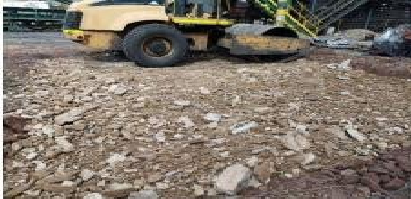
Ilustración 39. Relleno y compactación de tierra
