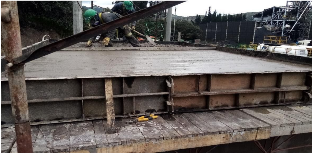
Ilustración 30. Fundición de concreto en placa.
