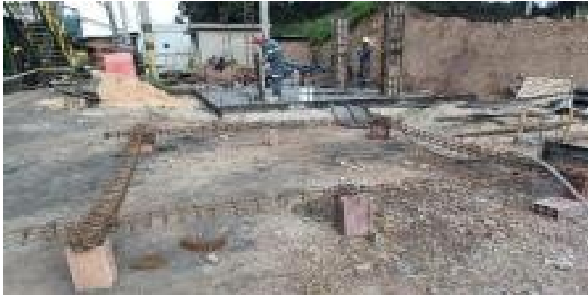
Ilustración 57. Construcción de muro en mampostería.
