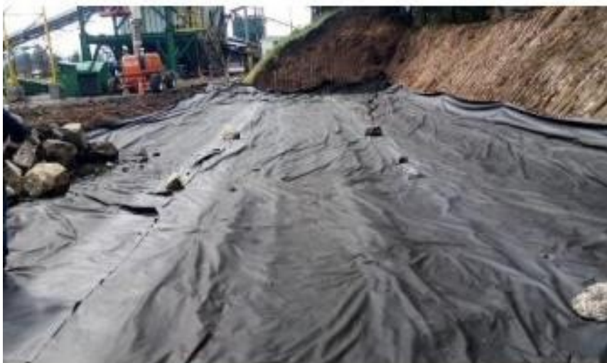
Ilustración 58. Instalación de geotextil.
