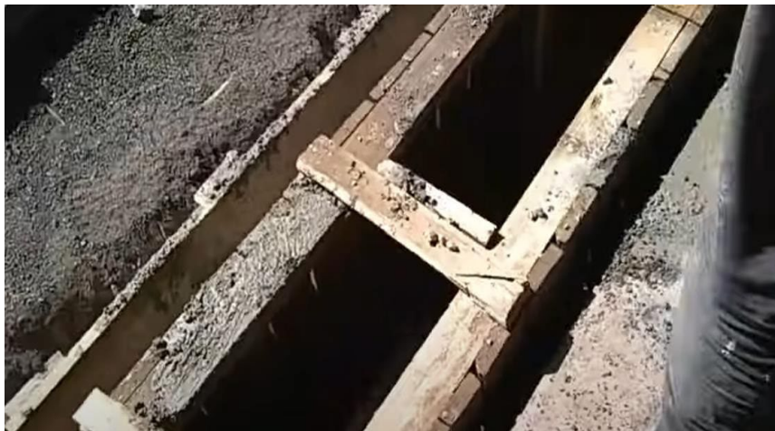
Ilustración 26. Fundida de concreto cárcamo.
