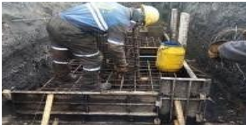
Ilustración 54. Instalación armazón de acero.
