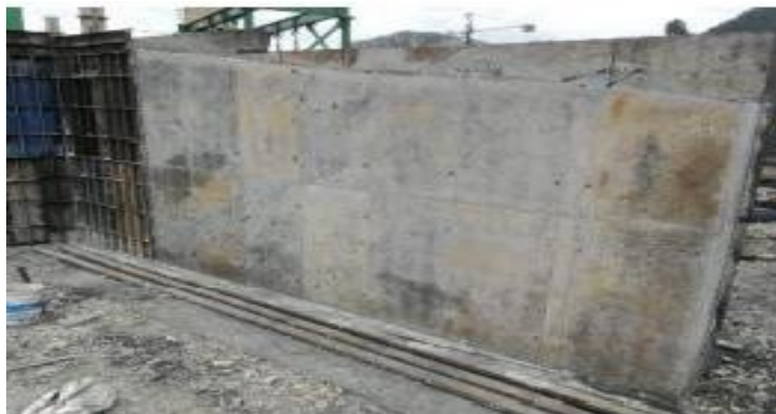
Ilustración 23. Retiro de formaletas y curado de concreto muro de contención.
