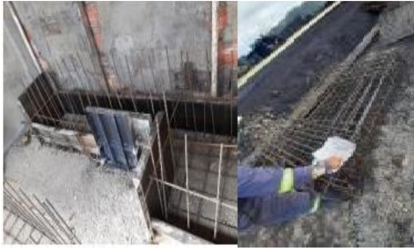
Ilustración 25. Armazón en acero y solado.
