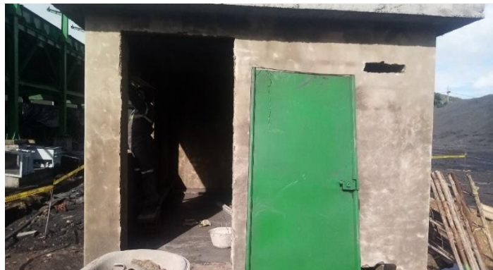
Ilustración 32. Pañete en paredes exteriores y filos.
