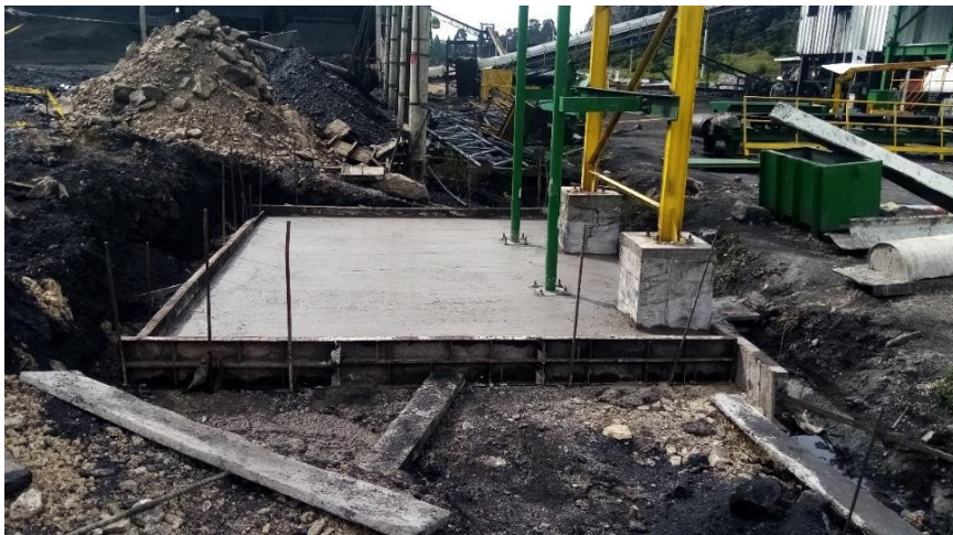
Ilustración 24. Construcción cárcamos en concreto.
