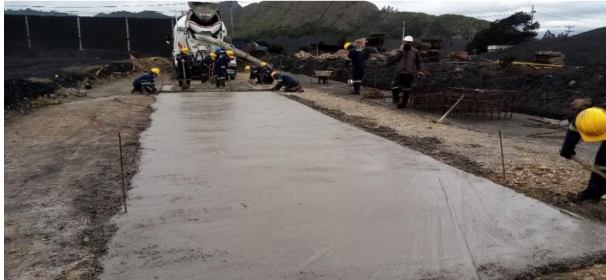
Ilustración 11. Vaciado del solado.
