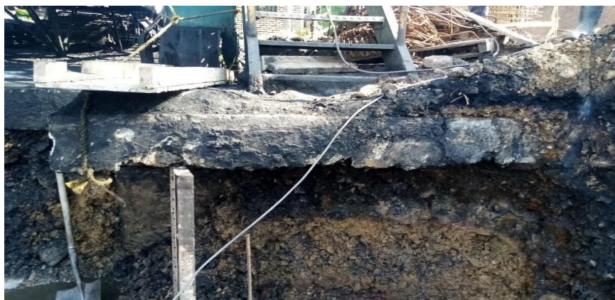
Ilustración 5. Solado zapatas base molienda.
