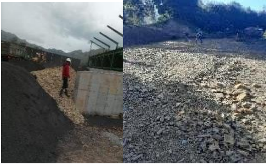
Ilustración 60. Relleno de material seleccionado.
