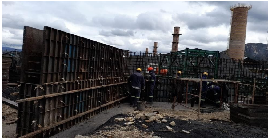
Ilustración 22. Instalación formaleta metálica en muro de contención.
