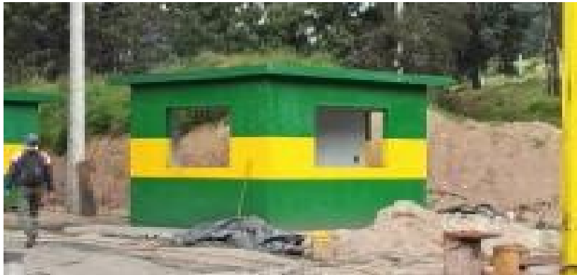
Ilustración 51. Aplicación pintura exterior
