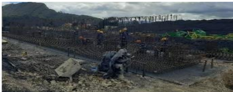
Ilustración 12. Figurado y amarre de acero para las tolvas, separador magnético y tornillo mezclador.
