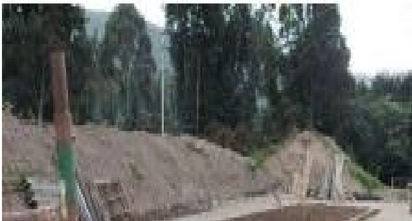
Ilustración 38. Excavación de tierra.
