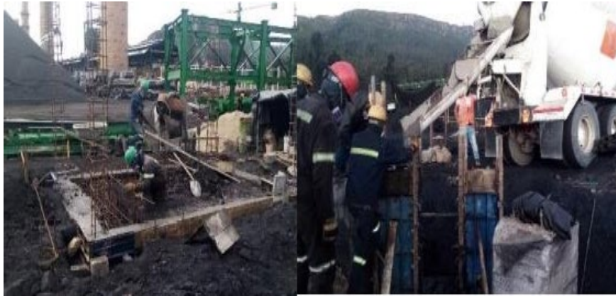
Ilustración 55. Fundida de concreto.
