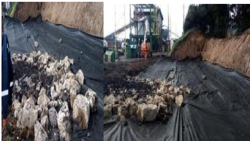
Ilustración 59. Instalación geotextil y piedra rajón.
