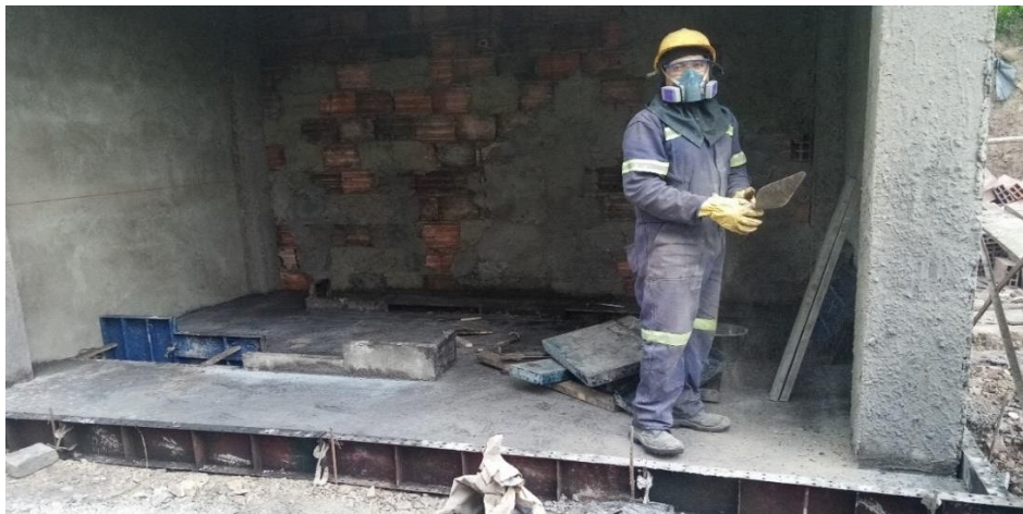
Ilustración 31. Aplicación de pañete en paredes internas.
