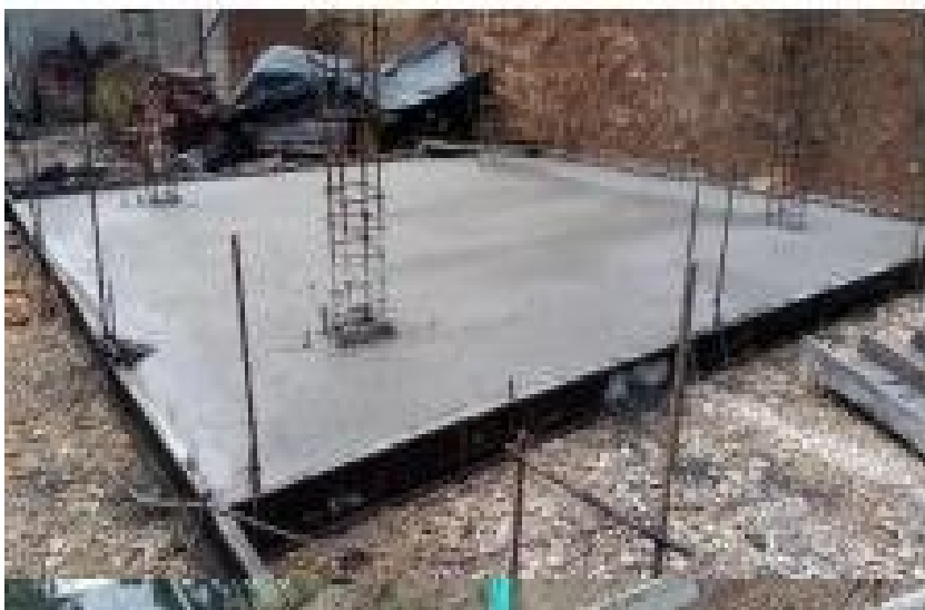
Ilustración 44. Fundición de concreto.
