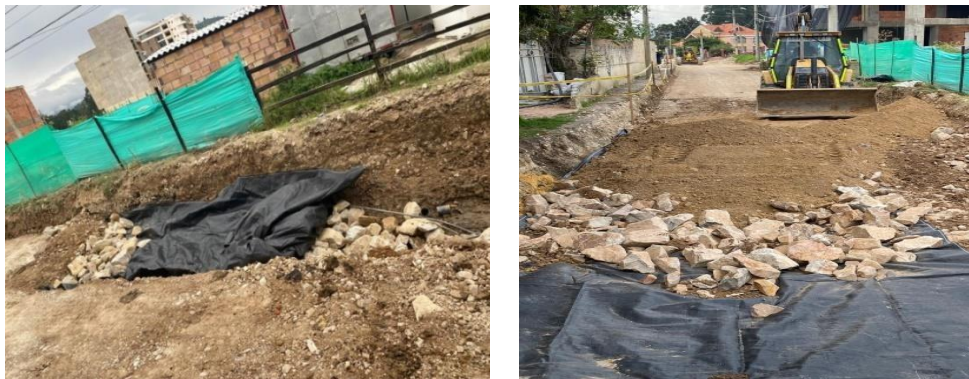
Figura 23. Mejoramiento y estabilización del suelo tramo 1
