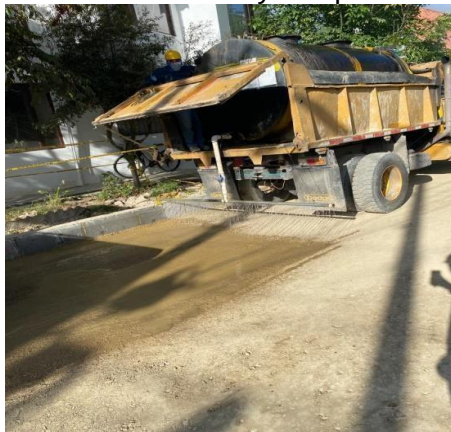
Figura 34. Adecuación y compactado tramo 1
