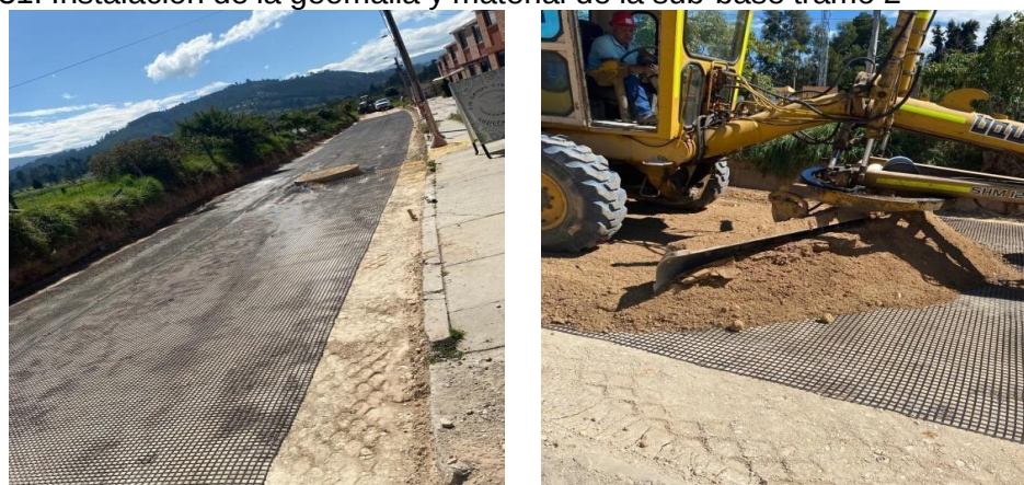
Figura 31. Instalación de la geomalla y material de la sub-base tramo 2
