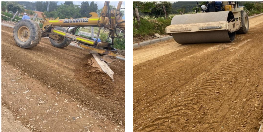
Figura 33. Extendido de base tramo 2
