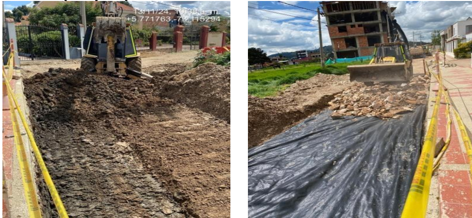
Figura 25. Cajeos y mejoramiento tramo 1
