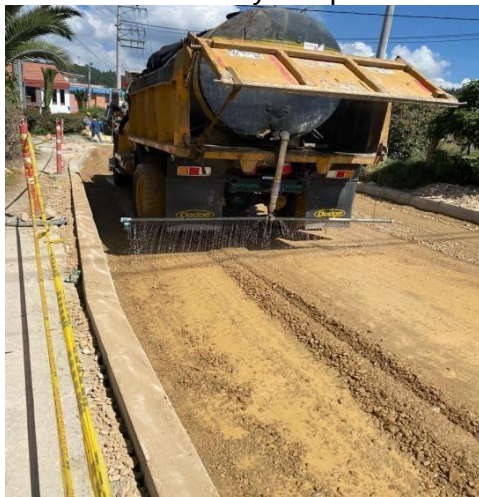
Figura 35. Adecuación y compactado tramo 2
