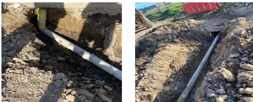
Figura 26. Instalación tubería sumidero con el pozo de inspección tramo 1
