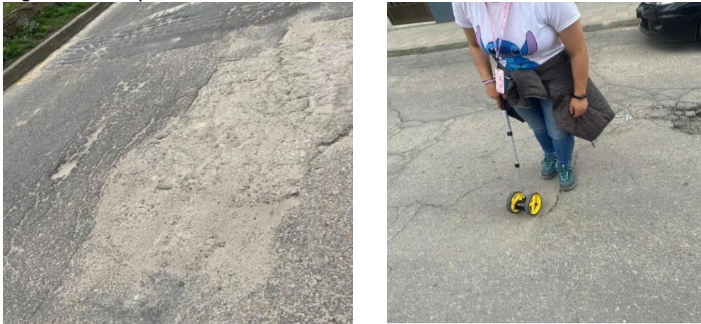
Figura 5. Recopilación de datos malla vial carrera 21
