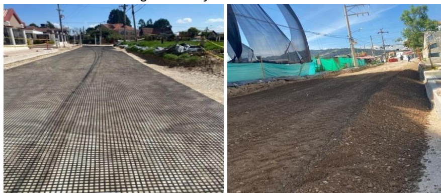
Figura 30. Instalación de la geomalla y material de la sub-base tramo 1
