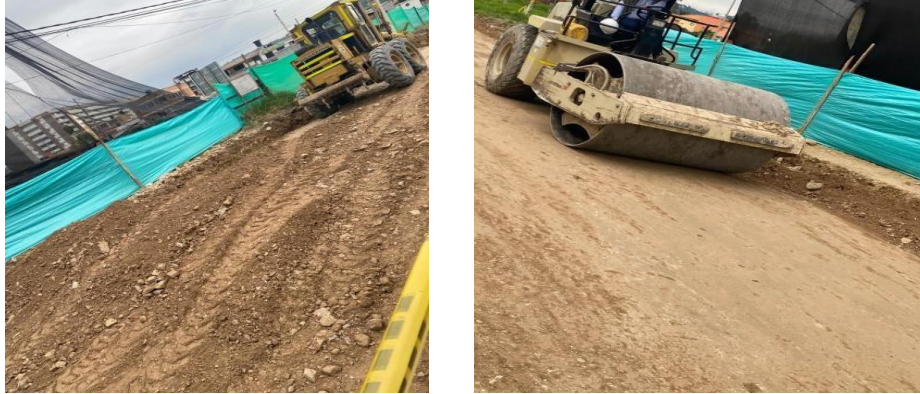
Figura 24. Extendido y compactado de material tramo 1
