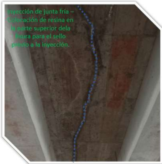
Vista inferior de la losa
