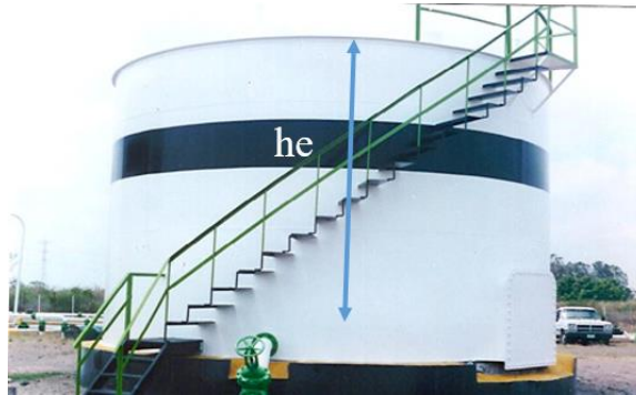
Figura 66. Ilustración de la altura de enfriamiento ( h_e ).
