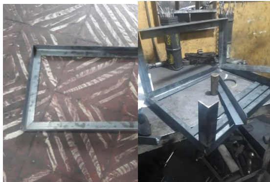
Figura 32. Corte y soldado de ángulo para estructura
