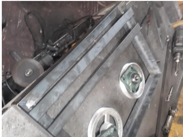
Figura 34. Corte de platinas para soportes.
