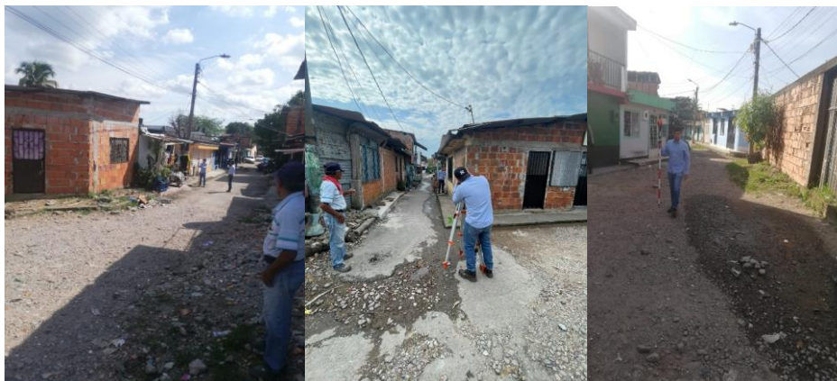
Figura XXI. Levantamiento topográfico día 3 y 4
