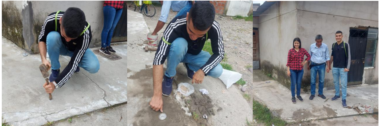
Figura XXVI. Instalación del segundo mojón
