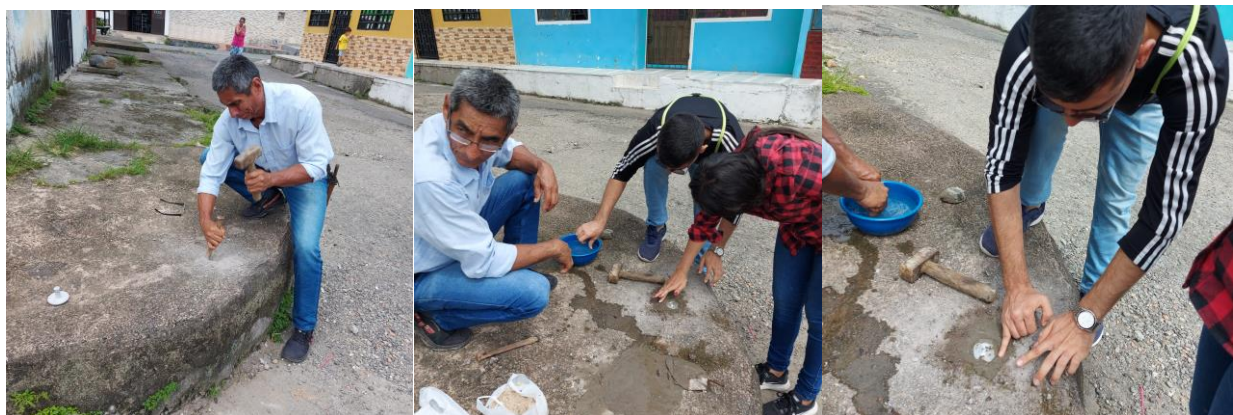
Figura XXV. Instalación del primer mojón
