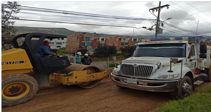
Figura 30. Compactación de material de afirmado
