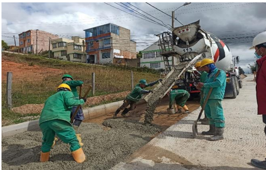
Figura 45. Fundida de concreto carril izquierdo
