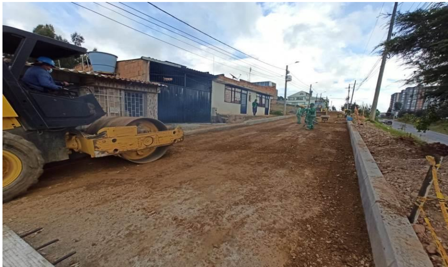
Figura 34. Compactación de subbase, cerca al muro en tierra armada
