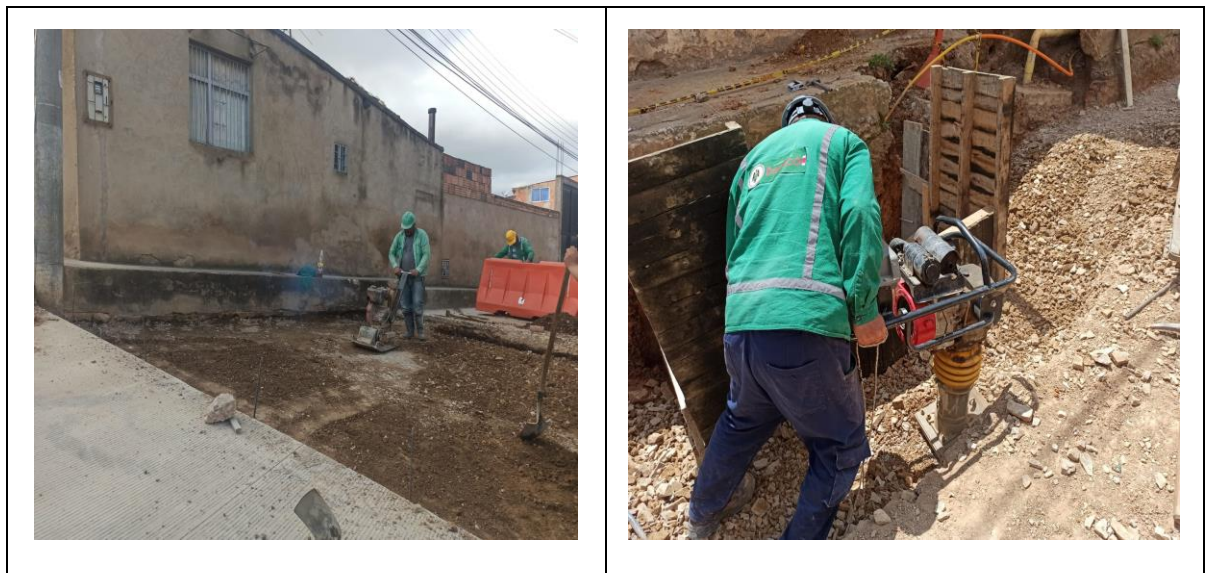
Figura 59. Compactación de manera manual
