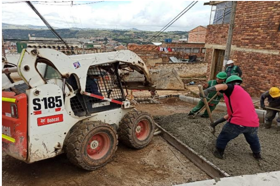
Figura 69. Fundida de concreto carril derecho
