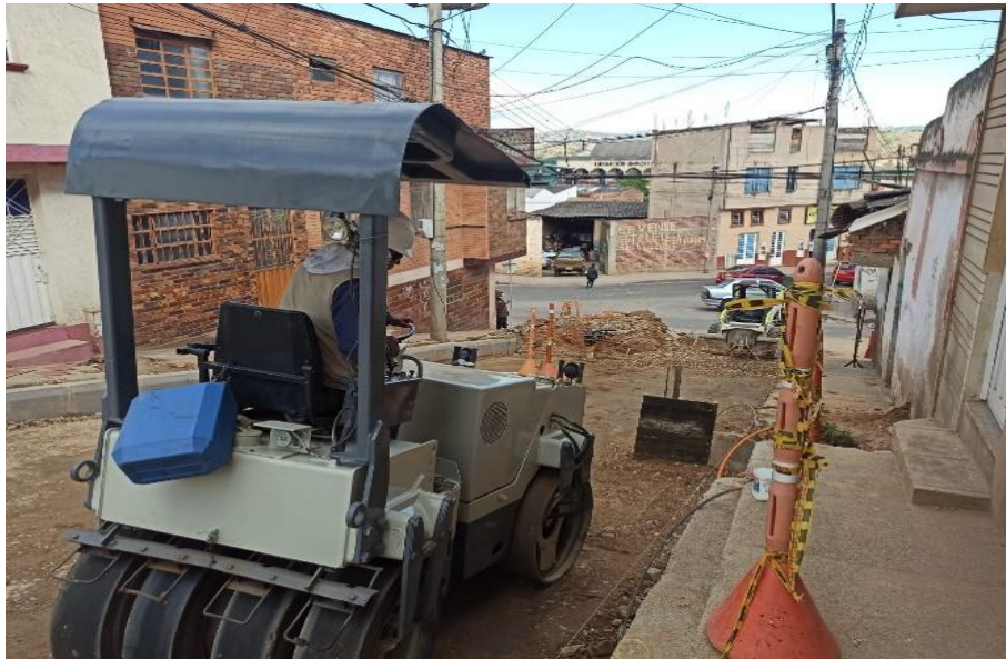
Figura 60. Compactación de Subbase
