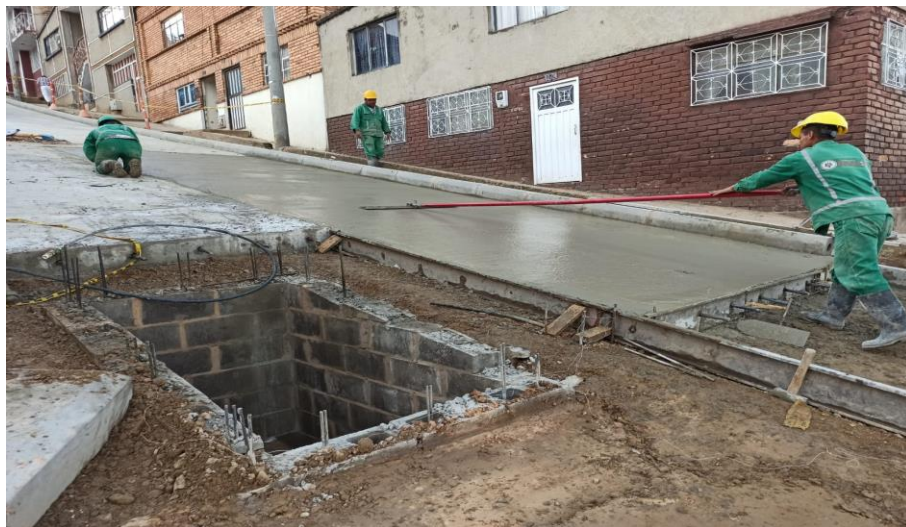
Figura 72. Nivelación de la mezcla
