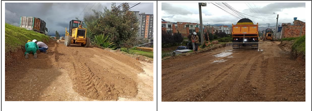
Figura 29. Extensión e Irrigación de material de afirmado
