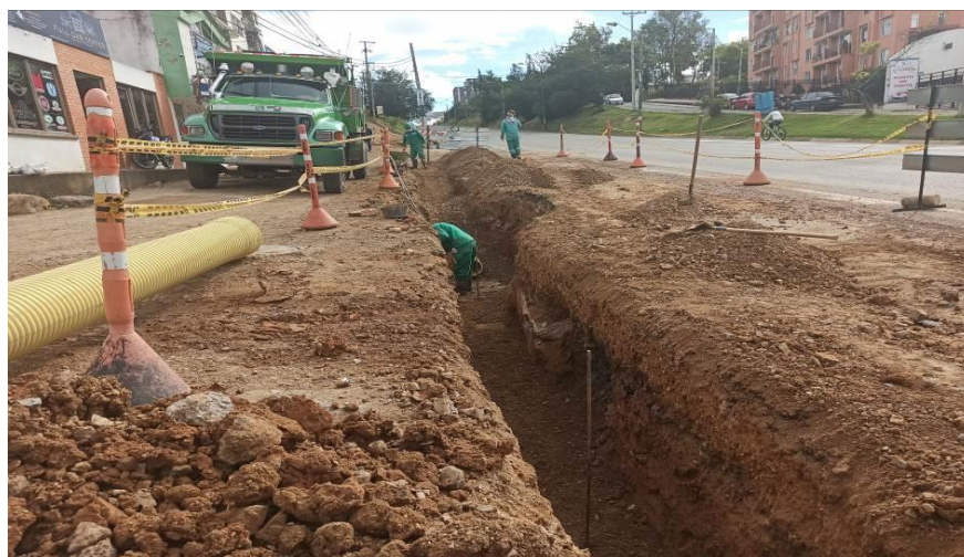
Figura 10. Excavación para tubería de PVC Novafort
