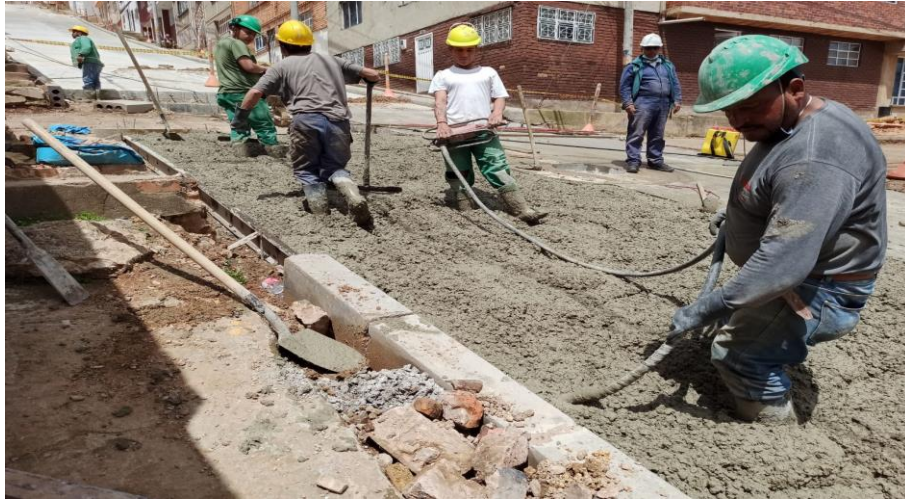
Figura 67. Vibrado de la mezcla de concreto
