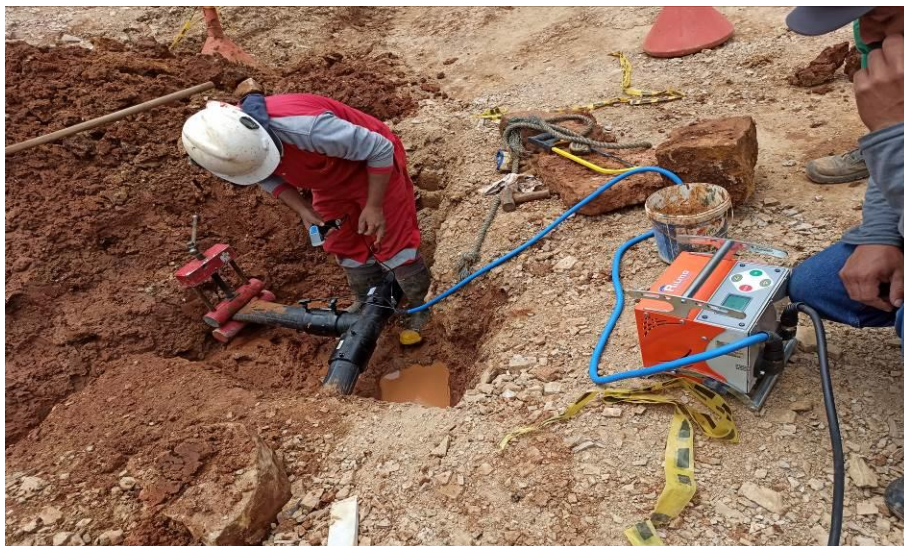
Figura 18. Colocación unión T por parte de Veolia
