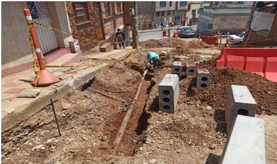
Figura 54. Profundización red de acueducto
