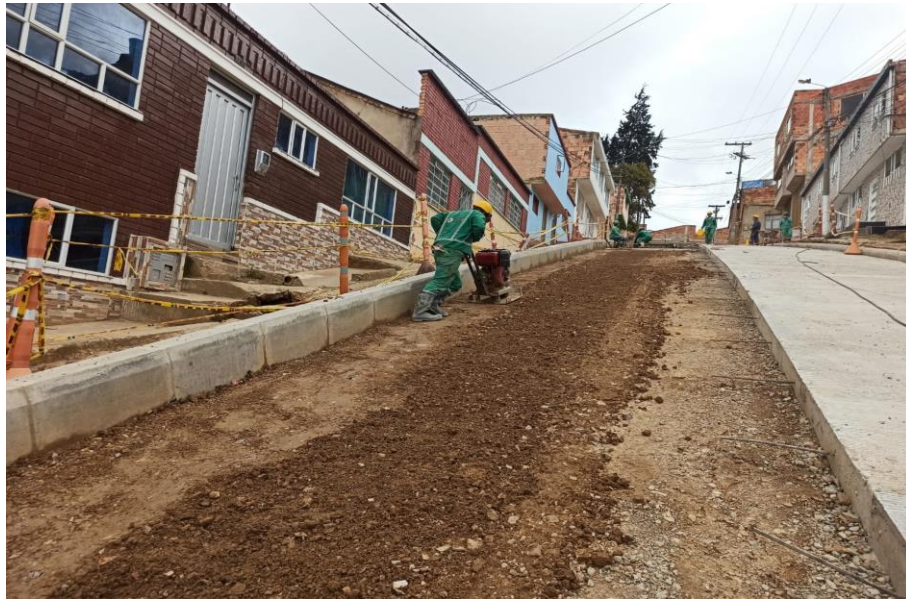
Figura 58. Compactación carril derecho
