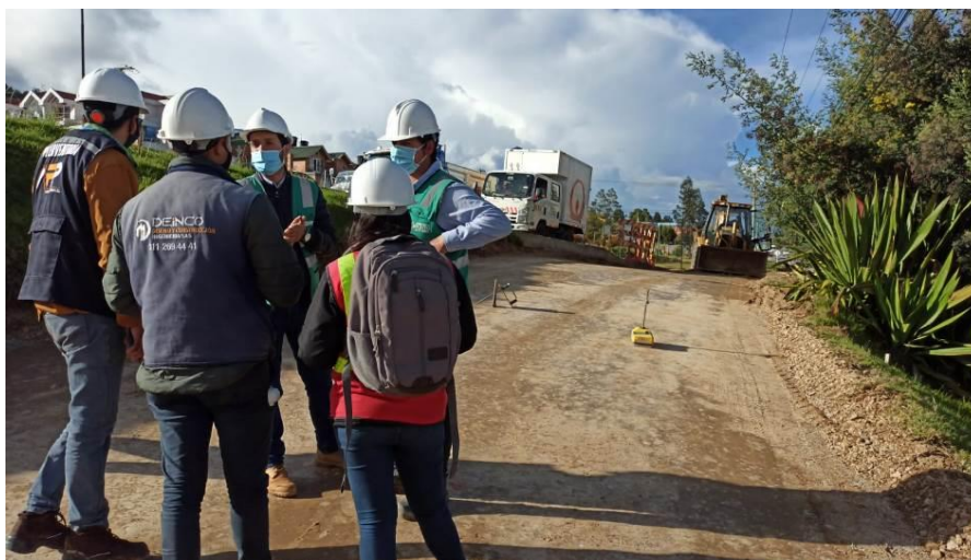
Figura 36. Toma de densidades para Subbase (ABS K0+220)
