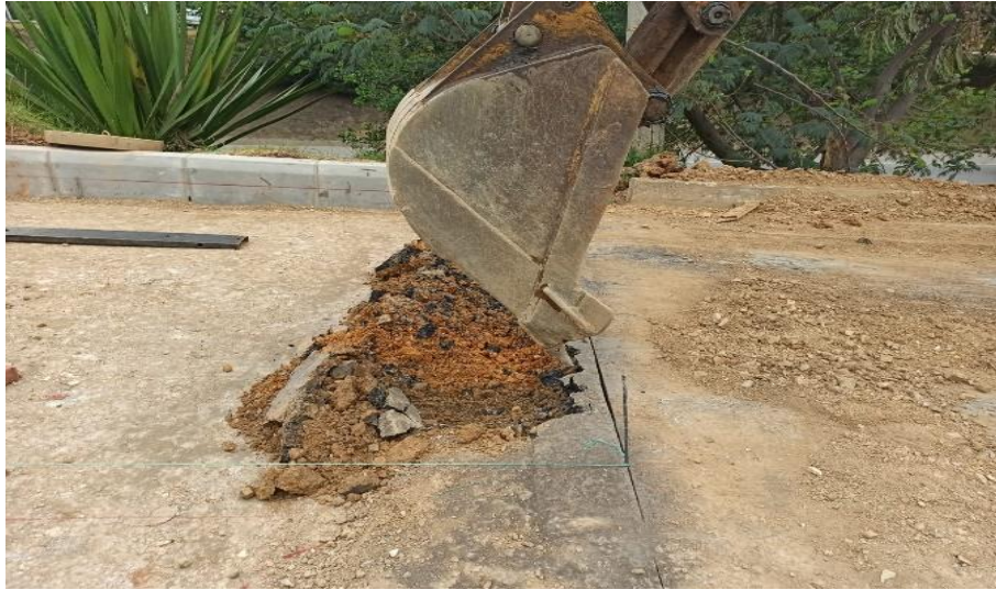
Figura 43. Demolición de asfalto
