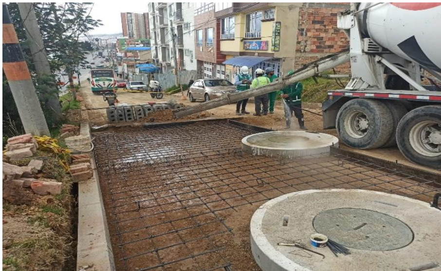
Figura 44. Empalme con estructura de pavimento ya existente
