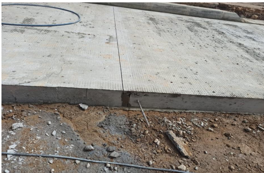
Figura 48. Cambio distribución varillas de amarre
