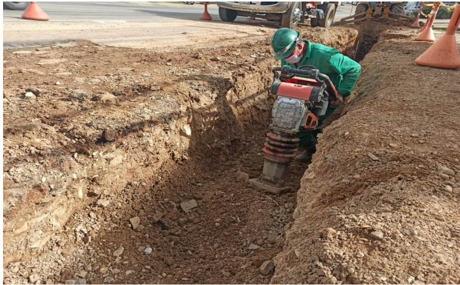
Figura 11. Compactación de la excavación de la tubería de PVC Novafort
