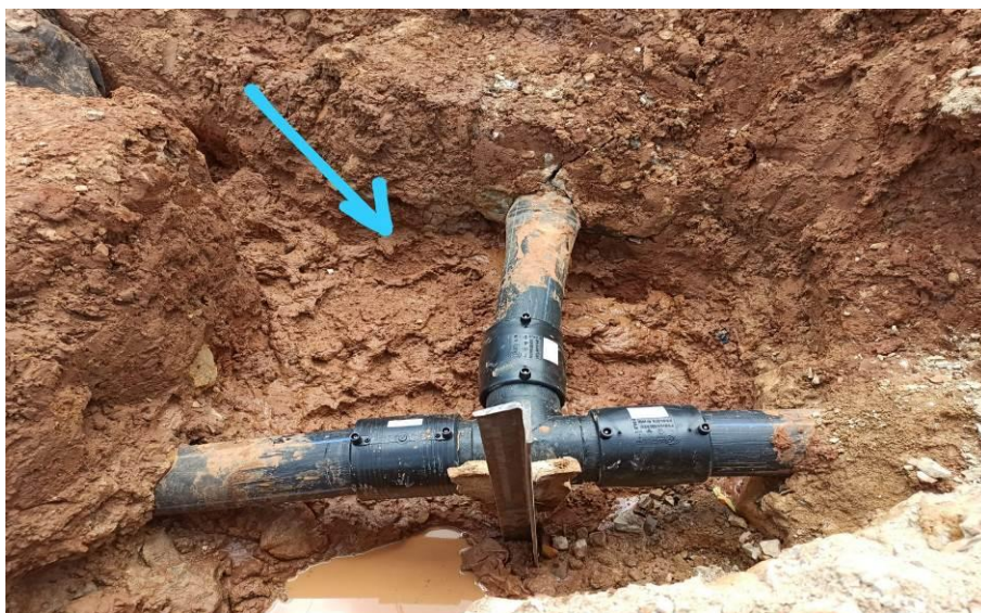
Figura 19. Reparación por parte de Veolia
