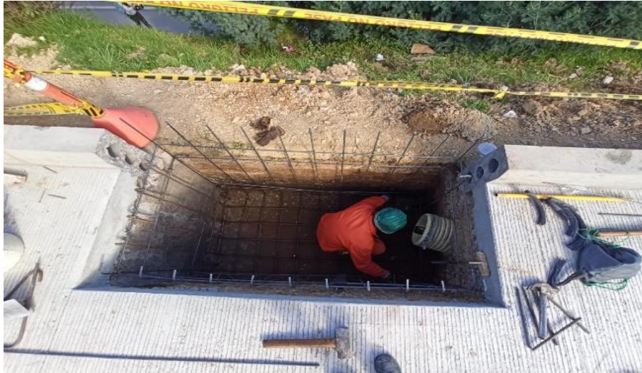
Figura 25. Despiece sumidero combinado
