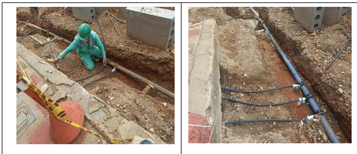
Figura 56. Reconexiones de las acometidas domiciliarias
