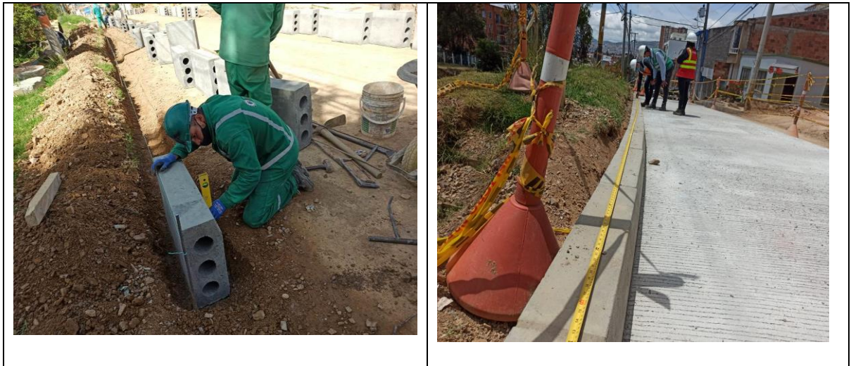
Figura 15. Excavación e Instalación de sardinel
