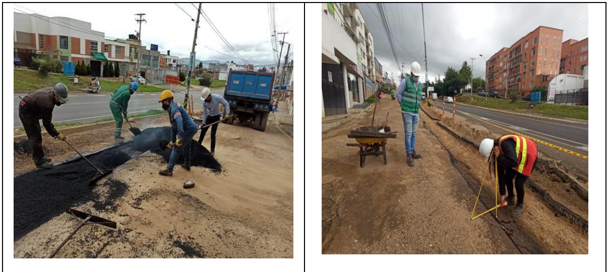
Figura 12. Reparcheo de asfalto
