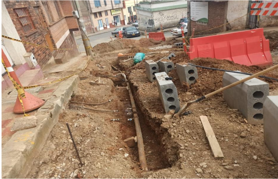
Figura 55. Desconexiones de acometidas domiciliarias
