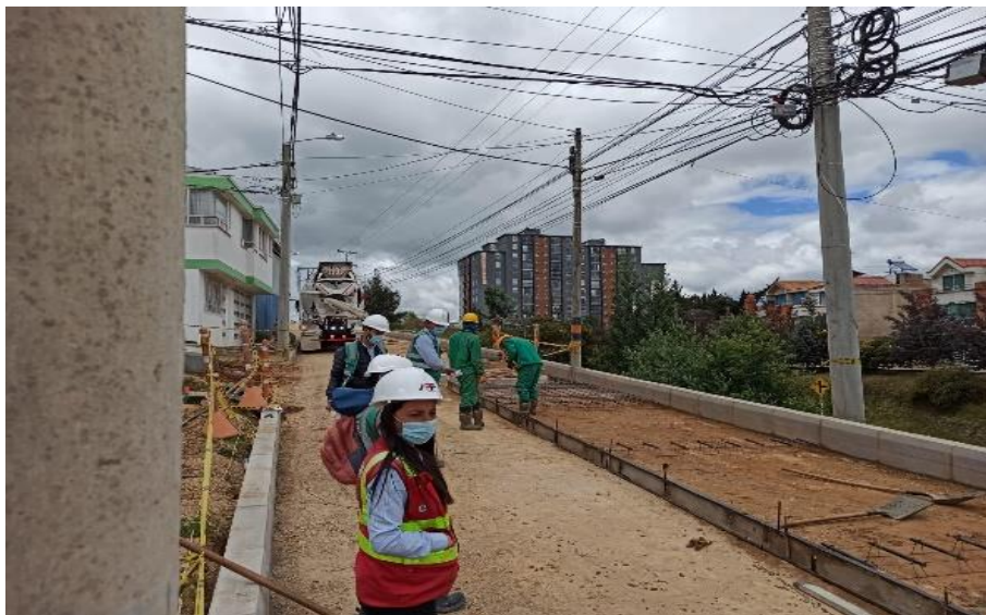
Figura 41. Instalación de dovelas y formaleta
