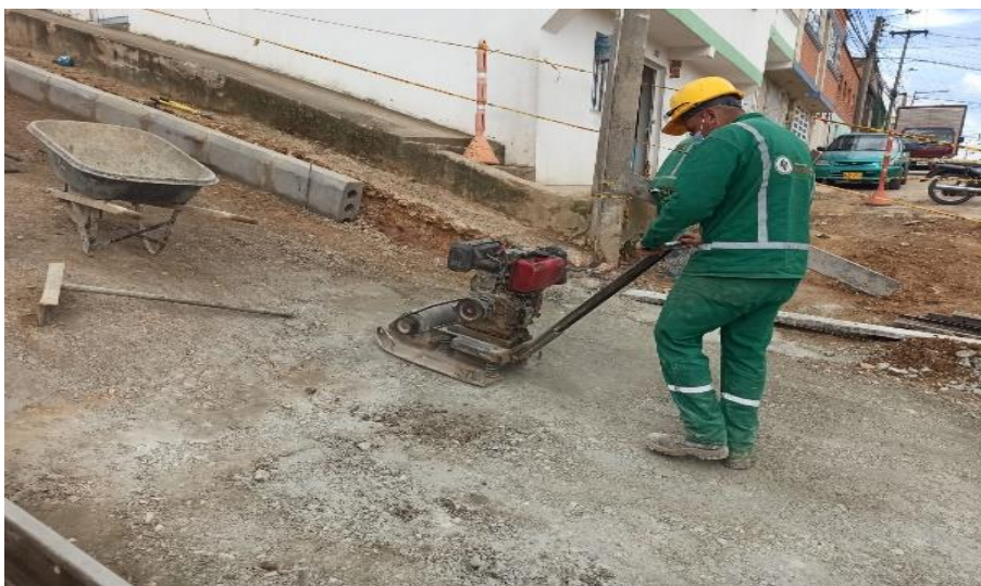
Figura 49. Mejoramiento de subbase
