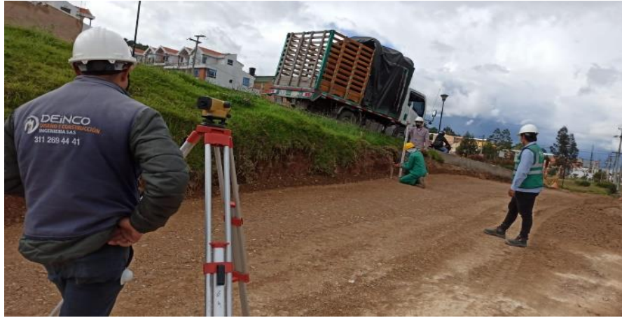
Figura 35. Nivelación de Subbase
