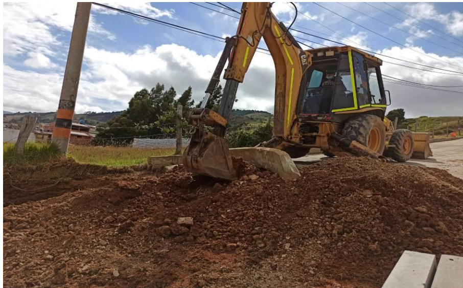
Figura 13. Demolición y Excavación para bocacalle ABS (K0+150)
