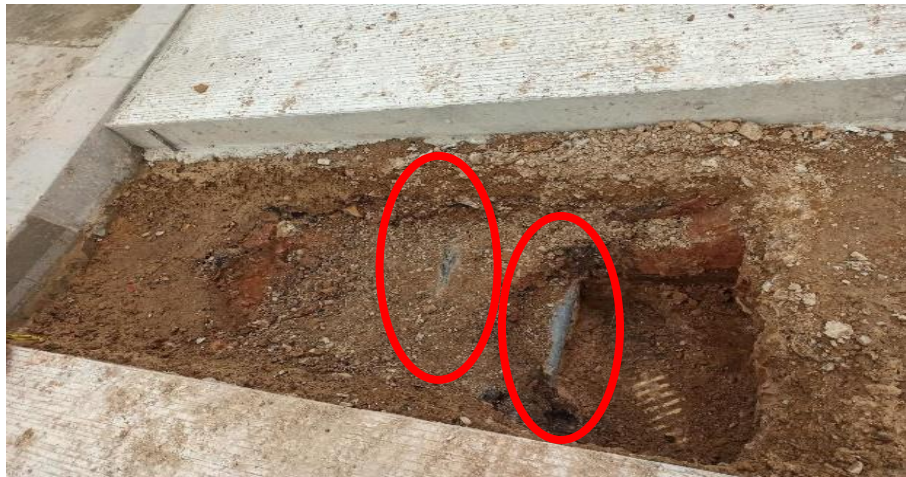
Figura 27. Sumidero transversal ABS (K0+045)
