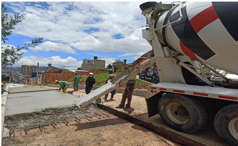
Figura 42. Fundida de concreto carril derecho
