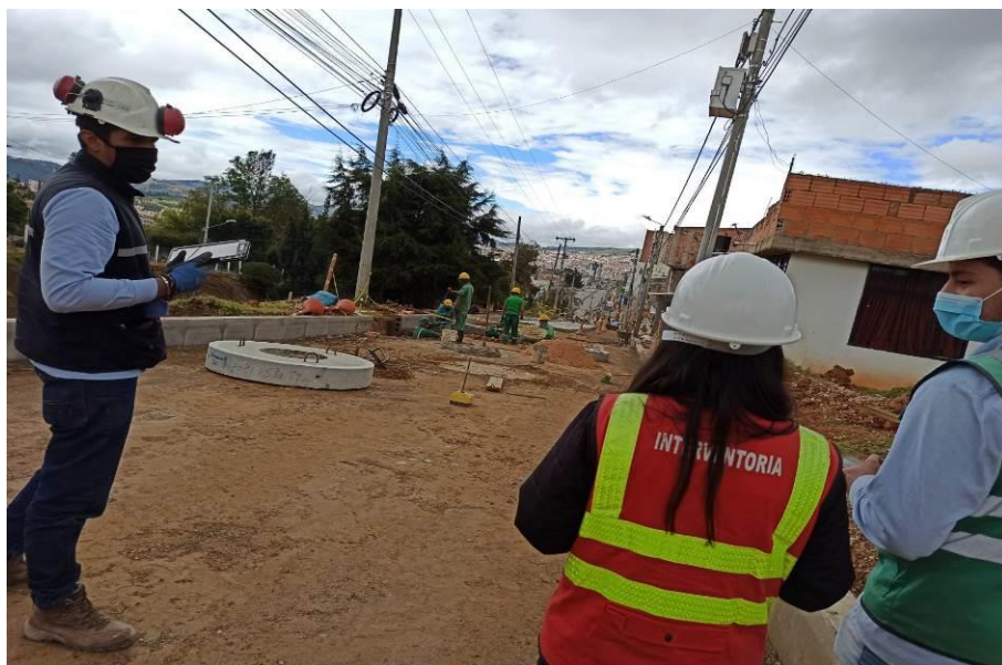
Figura 40. Toma de densidades para subbase ABS (K0+110)
