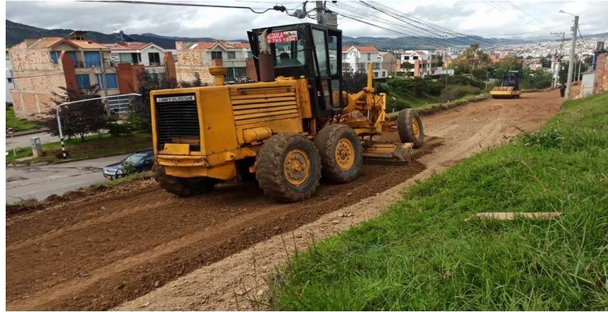
Figura 31. Extensión material de Subbase ABS (K0+210 a K0+235)
