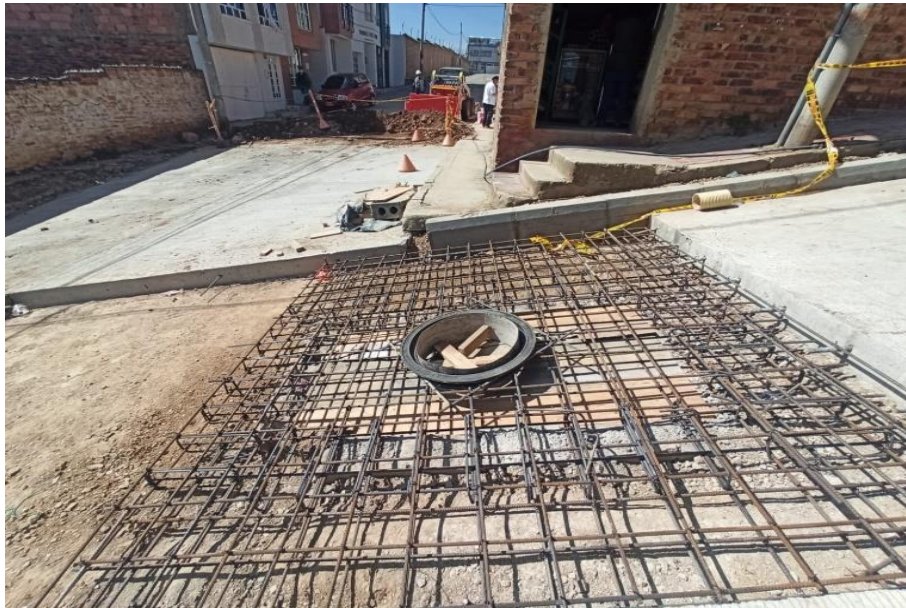
Figura 71. Doble parrilla para caja de telefónica
