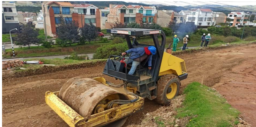
Figura 32. Compactación material de Subbase ABS (K0+210 a K0+235)
