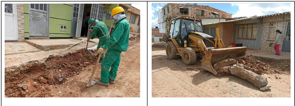
Figura 9. Corte y demolición de andenes
