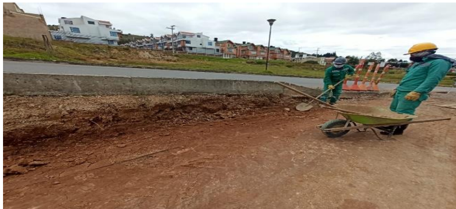
Figura 8. Limpieza y remoción de material
