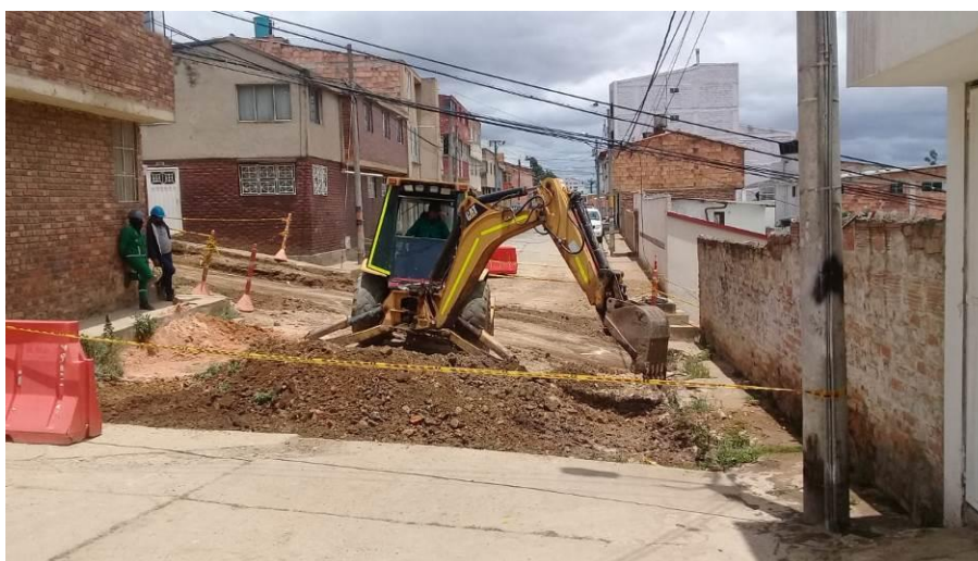
Figura 52. Excavación bocacalle Cra12a Sentido Sur-Norte
