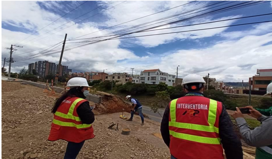
Figura 37. Densidades muro en tierra armada
