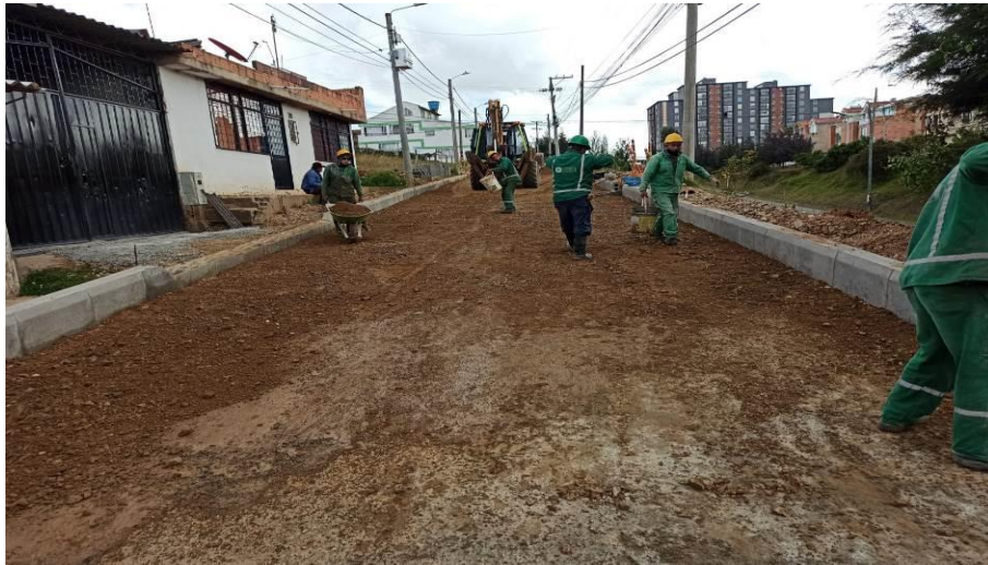
Figura 33. Instalación de Subbase
