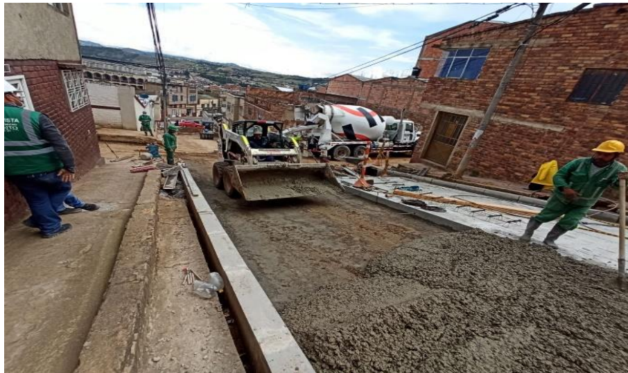
Figura 70. Fundida de concreto carril izquierdo
