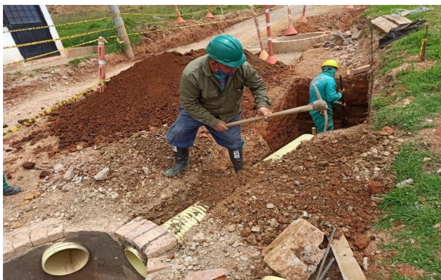
Figura 24. Ubicación tubería con sumidero
