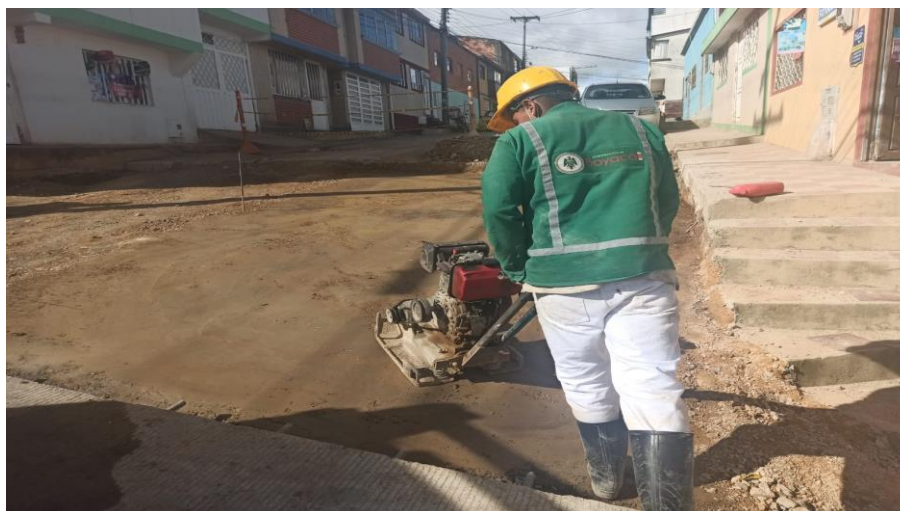
Figura 63. Compactación Bocacalle Cra 13 sentido Norte-Sur
