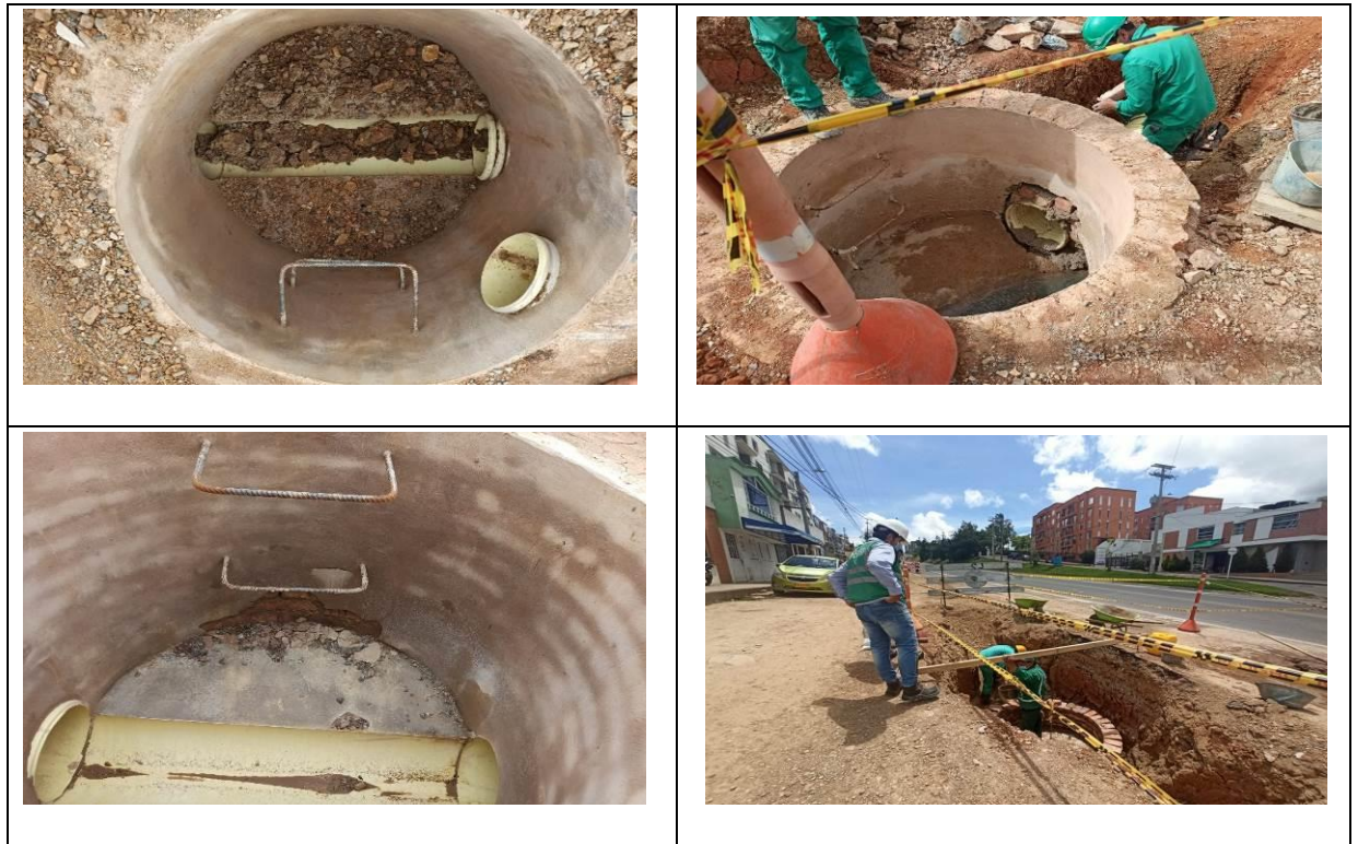
Figura 21. Arreglos y nivelación de pozo
