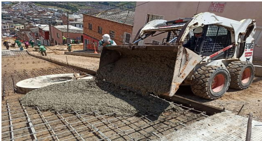
Figura 66. Descargue de la mezcla con minicargador
