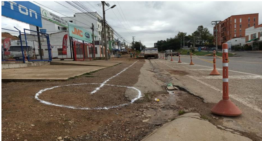
Figura 5. Comienzo tramo frente de obra barrio manantial
