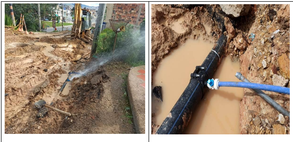
Figura 20. Arreglo collarín red de acueducto
