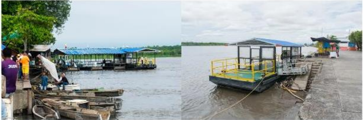
Figura 66. Estructura que se utiliza como muelle para el transporte acuático en Barrancabermeja, 2018
