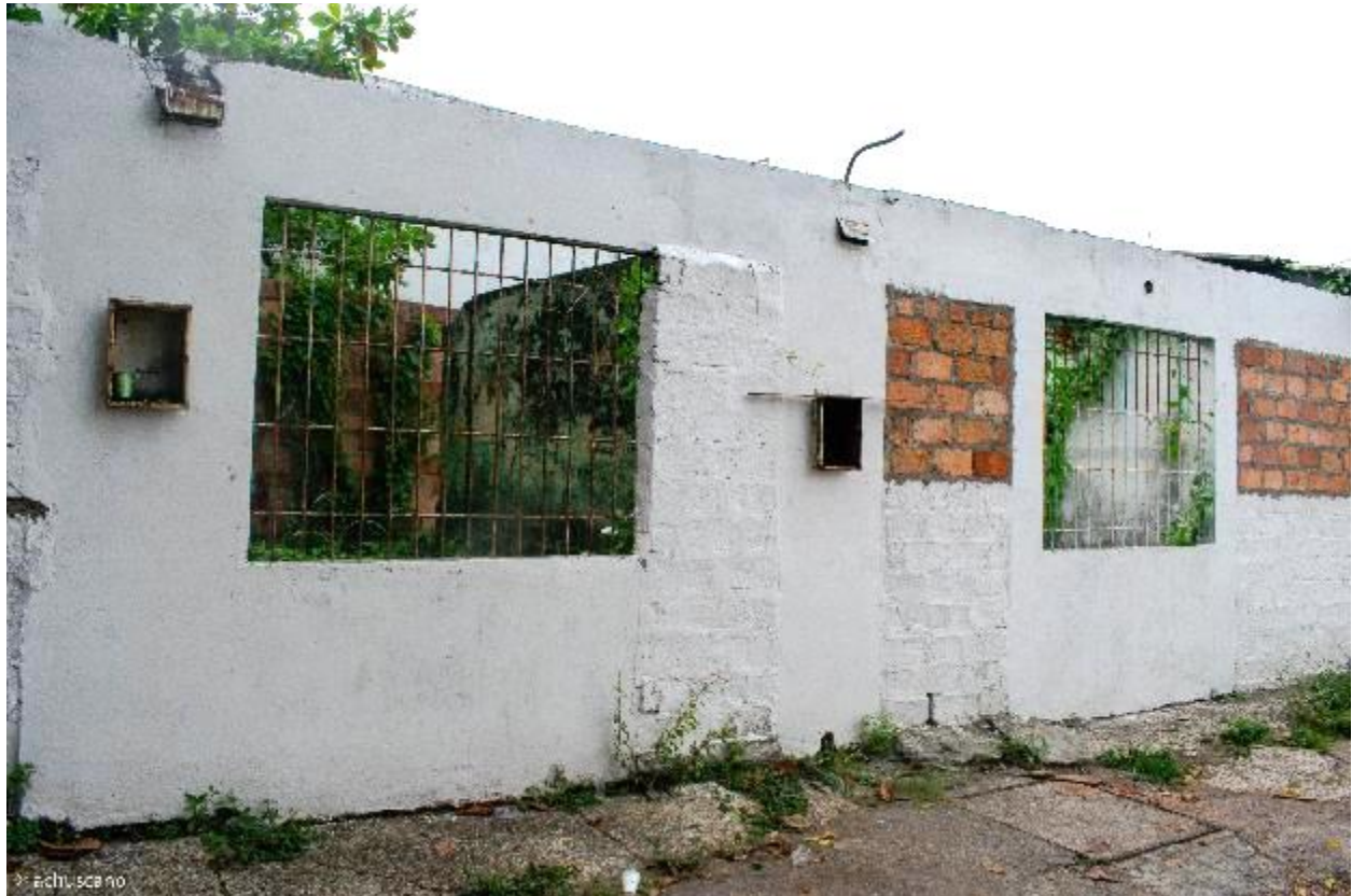
Figura 62. Ejemplo de edificación vacía con potencial uso de vivienda, 2018
