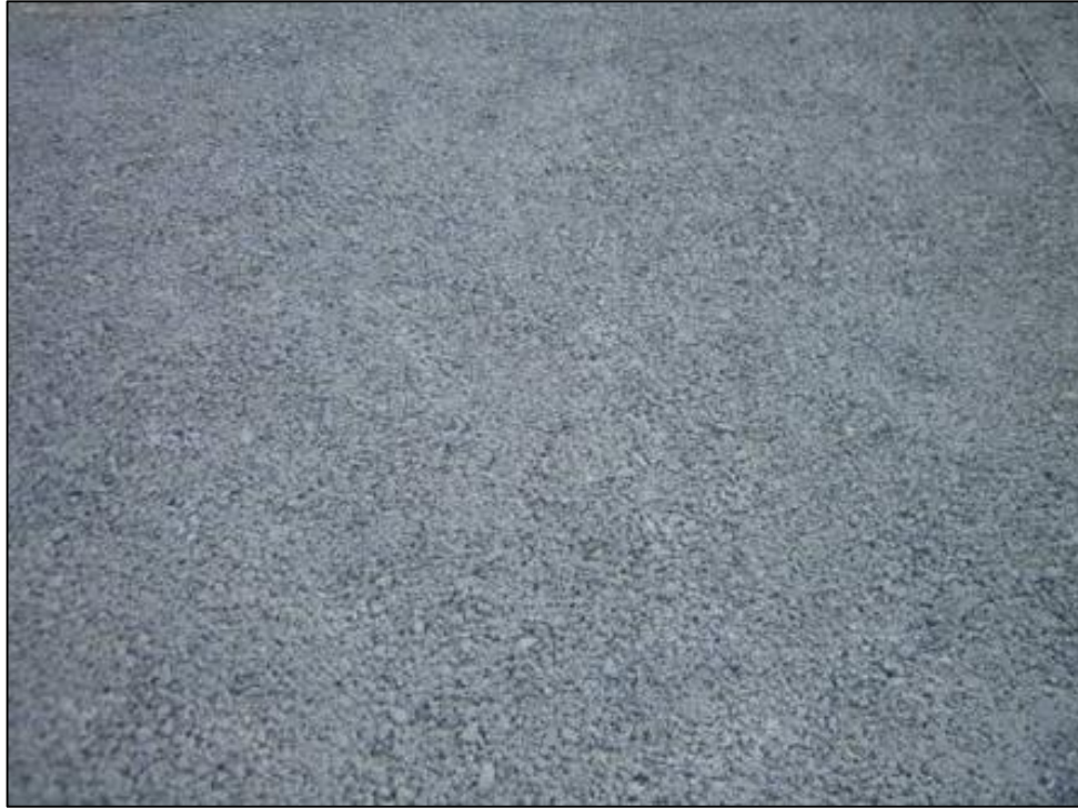
Figura 8 Hormigón poroso hidráulico, aparcamiento experimental del Parque de las Llamas, Santander
