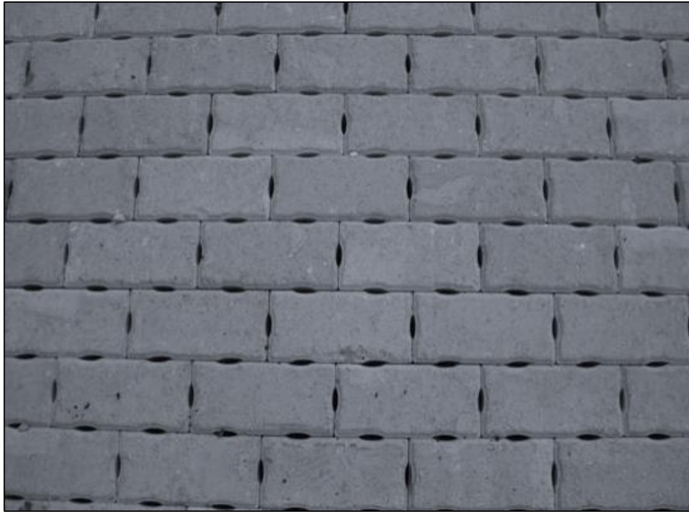
Figura 6 Adoquines de Bloques Montserrat con ranuras libres, aparcamiento experimental del Parque de las Llamas, Santander.
