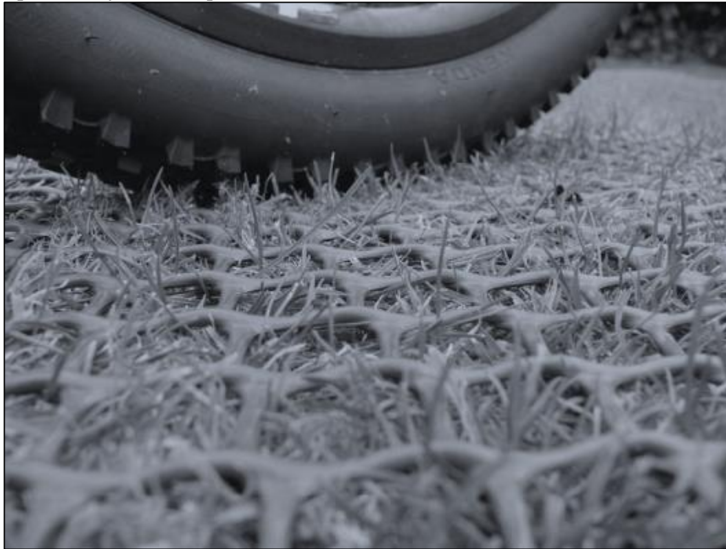
Figura 5 Césped con refuerzos de plástico
