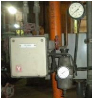
Imagen 88 Transmisor de flujo neumático unidad 1 Termopaipa.
