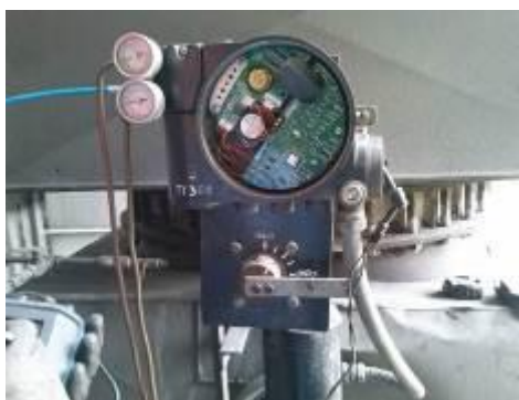
Imagen 111 Posicionador electrónico damper de aire caliente
