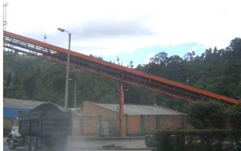
Imagen 92 Banda transportadora de carbón T24 Termopaipa
