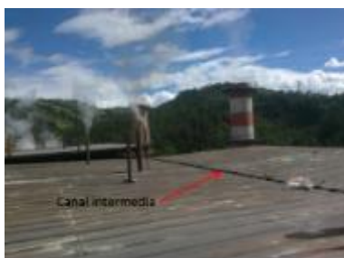
Fotografía 1. Vista general techo caldera
