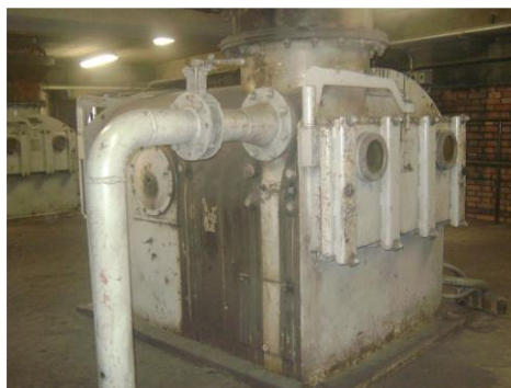
Imagen 93 Alimentador de carbón Termopaipa
