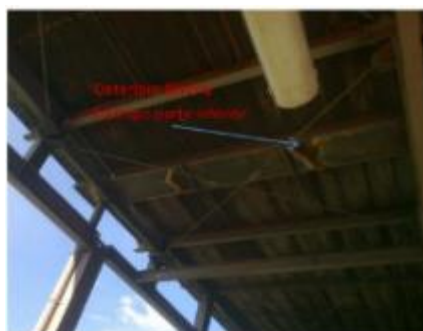
Fotografía 3. Vista inferior techo caldera
