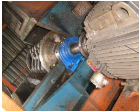
Imagen 91 Triturador de carbón con martillos a la vista Termopaipa.
