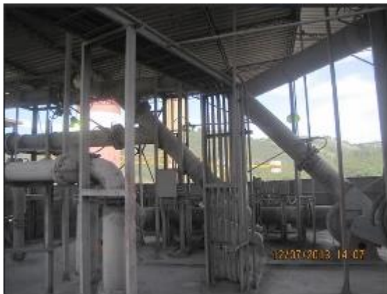
Imagen 7 Techo de silo de ceniza Termopaipa
