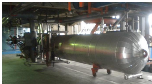
Imagen 75 Recalentador R2 Termopaipa
