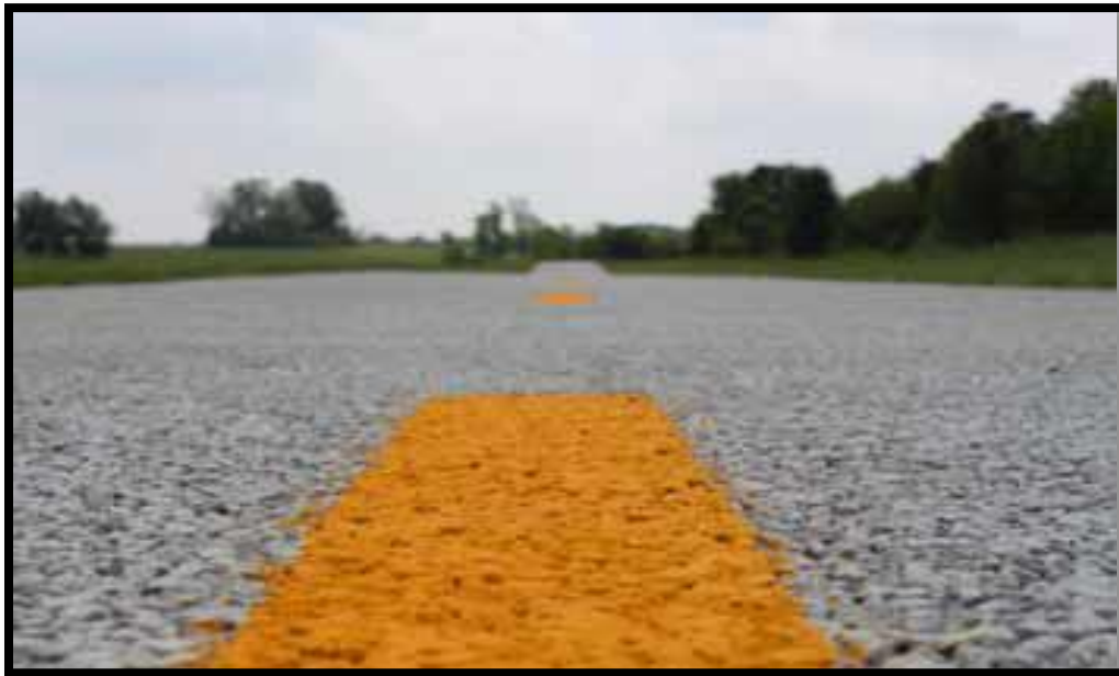
Ilustración 8. Concreto permeable empleado para la construcción de una parte del Legacy Trail en Coldstream Park en Lexington, Ky
