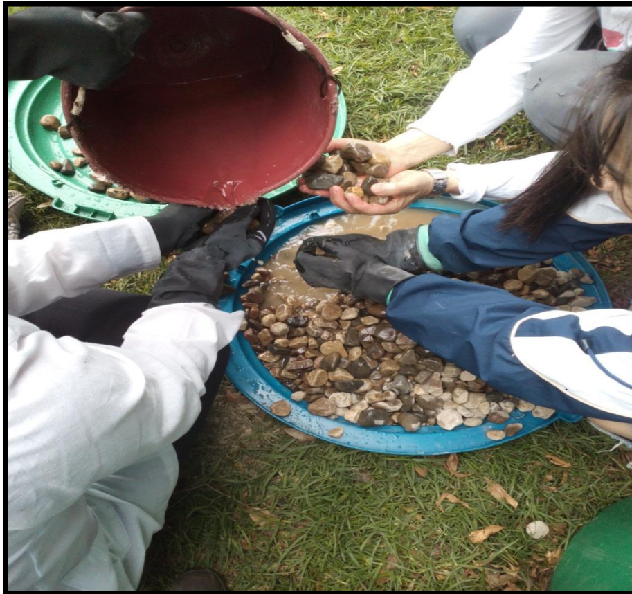
Ilustración 17. Lavado de la grava previo a su montaje
