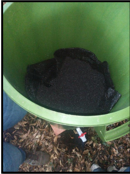
Ilustración 19. Montaje capa de material filtrante
