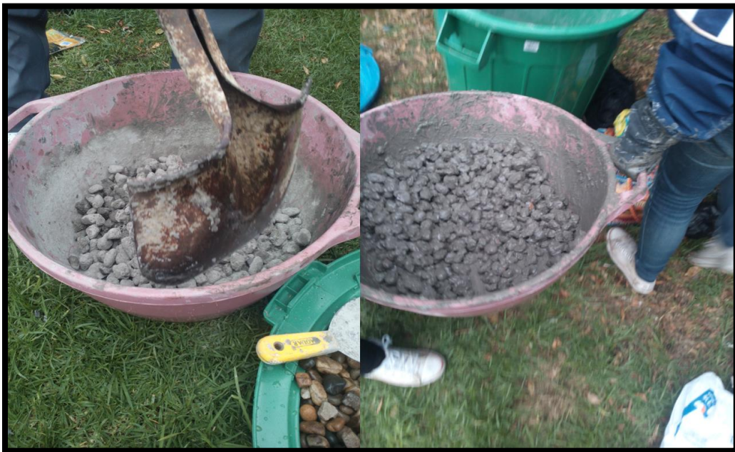
Ilustración 20. Elaboración capa de concreto poroso
