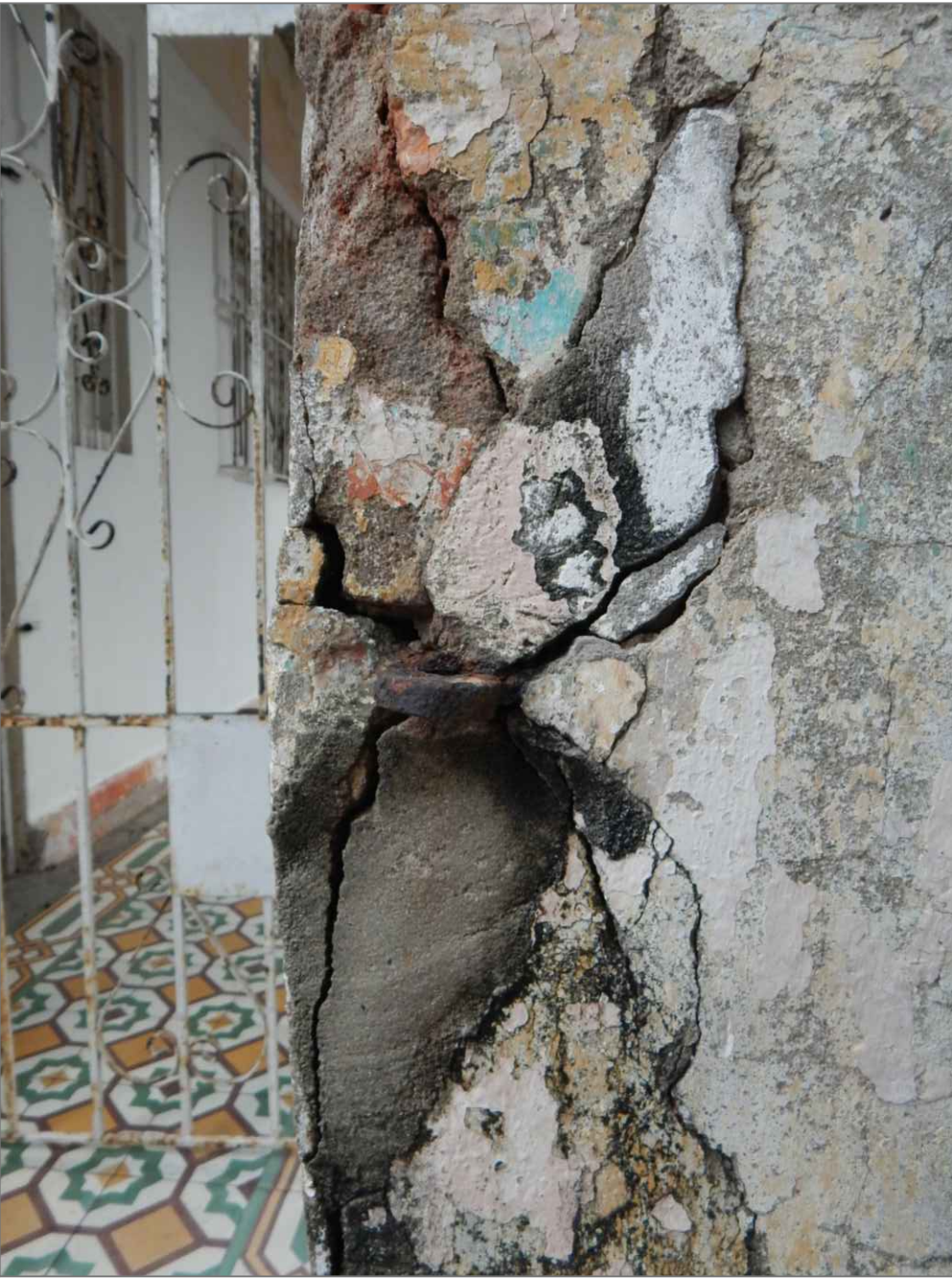
IMÁGENES 7 Y 8: MUROS CON HUMEDAD ASCENDENTE, DESPRENDIMIENTOS DE RECUBRIMIENTO Y COLUMNA CON ROTURA Y DEFORMACIÓN.
