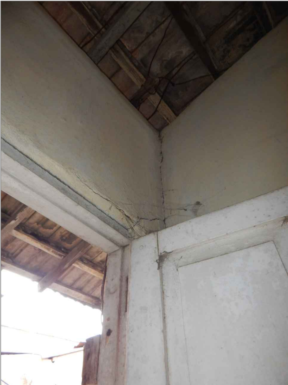
IMÁGENES, 8 Y 9: GRIETAS QUE EVIDENCIAN FALENCIAS EN ELEMENTOS PARA RESISTIR MOMENTOS. ASÍ MISMO SE EVIDENCIAN FALLAS EN EL PROCESO CONSTRUCTIVO POR OMISIÓN DE TRABAS EN MURO (GRIETAS VERTICALES EN ESQUINAS) Y OMISIÓN DE ELEMENTO ESTRUCTURAL QUE DISTRIBUYA EL PESO DE LA CUBIERTA.
