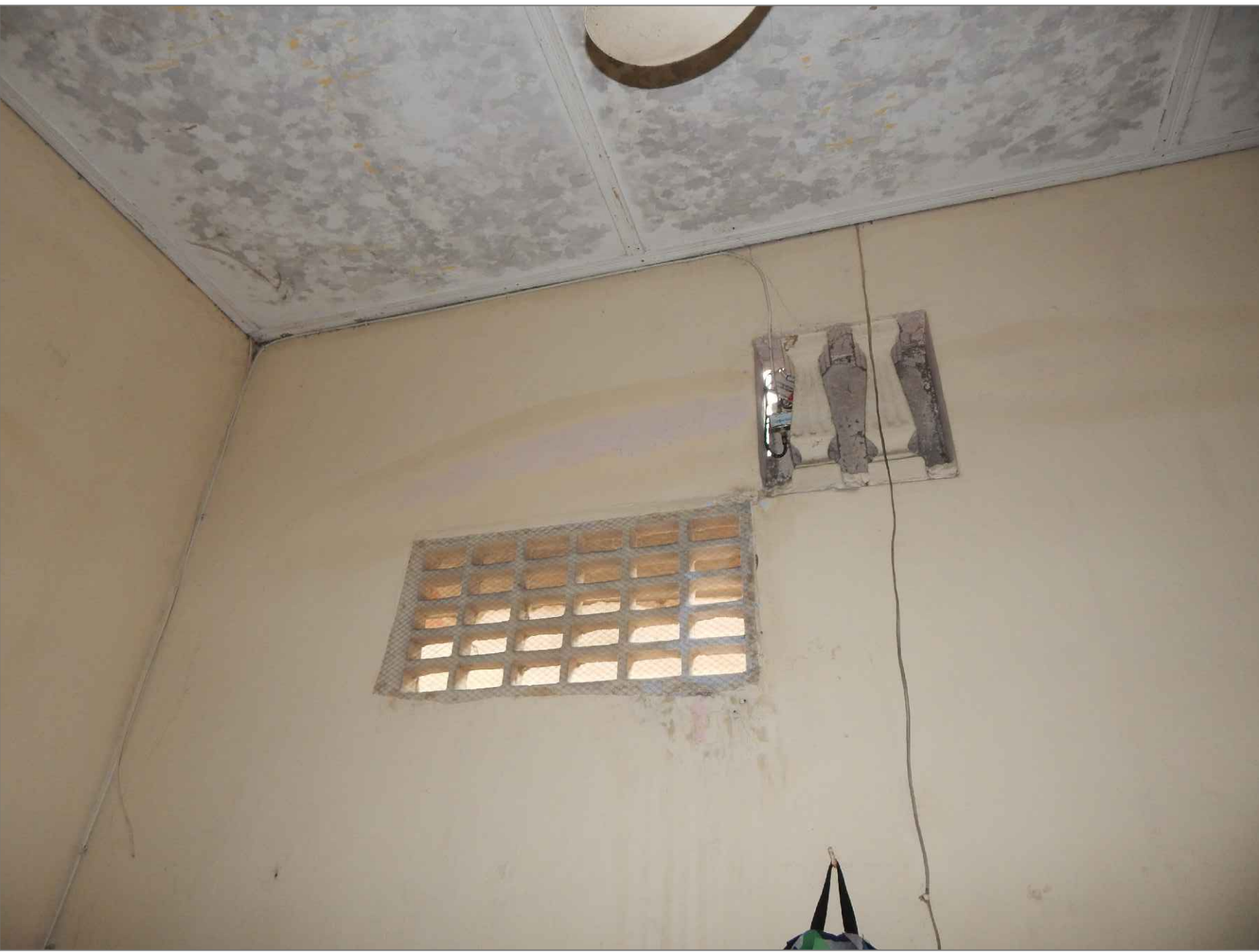
IMÁGENES N 4 Y 5: HUMEDADES EN MUROS (LATERAL) Y CIELO RASO (POR FILTRACIÓN), QUE HAN GENERADO ABOMBAMIENTO Y DESPRENDIMIENTO DE PINTURA DE RECUBRIMIENTO, CON APARICIÓN DE EFLORESCENCIAS Y LÍQUENES.
