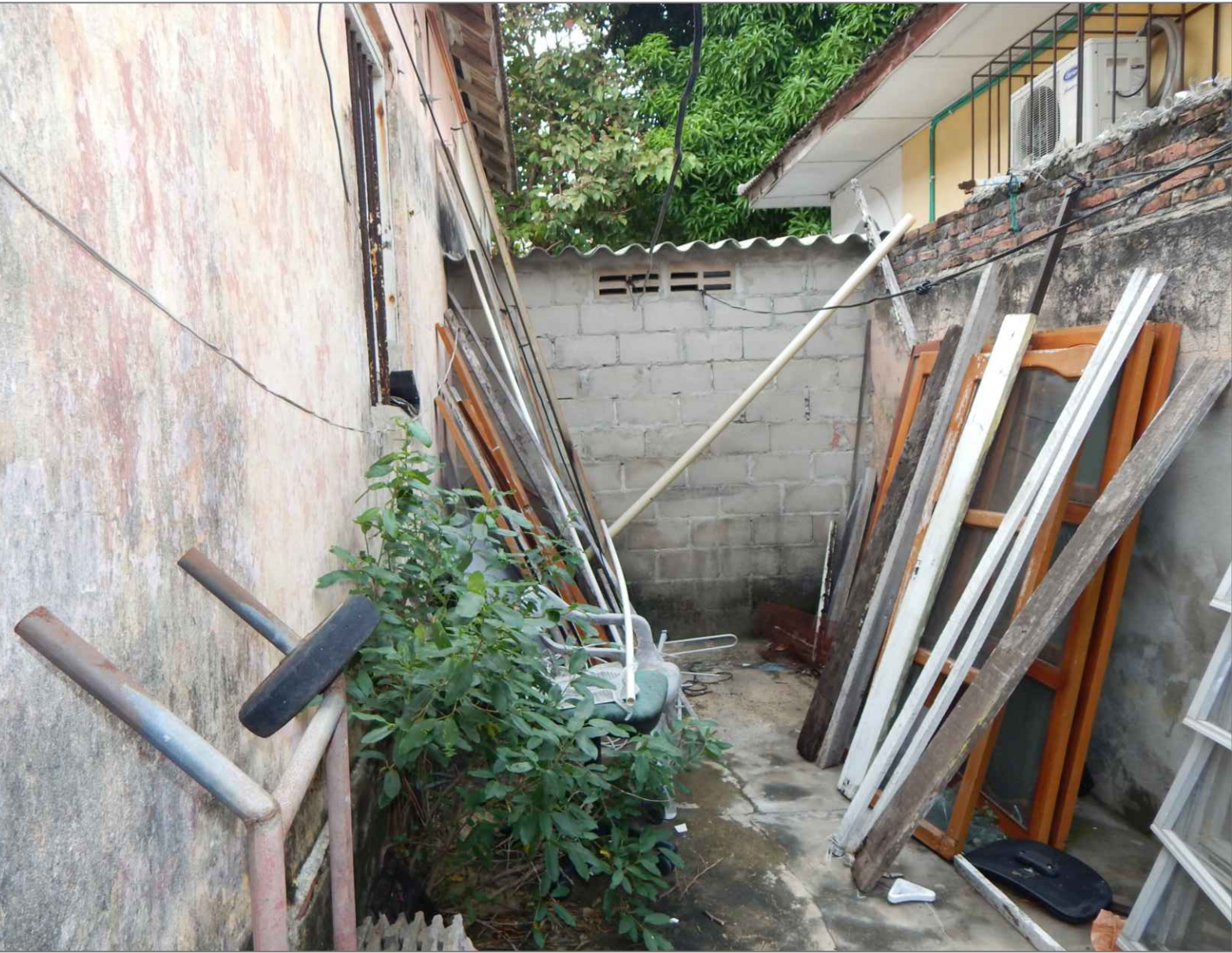
IMÁGENES 3, 4 Y 5: LA ZONA DE LABORES PRESENTA HUMEDADES, DESPRENDIMIENTOS, HONGOS, MOHOS, EFLORESCENCIAS Y LÍQUENES; TANTO EN EL RECUBRIMIENTO DE PISO COMO EN MUROS Y CUBIERTA. CON PRESENCIA DE VEGETACIÓN EPIFITA.
