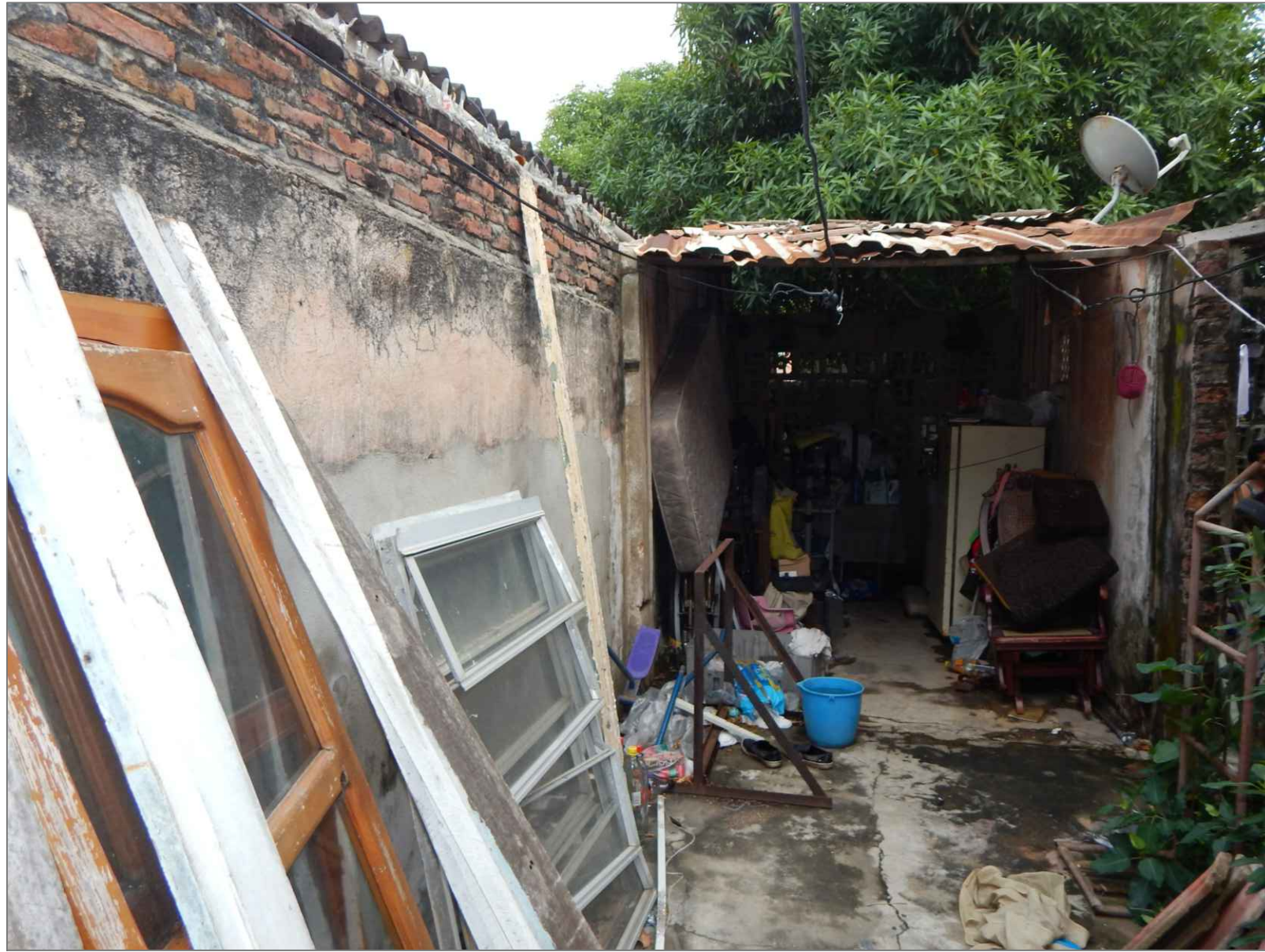
IMÁGENES 3, 4 Y 5: LA ZONA DE LABORES PRESENTA HUMEDADES, DESPRENDIMIENTOS, HONGOS, MOHOS, EFLORESCENCIAS Y LÍQUENES; TANTO EN EL RECUBRIMIENTO DE PISO COMO EN MUROS Y CUBIERTA. CON PRESENCIA DE VEGETACIÓN EPIFITA.
