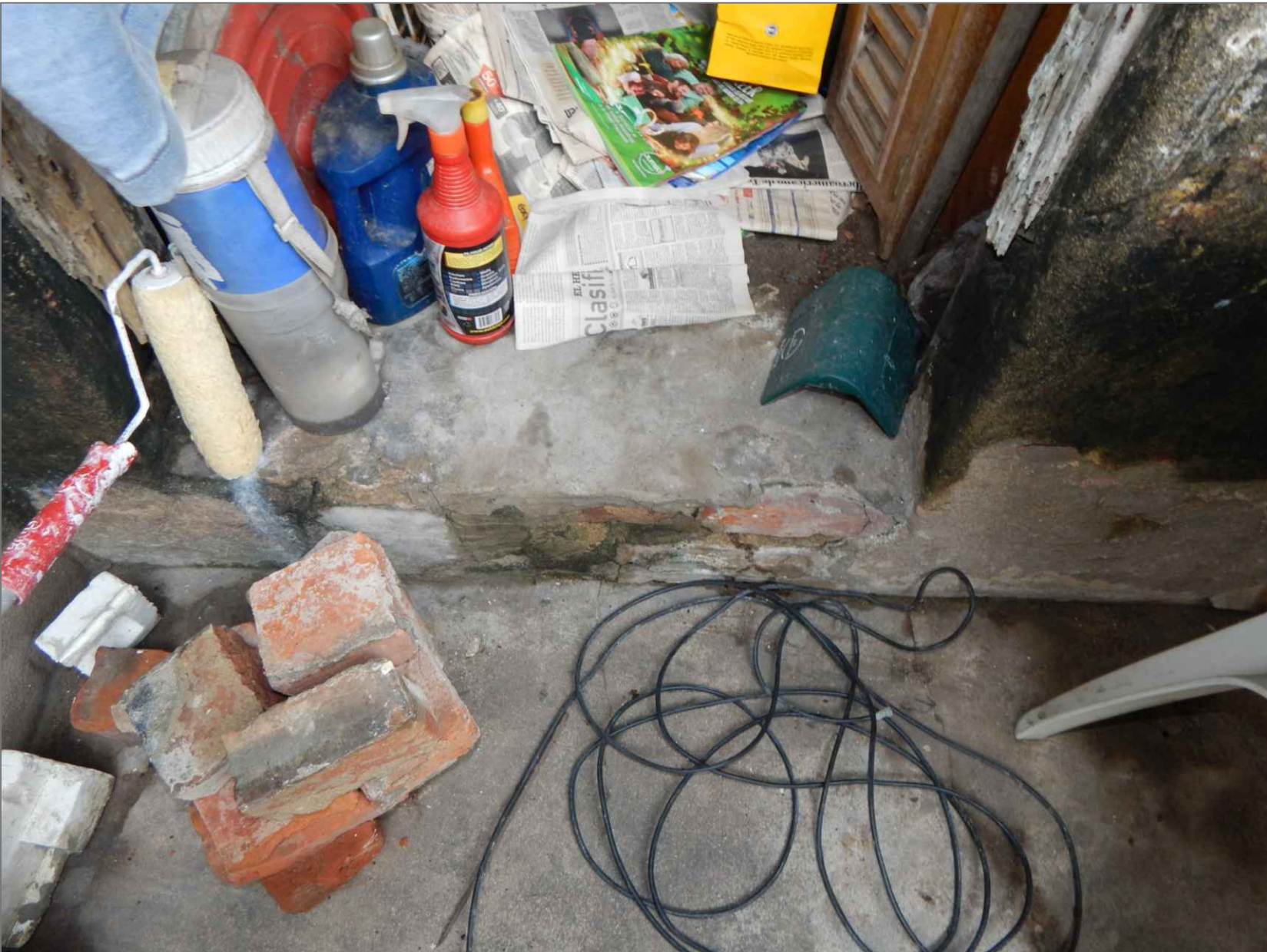
IMÁGENES 4, 5 Y 6: PISO EN PLANTILLA DE CONCRETO PULIDO CON EROSIÓN Y HUMEDAD GENERALIZADA, ASÍ MISMO LOS MUROS PRESENTAN HUMEDAD POR ABSORCIÓN LATERAL Y FISURAS VERTICALES POR FALLAS EN UNIONES DE MURO.
