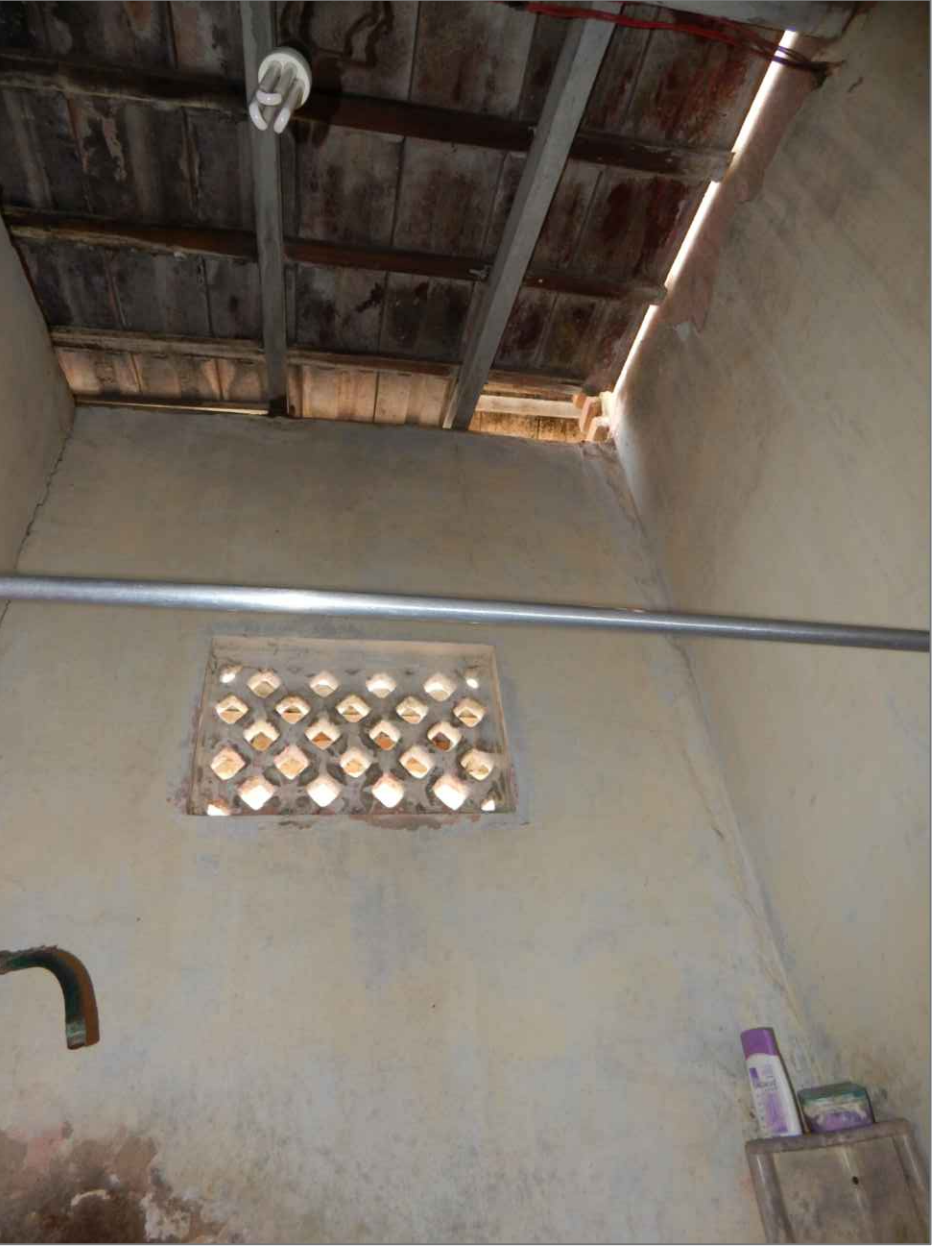
IMÁGENES N 4, 5 Y 6: EL ESPACIO PRESENTA HUMEDAD GENERALIZADA, LA PLANTILLA EN CONCRETO PULIDO EVIDENCIA EROSIÓN Y HONGOS; LOS MUROS, CUYO RECUBRIMIENTO ES EN PINTURA Y PAÑETE PRESENTA LAVADO DE PINTURA, DESPRENDIMIENTO, HONGOS Y MOHO.
