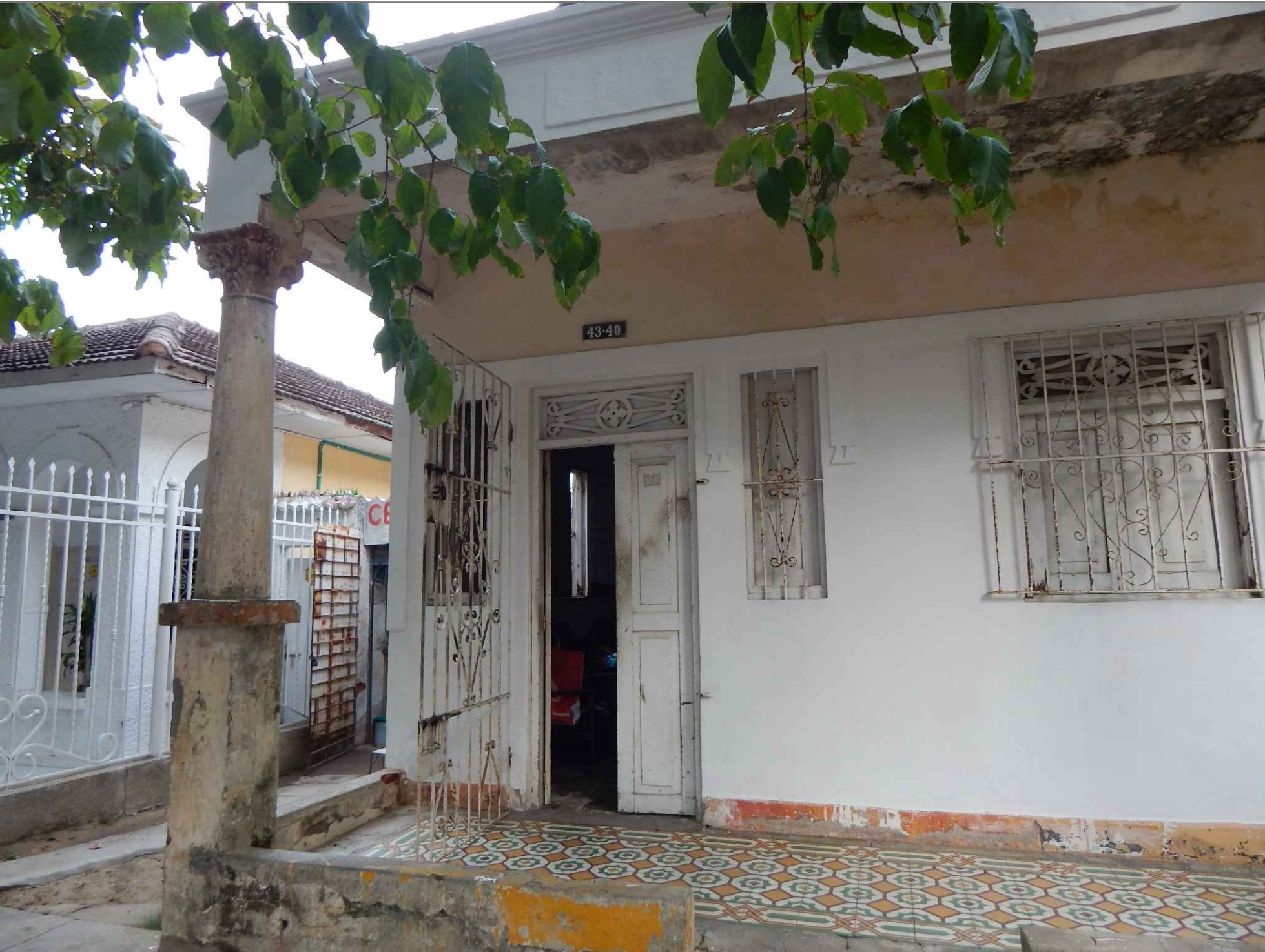
IMAGEN N° 3: VISTA GENERAL DEL ESPACIO
