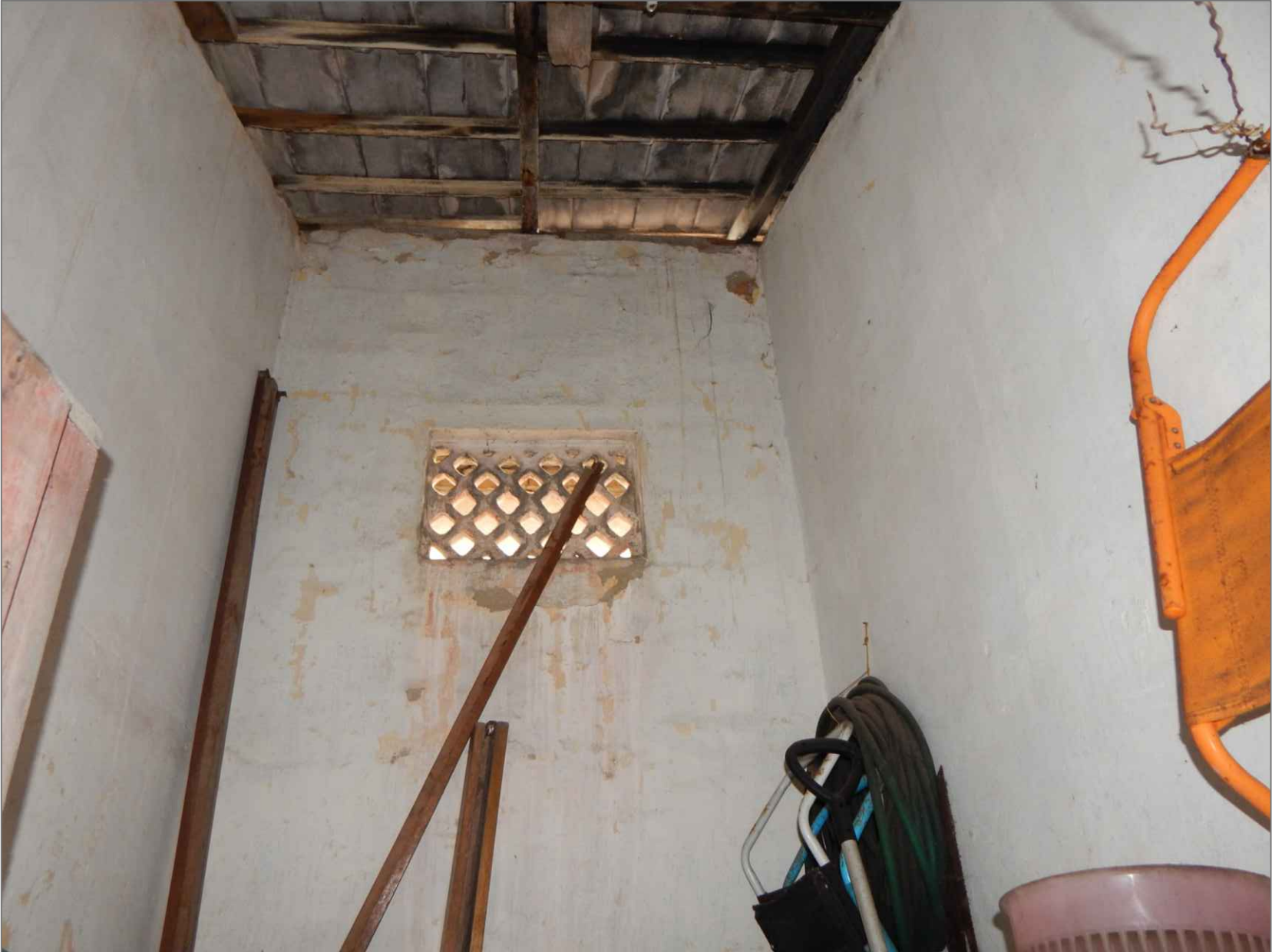
IMÁGENES 4, 5 Y 6: PISO EN PLANTILLA DE CONCRETO PULIDO CON EROSIÓN Y HUMEDAD GENERALIZADA, ASÍ MISMO LOS MUROS PRESENTAN HUMEDAD POR ABSORCIÓN LATERAL Y FISURAS VERTICALES POR FALLAS EN UNIONES DE MURO.
