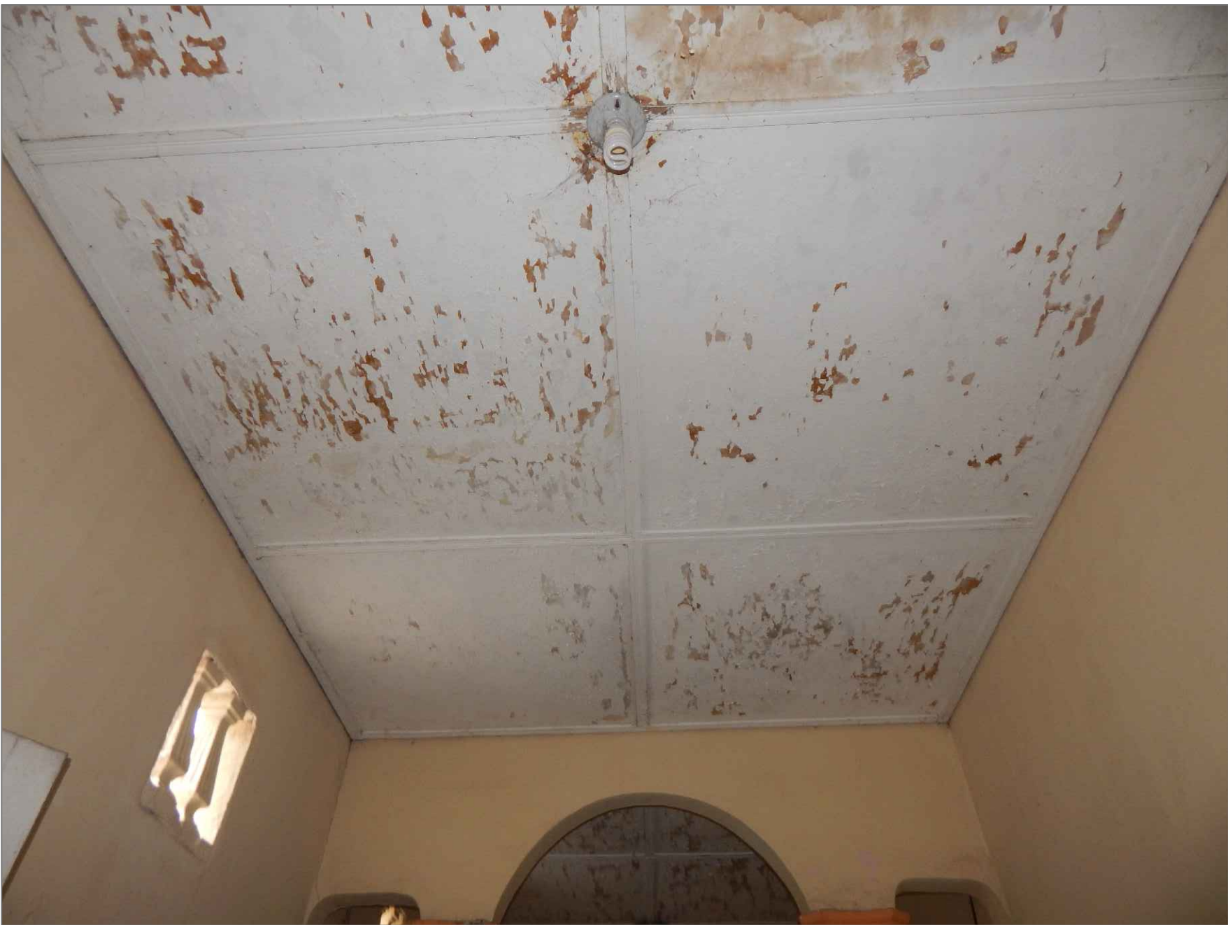
IMÁGENES N 7 Y 8: ESTADO DE CIELO RASO EN LÁMINA DE ASBESTO CEMENTO, CON AFECTACIÓN POR HUMEDAD POR FILTRACIÓN QUE HA GENERADO ABOMBAMIENTO Y DESPRENDIMIENTO DE PINTURA DE RECUBRIMIENTO. ESTA HUMEDAD GENERÓ UN MICROCLIMA QUE PROPICIÓ LA PROLIFERACIÓN DE COMUNIDADES BIOLÓGICAS QUE SE EVIDENCIAN EN MANCHAS PARDAS.
