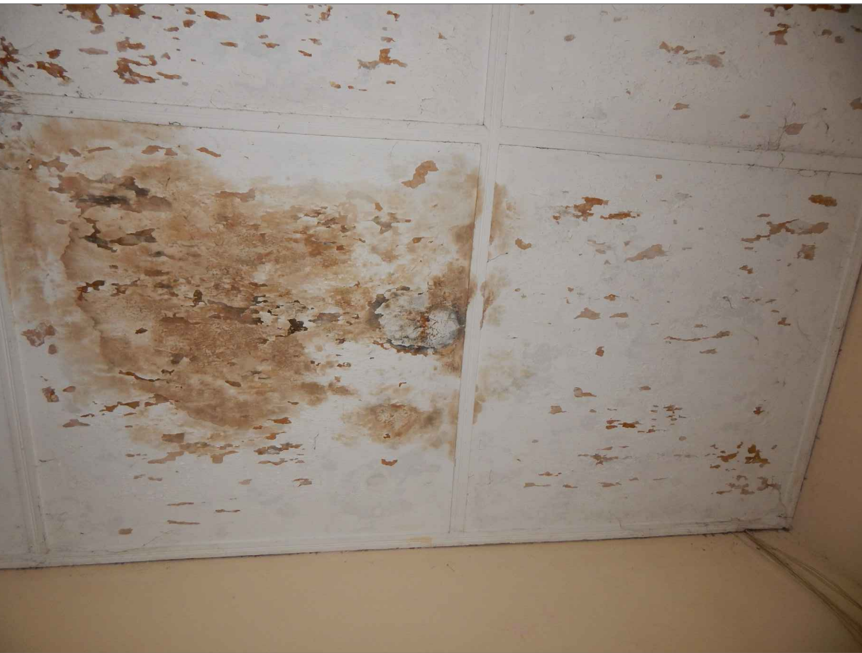
IMÁGENES N 7 Y 8: ESTADO DE CIELO RASO EN LÁMINA DE ASBESTO CEMENTO, CON AFECTACIÓN POR HUMEDAD POR FILTRACIÓN QUE HA GENERADO ABOMBAMIENTO Y DESPRENDIMIENTO DE PINTURA DE RECUBRIMIENTO. ESTA HUMEDAD GENERÓ UN MICROCLIMA QUE PROPICIÓ LA PROLIFERACIÓN DE COMUNIDADES BIOLÓGICAS QUE SE EVIDENCIAN EN MANCHAS PARDAS.
