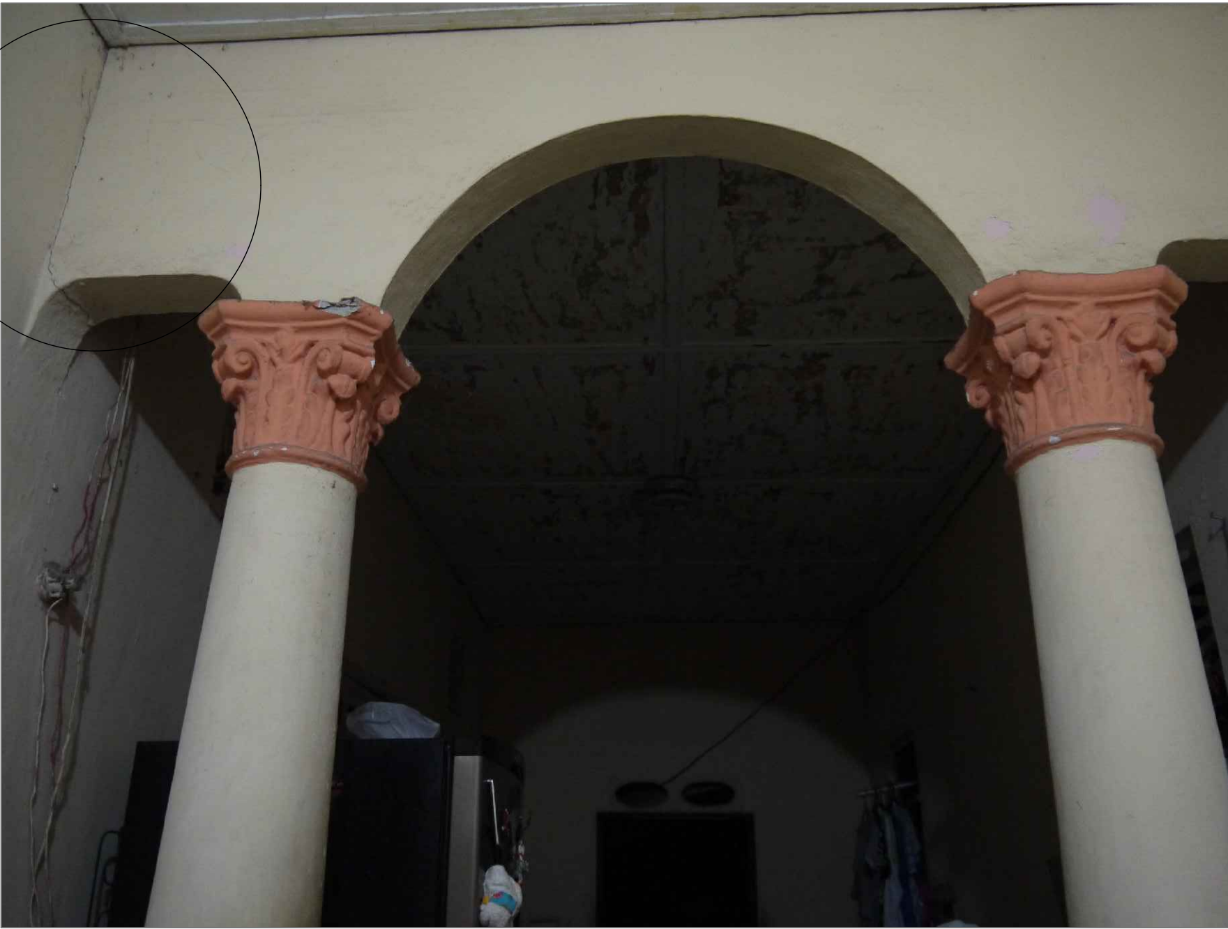
IMÁGENES 4, 5 Y 6: ESTADO GENERAL DEL ESPACIO, CON ROTURA EN CAPITULES DE COLUMNAS, GRIETA VERTICAL POR FALLA DE TRASLAPO EN UNIÓN DE MURO PERIMETRAL CON ARCO REBAJADO Y BUEN ESTADO DE RECUBRIMIENTO DE PISO.
