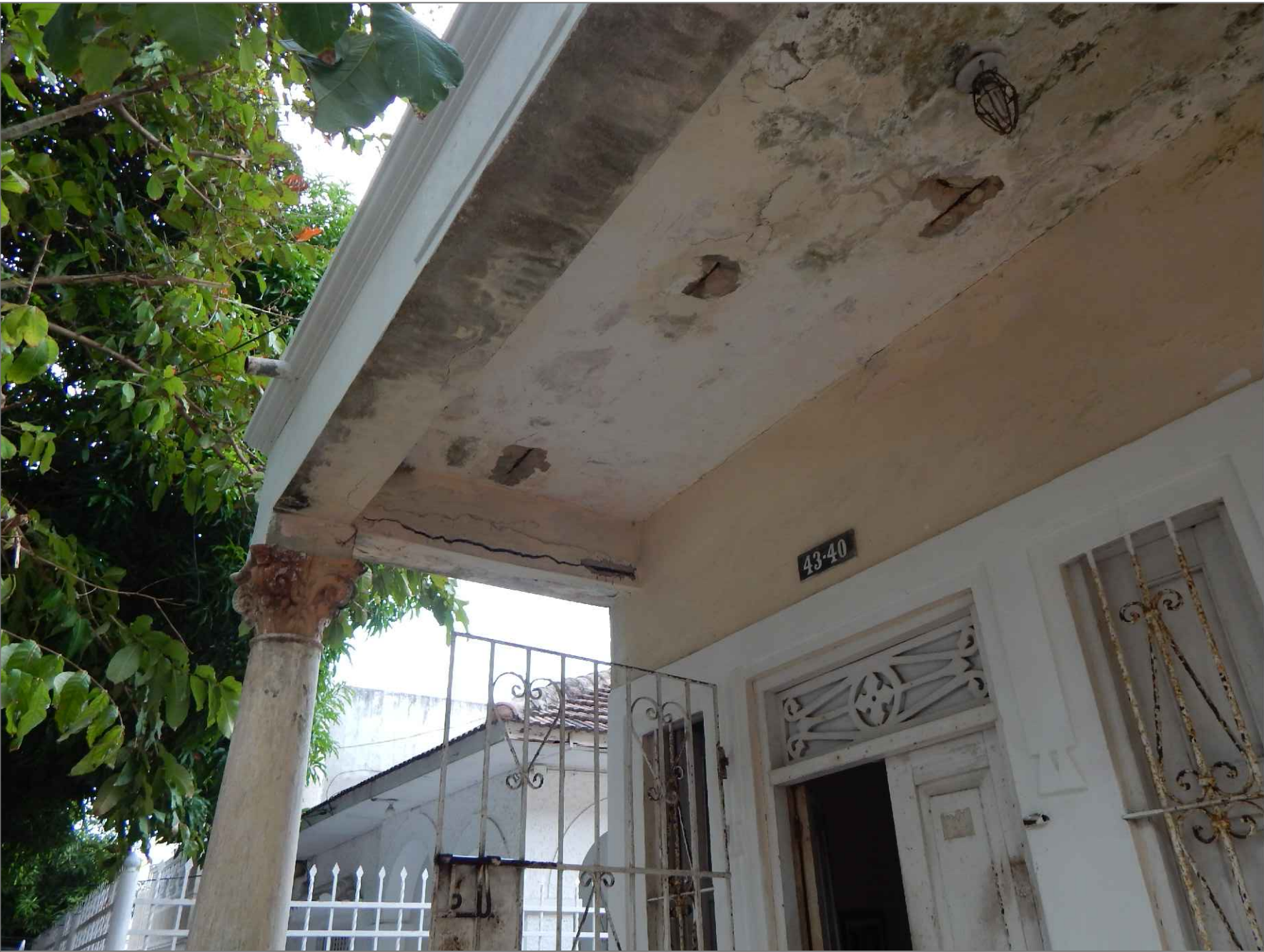
IMÁGENES N° 4, 5 Y 6: PLACA DE CUBIERTA CON AFECTACIÓN GENERALIZADA POR HUMEDAD DE FILTRACIÓN QUE HA GENERADO CARBONATACIÓN DEL ELEMENTO CON PROLIFERACIÓN DE COMUNIDADES BIOLÓGICAS. CARPINTERIA EN MADERA PARA PUERTA DOBLE DE ACCESO Y VENTANAS, CON PRESENCIA DE REJAS EN HIERRO FORJADO.
