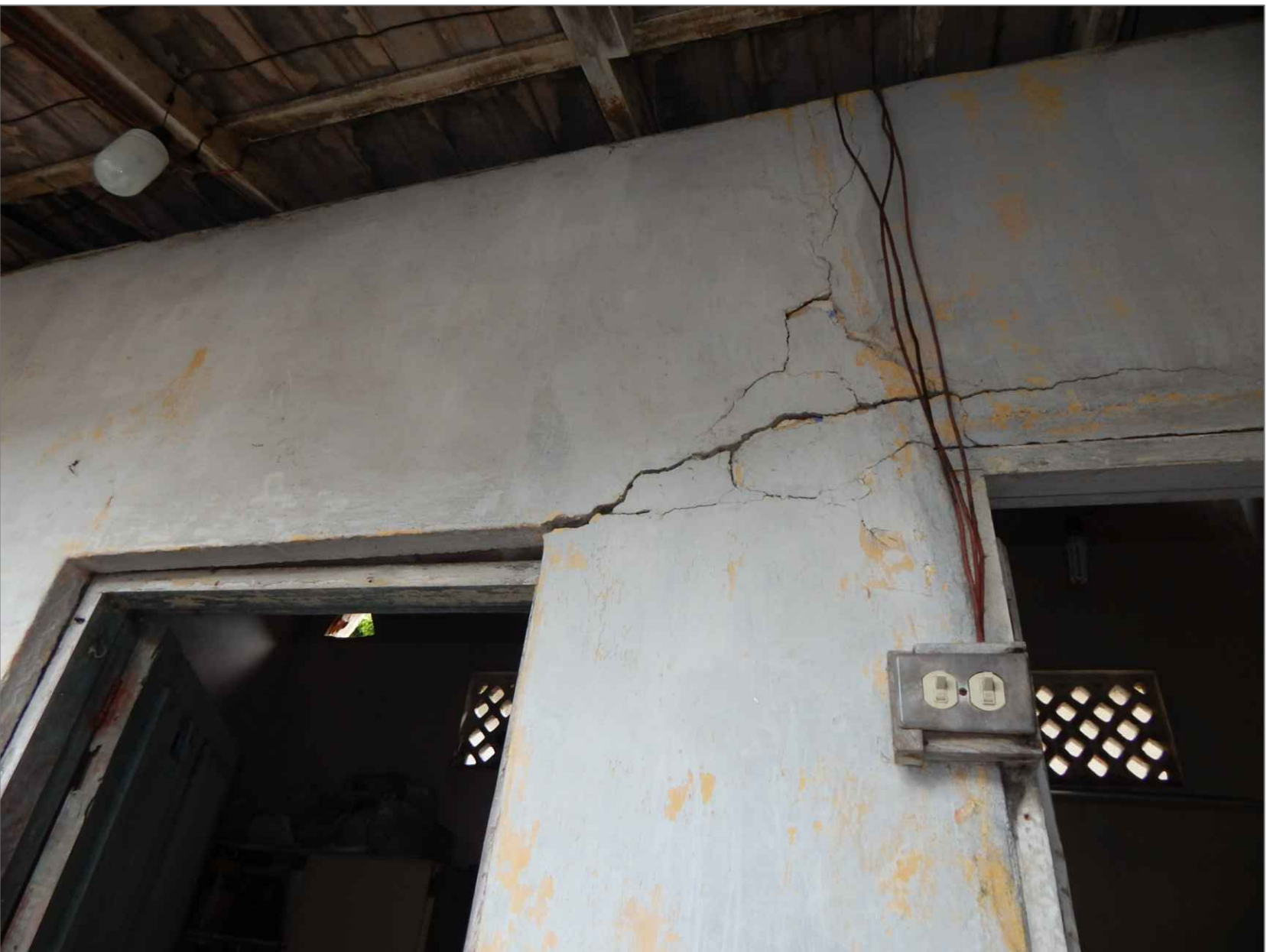
IMÁGENES, 8 Y 9: GRIETAS QUE EVIDENCIAN FALENCIAS EN ELEMENTOS PARA RESISTIR MOMENTOS. ASÍ MISMO SE EVIDENCIAN FALLAS EN EL PROCESO CONSTRUCTIVO POR OMISIÓN DE TRABAS EN MURO (GRIETAS VERTICALES EN ESQUINAS) Y OMISIÓN DE ELEMENTO ESTRUCTURAL QUE DISTRIBUYA EL PESO DE LA CUBIERTA.
