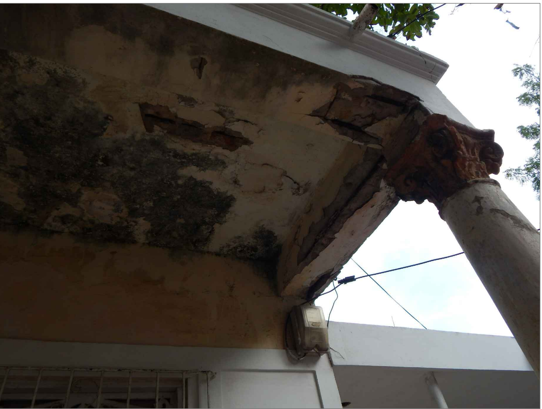
IMÁGENES N° 4, 5 Y 6: PLACA DE CUBIERTA CON AFECTACIÓN GENERALIZADA POR HUMEDAD DE FILTRACIÓN QUE HA GENERADO CARBONATACIÓN DEL ELEMENTO CON PROLIFERACIÓN DE COMUNIDADES BIOLÓGICAS. CARPINTERIA EN MADERA PARA PUERTA DOBLE DE ACCESO Y VENTANAS, CON PRESENCIA DE REJAS EN HIERRO FORJADO.
