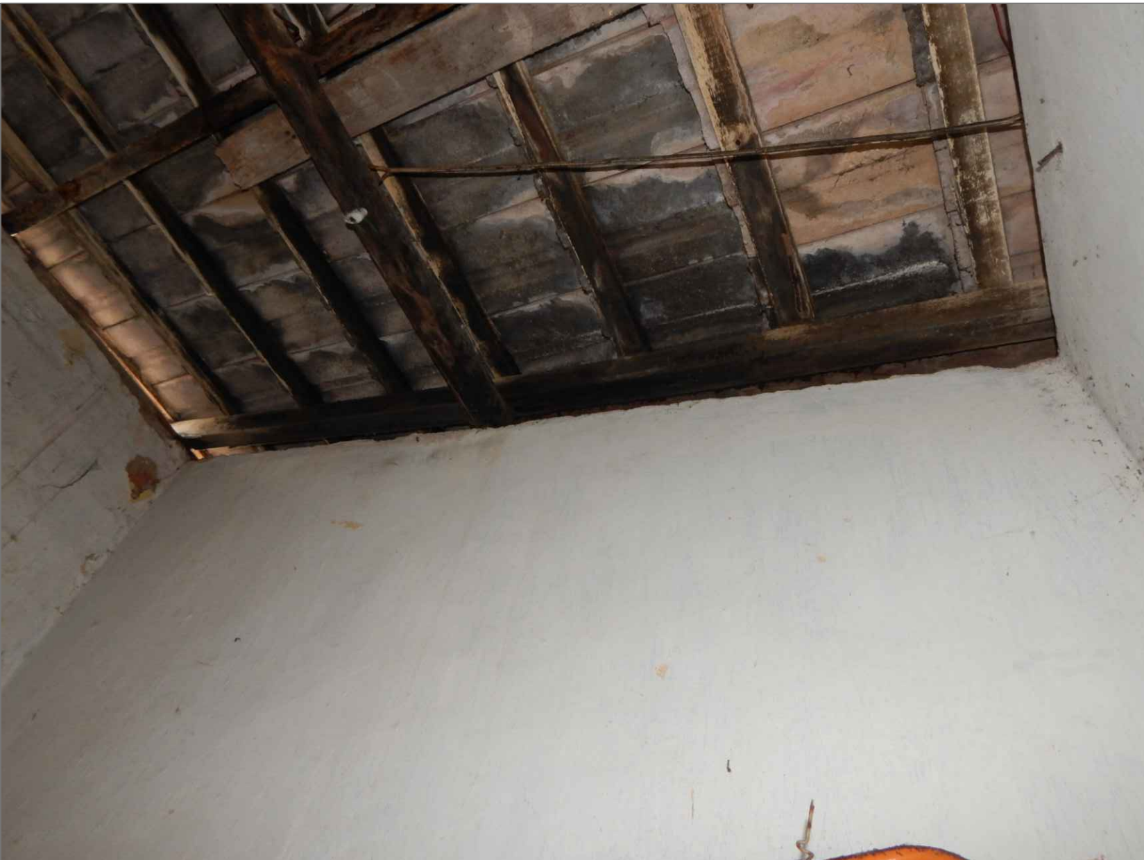
IMÁGENES 7 Y 8: LAVADO DIFERENCIAL EN MURO POR FILTRACIÓN, ESTRUCTURA DE MADERA DE CUBIERTA CON HUMEDAD Y AFECTACIONES BIOLÓGICAS. TEJAS DE CEMENTO CON LESIONES DE MOHO Y LÍQUENES.
