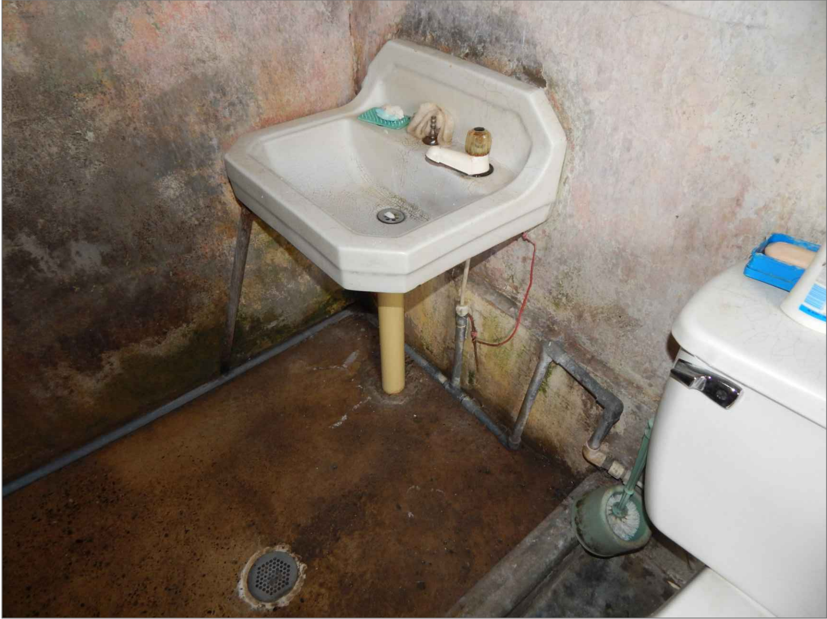
IMÁGENES N 4, 5 Y 6: EL ESPACIO PRESENTA HUMEDAD GENERALIZADA, LA PLANTILLA EN CONCRETO PULIDO EVIDENCIA EROSIÓN Y HONGOS; LOS MUROS, CUYO RECUBRIMIENTO ES EN PINTURA Y PAÑETE PRESENTA LAVADO DE PINTURA, DESPRENDIMIENTO, HONGOS Y MOHO.
