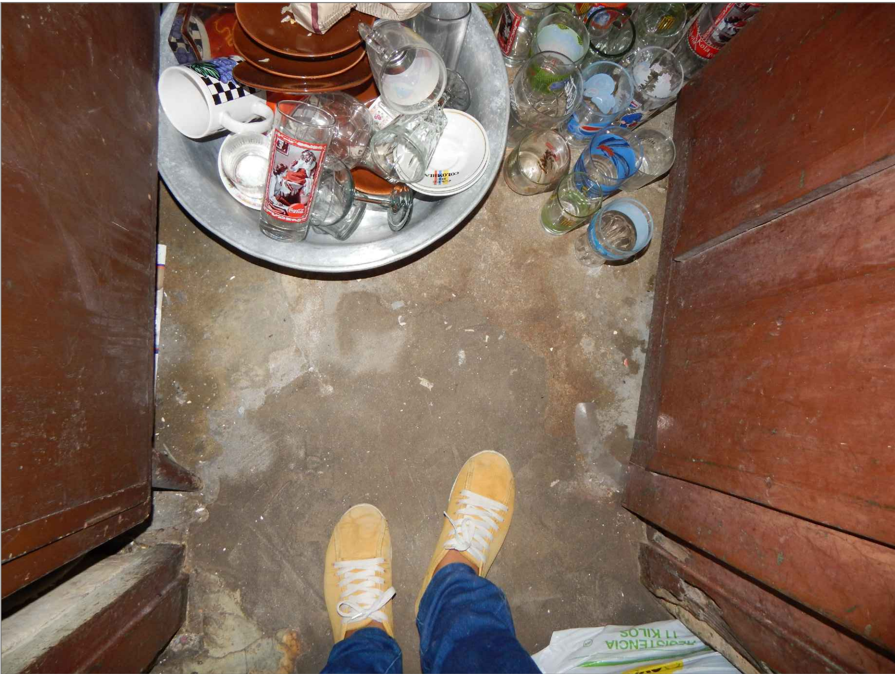
IMAGEN N° 6: IMÁGENES 6 Y 7: RECUBRIMIENTO DE PISO CON DESGASTE Y EROSIÓN GENERALIZADOS, QUE INCLUYEN GRANDES PÉRDIDAS DE MATERIAL CEMENTICIO.
