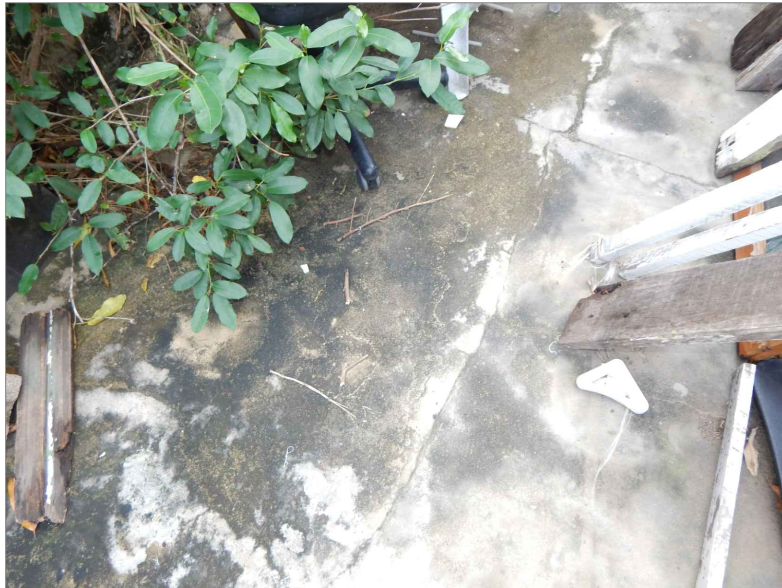
IMÁGENES 6, 7 Y 8: ROTURA EN PLANTILLA DE PISO, CON GRIETAS, VEGETACIÓN EPIFITA, PROLIFERACIÓN DE COMUNIDADES BIOLÓGICAS Y HUNDIMIENTOS. MURO CON ALABEO Y GRIETAS TIPO MAPEO, CON DEFORMACIÓN EN PARTE INFERIOR Y ROTURA IMPROVISADA DE MURO PARA VANO DE ACCESO.
