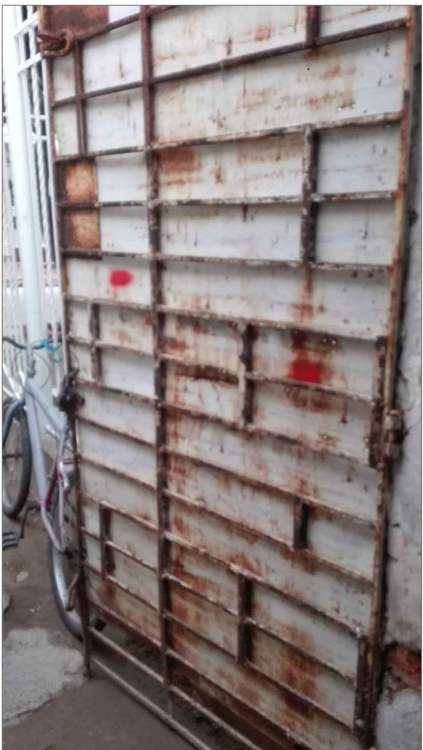
IMÁGENES 6 Y 7: CARPINTERÍA METÁLICA PARA PUERTA DE ACCESO A LOCAL CON CORROSIÓN GENERALIZADA. PLANTILLA EN CONCRETO DE RECUBRIMIENTO DE PISO TIPO PASARELA DE ACCESO A LOCAL CON ROTURAS Y DESPRENDIMIENTO DE M A T E R I A L C E M E N T I C I O .
