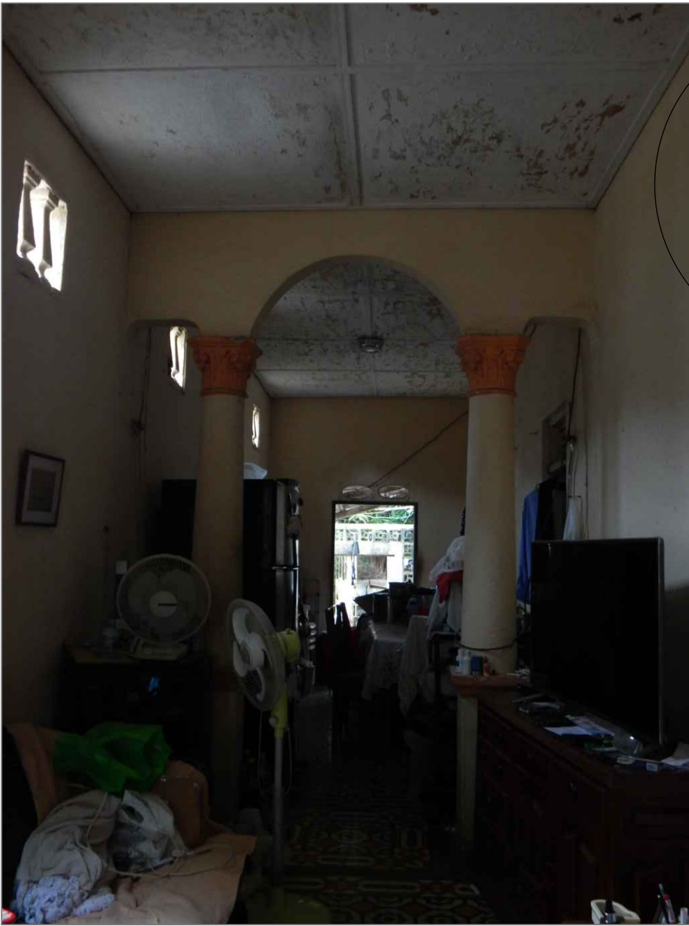
IMÁGENES 4, 5 Y 6: ESTADO GENERAL DEL ESPACIO, CON ROTURA EN CAPITULES DE COLUMNAS, GRIETA VERTICAL POR FALLA DE TRASLAPO EN UNIÓN DE MURO PERIMETRAL CON ARCO REBAJADO Y BUEN ESTADO DE RECUBRIMIENTO DE PISO.
