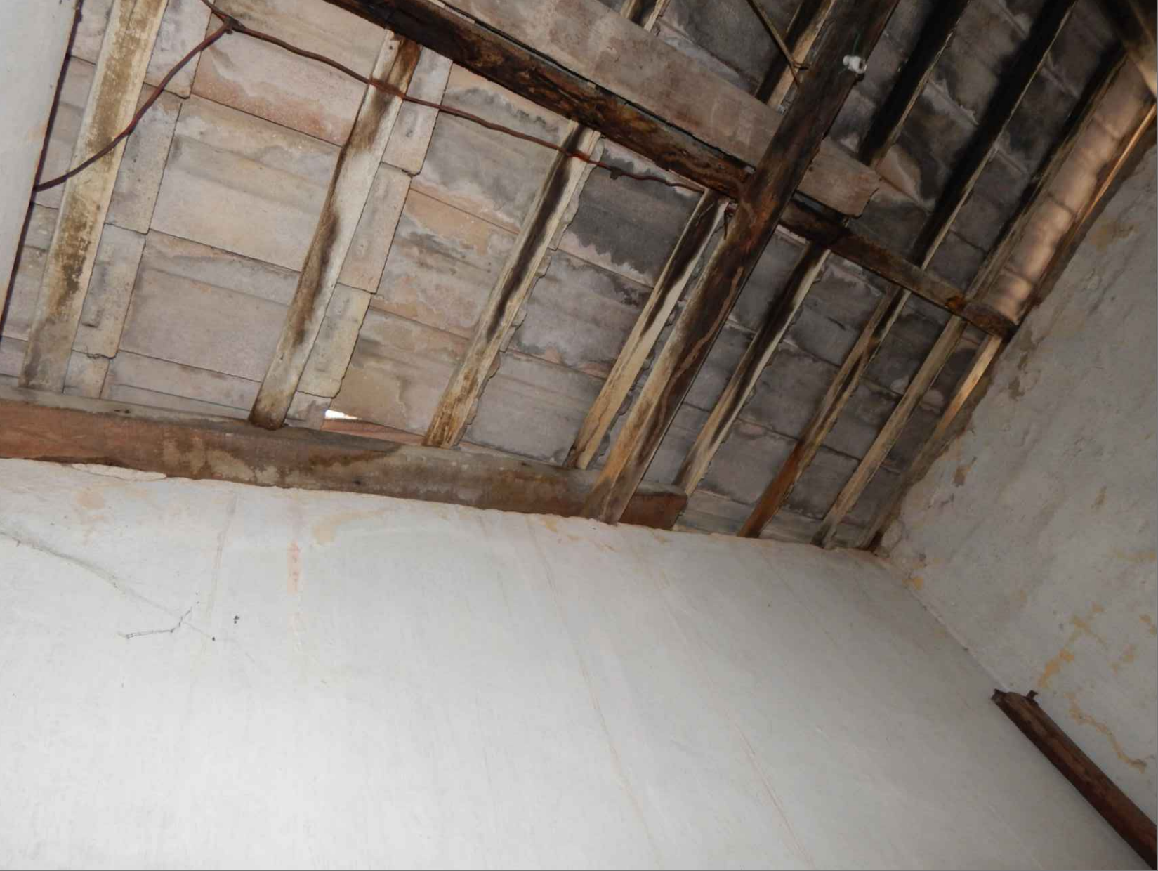
IMÁGENES 7 Y 8: LAVADO DIFERENCIAL EN MURO POR FILTRACIÓN, ESTRUCTURA DE MADERA DE CUBIERTA CON HUMEDAD Y AFECTACIONES BIOLÓGICAS. TEJAS DE CEMENTO CON LESIONES DE MOHO Y LÍQUENES.
