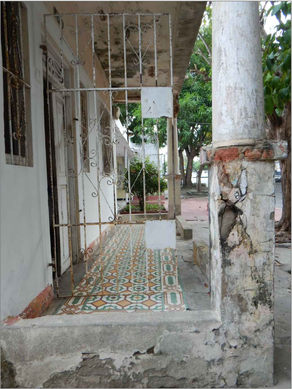
IMÁGENES 7 Y 8: MUROS CON HUMEDAD ASCENDENTE, DESPRENDIMIENTOS DE RECUBRIMIENTO Y COLUMNA CON ROTURA Y DEFORMACIÓN.
