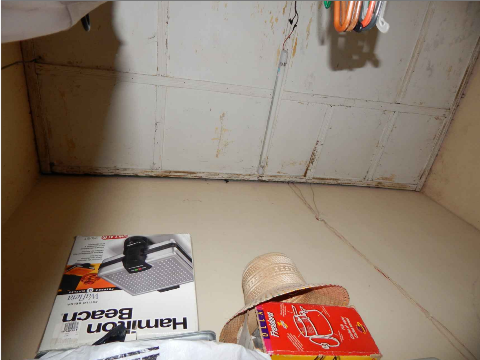
IMÁGENES 4 Y 5: MUROS Y CIELO RASO CON AFECTACIONES POR HUMEDADES QUE HAN GENERADO PROLIFERACIÓN DE COMUNIDADES BIOLÓGICAS Y DESPRENDIMIENTOS DE PINTURAS.
