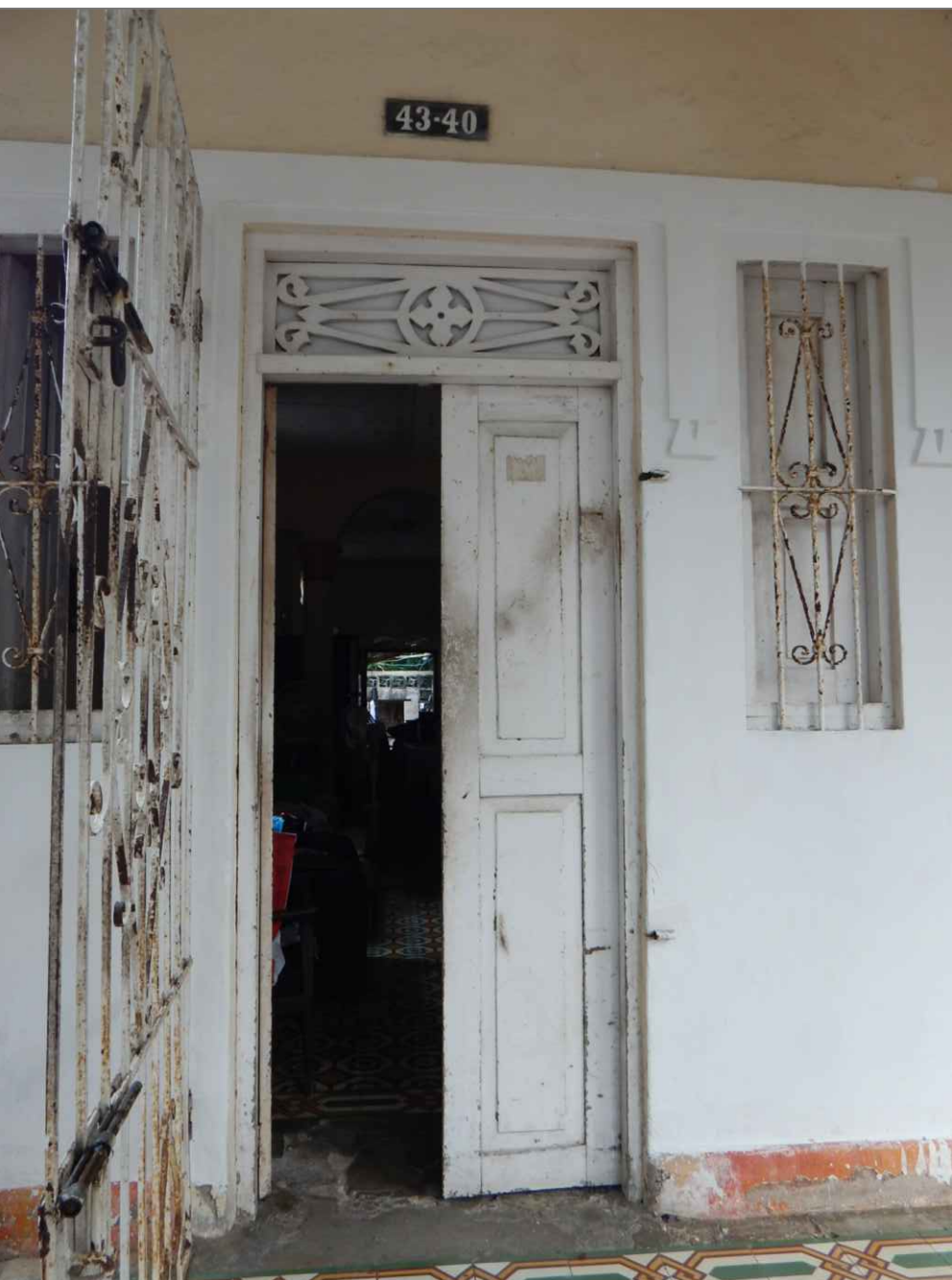
IMÁGENES N° 4, 5 Y 6: PLACA DE CUBIERTA CON AFECTACIÓN GENERALIZADA POR HUMEDAD DE FILTRACIÓN QUE HA GENERADO CARBONATACIÓN DEL ELEMENTO CON PROLIFERACIÓN DE COMUNIDADES BIOLÓGICAS. CARPINTERIA EN MADERA PARA PUERTA DOBLE DE ACCESO Y VENTANAS, CON PRESENCIA DE REJAS EN HIERRO FORJADO.
