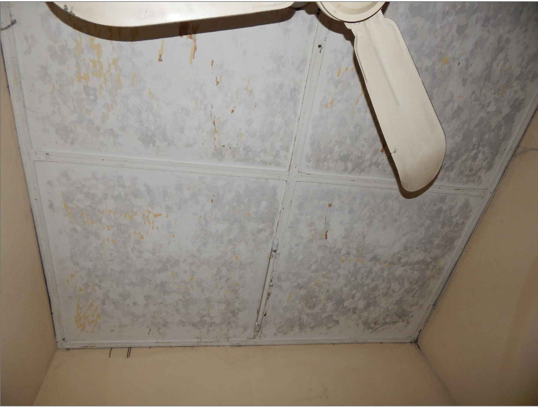
IMÁGENES N 4 Y 5: HUMEDADES EN MUROS (LATERAL) Y CIELO RASO (POR FILTRACIÓN), QUE HAN GENERADO ABOMBAMIENTO Y DESPRENDIMIENTO DE PINTURA DE RECUBRIMIENTO, CON APARICIÓN DE EFLORESCENCIAS Y LÍQUENES.
