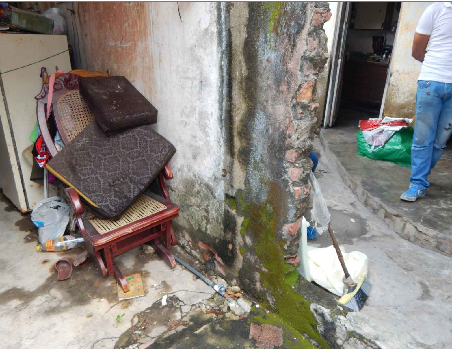
IMÁGENES 6, 7 Y 8: ROTURA EN PLANTILLA DE PISO, CON GRIETAS, VEGETACIÓN EPIFITA, PROLIFERACIÓN DE COMUNIDADES BIOLÓGICAS Y HUNDIMIENTOS. MURO CON ALABEO Y GRIETAS TIPO MAPEO, CON DEFORMACIÓN EN PARTE INFERIOR Y ROTURA IMPROVISADA DE MURO PARA VANO DE ACCESO.
