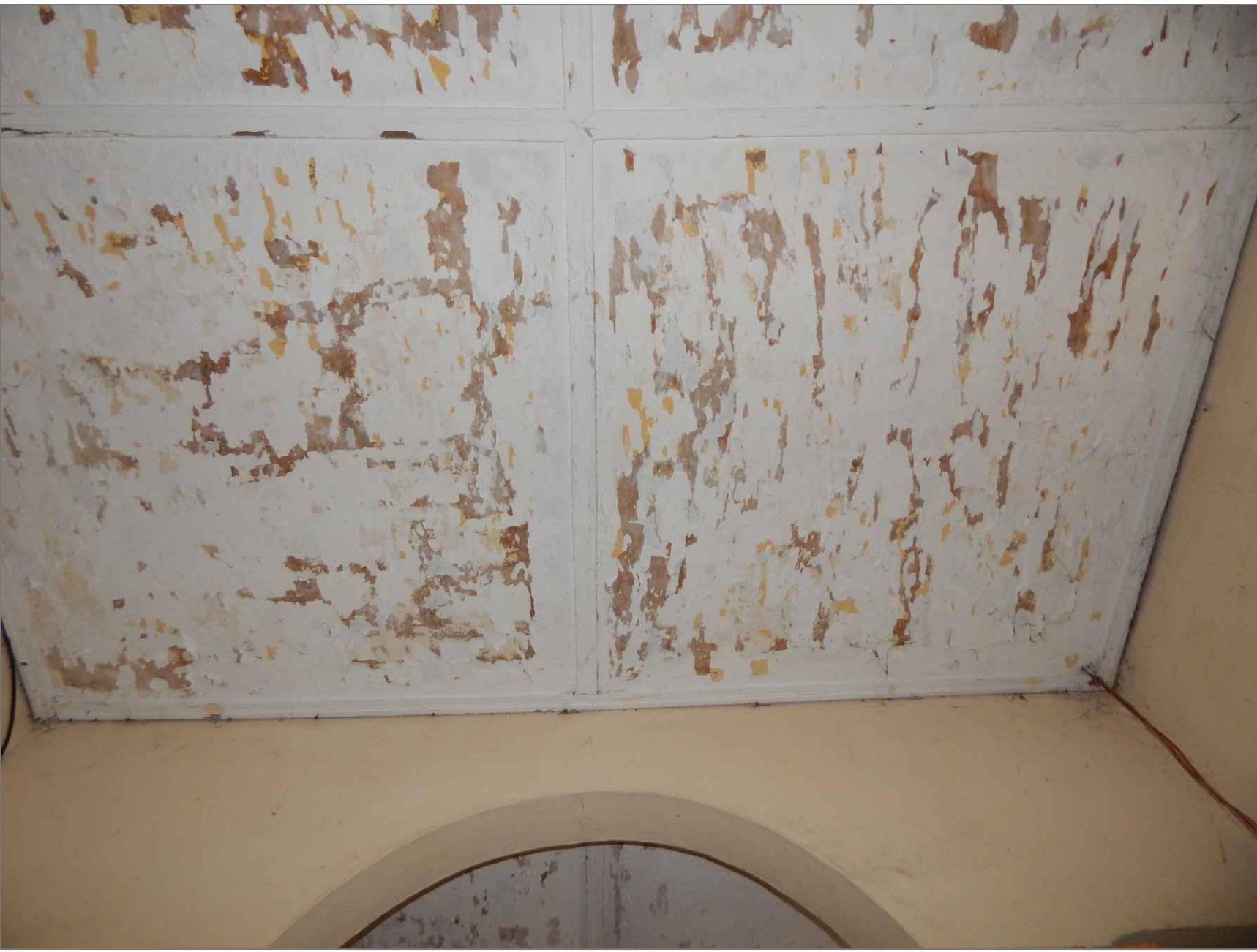
IMÁGENES N 6, 7 Y 8: VENTANA EN CARPINTERÍA DE MADERA CON PÉRDIDAS DE PIEZAS INFERIORES, HUMEDAD Y CORROSIÓN EN BISAGRAS, PUERTA METÁLICA DE ACCESO A PATIO CON OXIDACIÓN POR PICADURAS Y CIELO RASO CON HUMEDAD POR FILTRACIÓN.
