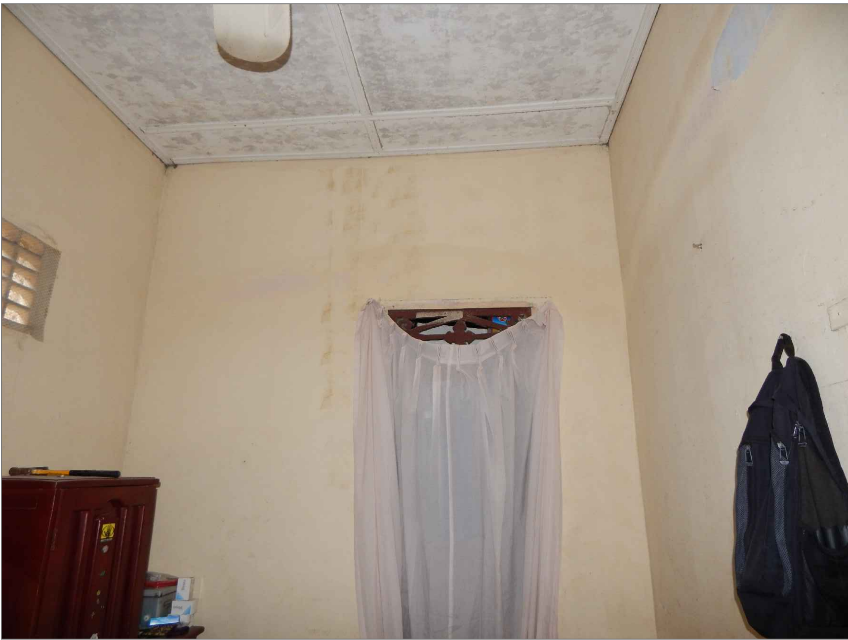
IMAGEN N° 3: VISTA GENERAL DEL ESPACIO
