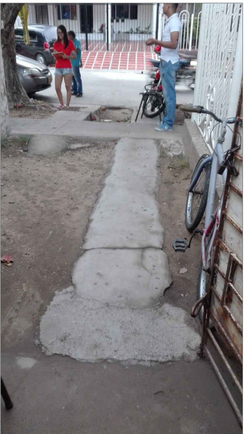
IMÁGENES 6 Y 7: CARPINTERÍA METÁLICA PARA PUERTA DE ACCESO A LOCAL CON CORROSIÓN GENERALIZADA. PLANTILLA EN CONCRETO DE RECUBRIMIENTO DE PISO TIPO PASARELA DE ACCESO A LOCAL CON ROTURAS Y DESPRENDIMIENTO DE M A T E R I A L C E M E N T I C I O .
