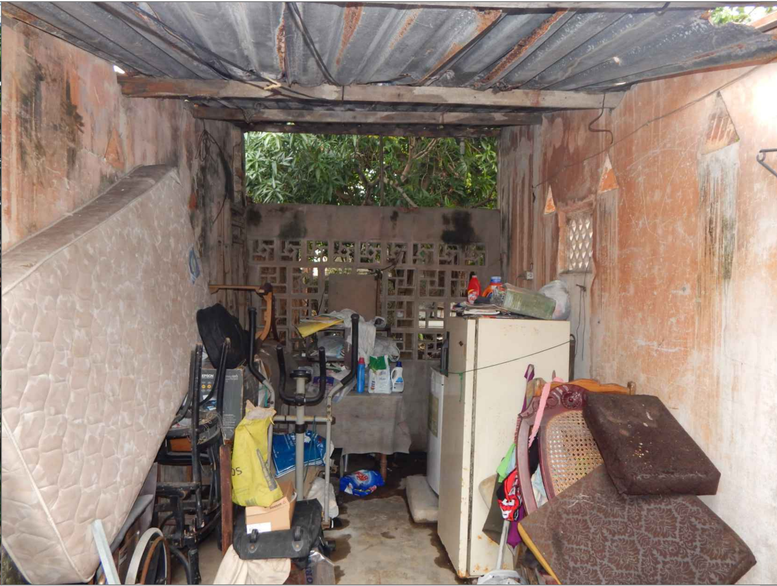
IMÁGENES 3, 4 Y 5: LA ZONA DE LABORES PRESENTA HUMEDADES, DESPRENDIMIENTOS, HONGOS, MOHOS, EFLORESCENCIAS Y LÍQUENES; TANTO EN EL RECUBRIMIENTO DE PISO COMO EN MUROS Y CUBIERTA. CON PRESENCIA DE VEGETACIÓN EPIFITA.
