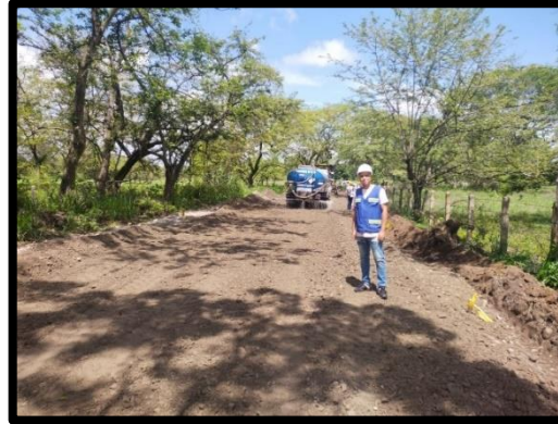
Figura 13 Visita de obra humedecimiento material anular
