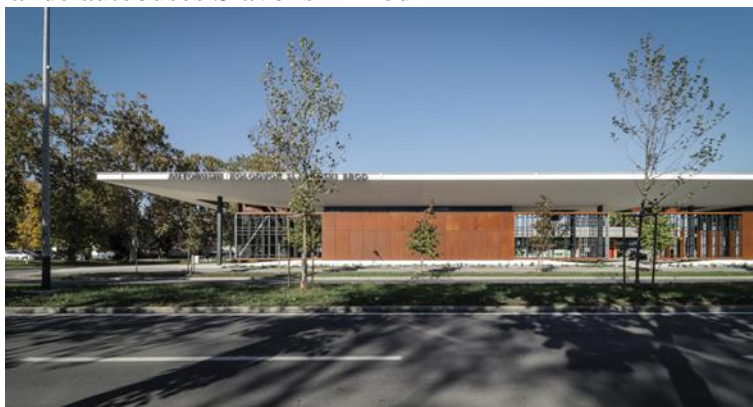
Figura 22. Terminal de autobuses Slavonski Brod
