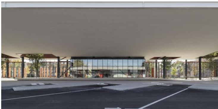
Figura 25. Fachada de terminal de autobuses Slavonski Brod
