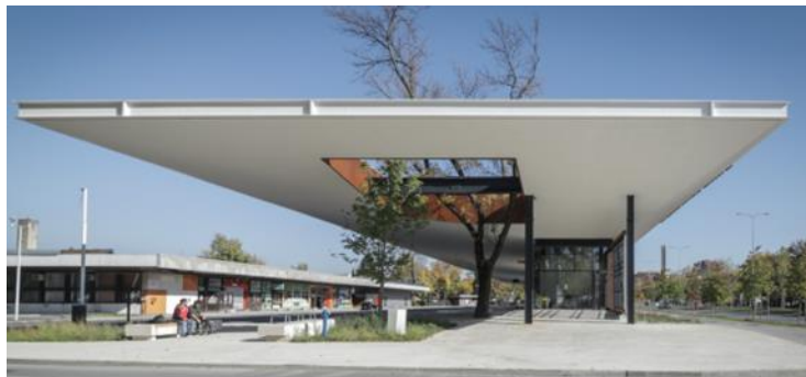
Figura 24. Fachada de terminal de autobuses Slavonski Brod
