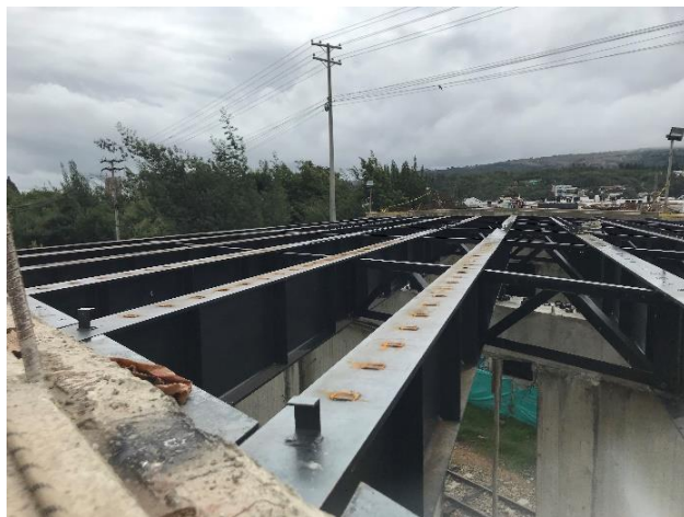
Ilustración 10. Retiro de cortantes super estructura metálica central
