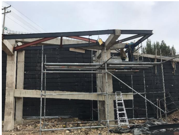
Ilustración 4. Muro en tierra armada con refuerzo de geotextil
