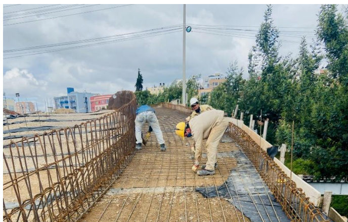
Ilustración 12. Instalación acero de refuerzo New Jersey y parrilla de refuerzo losa ciclovía
