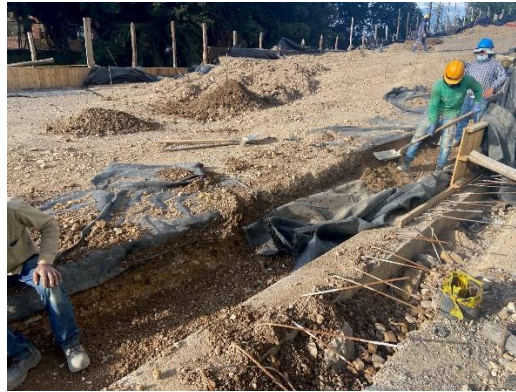
Ilustración 14. Excavación para implementación de bordillo suroccidental
