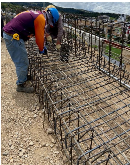
Ilustración 13. Figurado y armado de acero bordillo suroccidental
