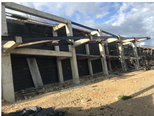
Ilustración 8. Estructura metálica rampa peatonal
