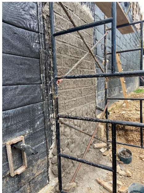
Ilustración 15. Prueba de recubrimiento final parte exterior tierra armada
