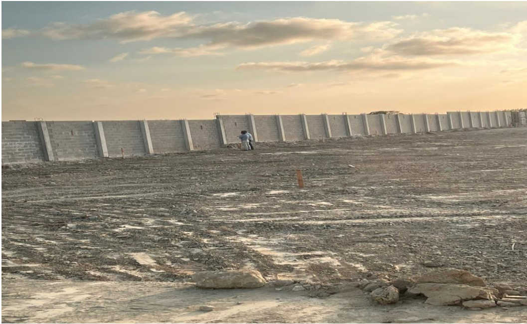
Figura 2. Adecuación de Terreno (JGP). Parque Industrial. Barranquilla
