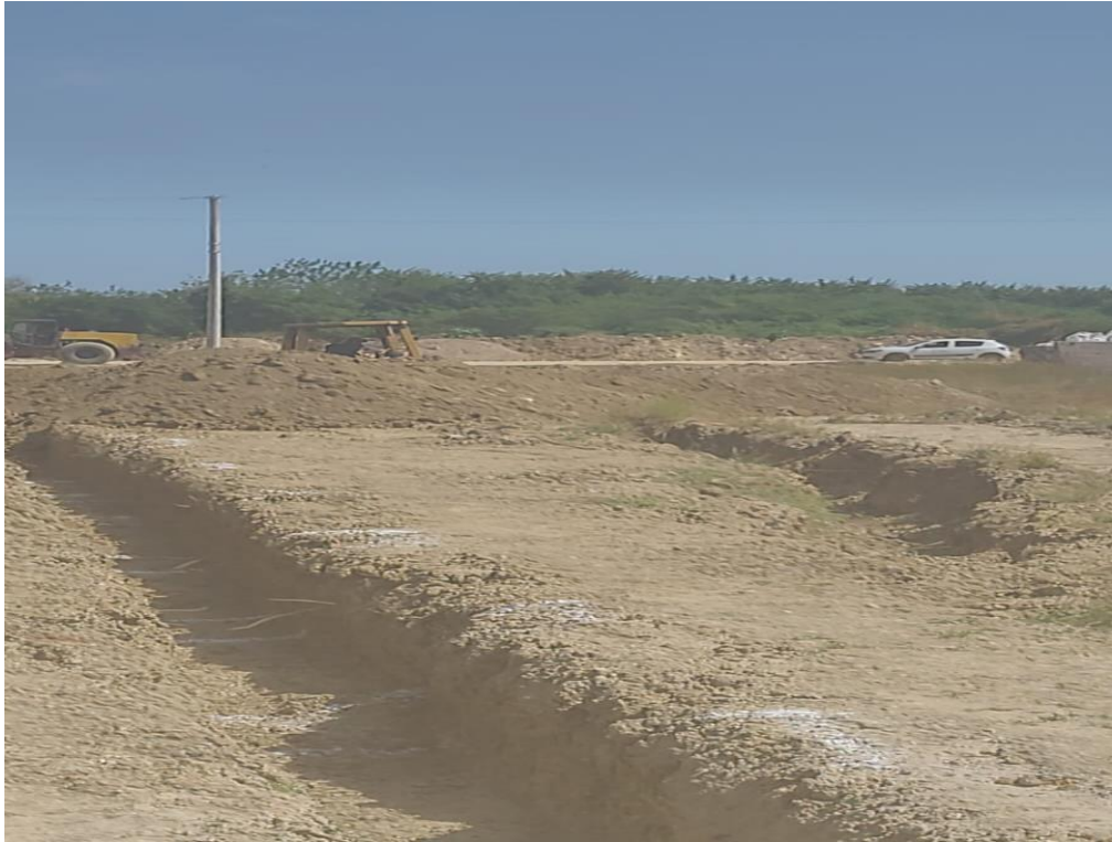
Figura 4. Obra Civil (JGP). Parque Industrial. Barranquilla (Atlántico).
