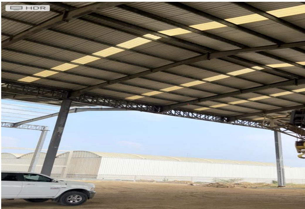
Figura 5. Estructura Metálica (JGP). Parque Industrial. Barranquilla (Atlántico).
