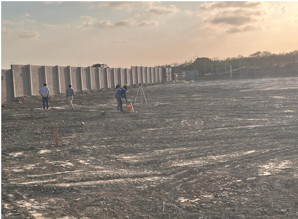
Figura 3. Ejecución de Obra Civil (JGP). Parque Industrial. Barranquilla (Atlántico).
