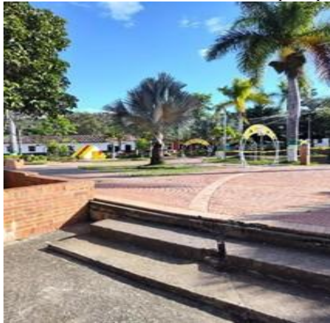
Figura 4. Fotografía del estado actual de uno de los senderos principales del parque
