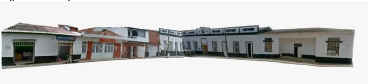
Figura 14. Vista fachada sur
