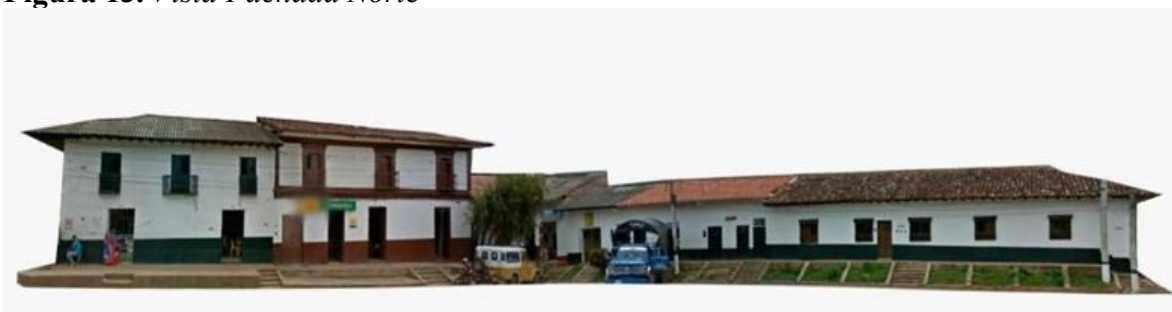
Figura 13. Vista Fachada Norte
