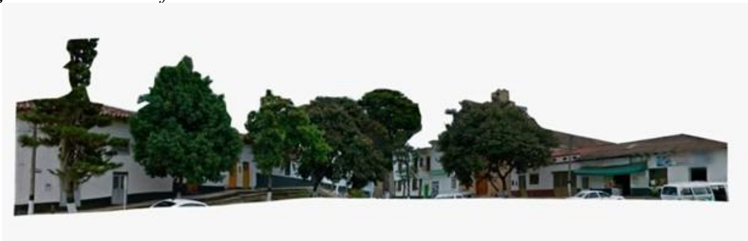
Figura 7. Vista de la fachada este
