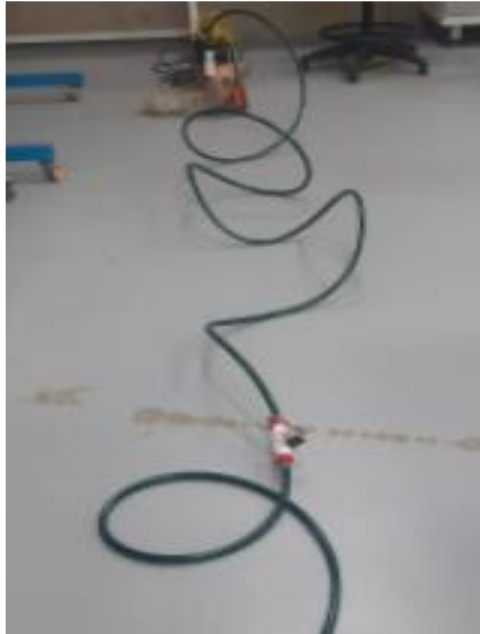
Figura 53 Conexión electrobomba con electroválvula. Fuente: Autor.
