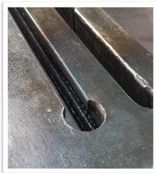
Figura 8.58 Inspección y verificación de fresado rotativo realizado.
