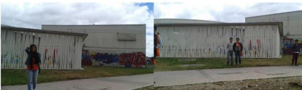
Figura 27. Fotografía a los módulos y fotografía cintas Fuente: Registro fotográfico, visita al proyecto 4 sep. 2015
