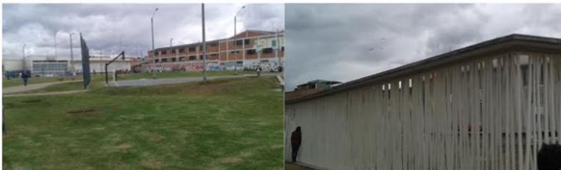
Figura 25. Fotografía exterior y fotografía al cerramiento Fuente: Registro fotográfico, visita al proyecto 4 sep. 2015
