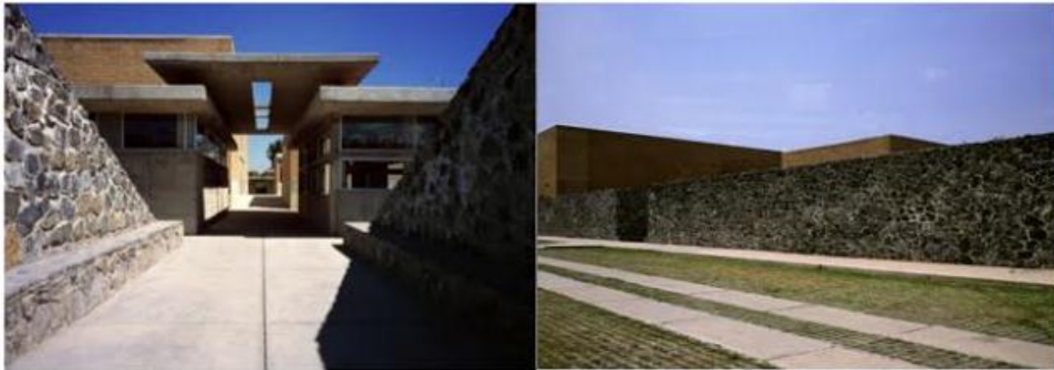
Figura 12. Paso de muros con vista hacia los talleres y vista al muro ciego exterior Fuente: Imagen de Luis Gordo, Arch Daily Colombia
