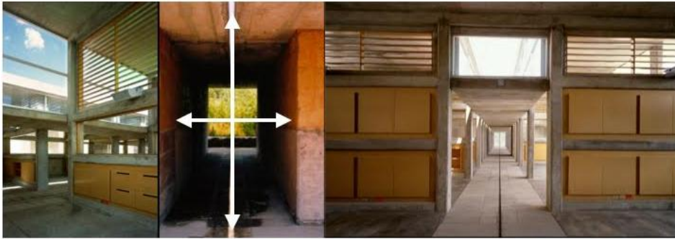
Figura 7. Circulación, cerramiento y uso de materiales en el interior
