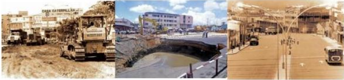
Figura 123. Pavimentación y hundimientos de la avenida Quebrada Seca Fuente: Vanguardia Liberal, Historia De Bucaramanga
