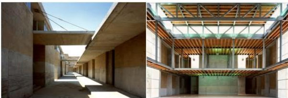
Figura 9. Tensores y estructura
