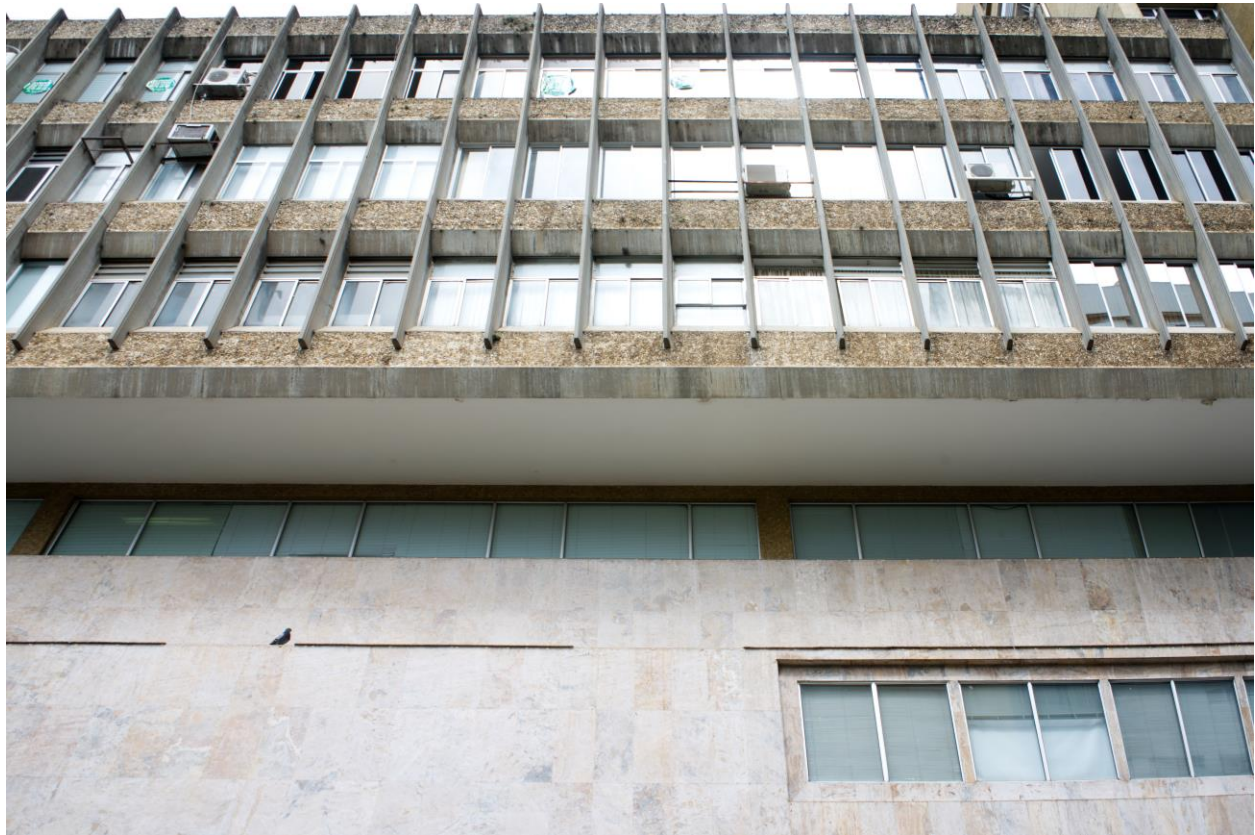
Figura 62. Fotografía detalle alfajías y parasoles
