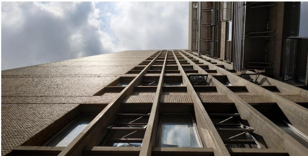
Figura 28. Identificación de los parasoles y juego de ventanearía en una de las fachadas laterales
