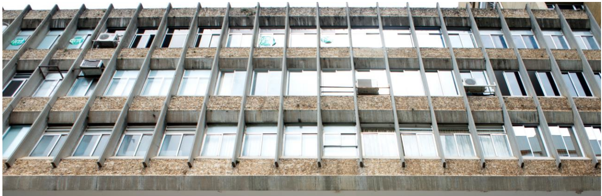
Figura 51. Edificio Cámara de Comercio – Fachada Carrera 19 (pisos 5,6,7 conformado por la barra con sus respectivos parasoles)
