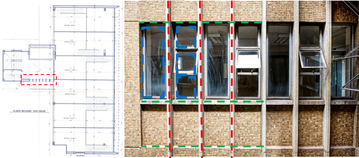
Figura 60. Fotografía frontal celosías de lamas fijas moduladas
