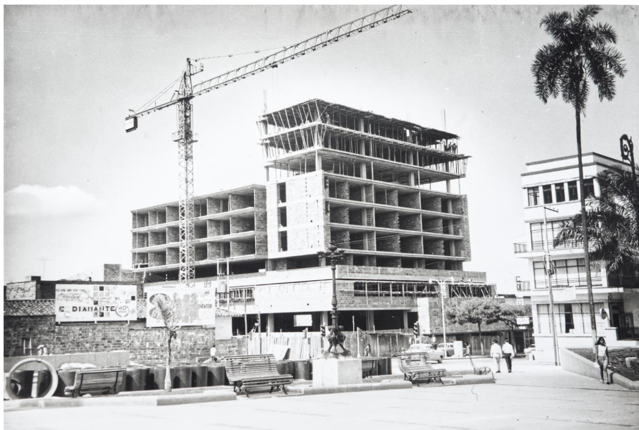
Figura 56. Fotografía del edificio CCB en construcción
