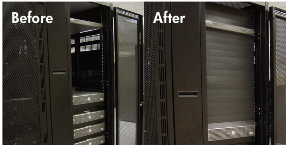
Figura 49. Aplicación de paneles ciegos en rack.
