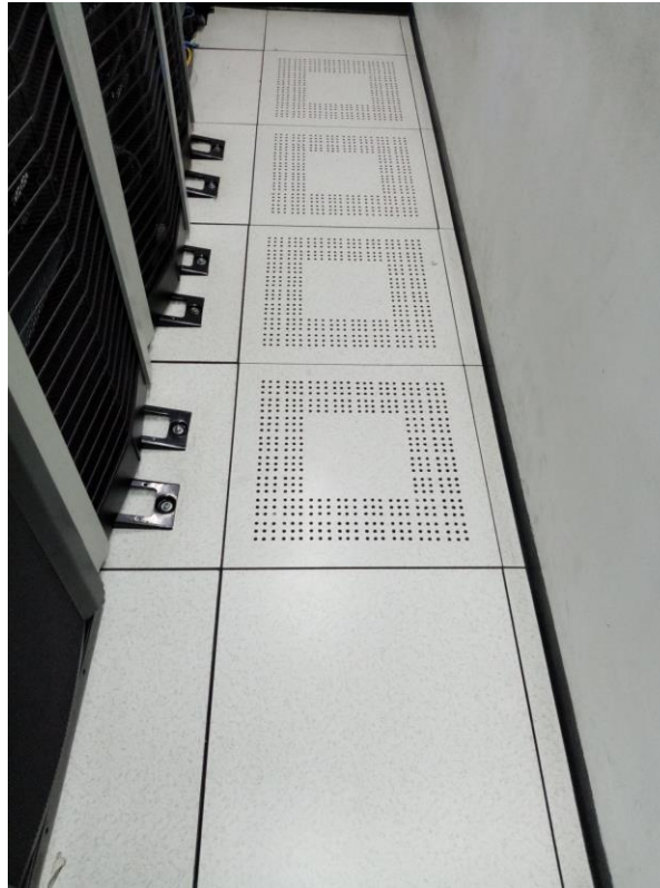
Figura 18. Pasillo con baldosas perforadas.
