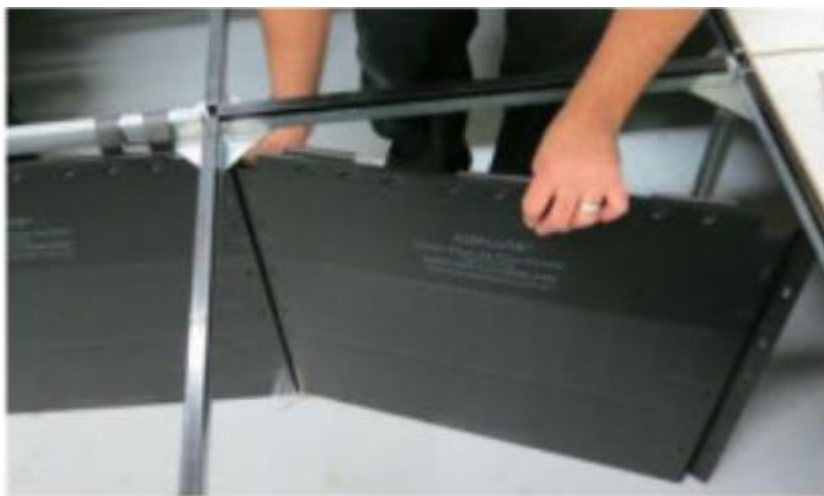
Figura 50. Instalación de placas subterráneas.
