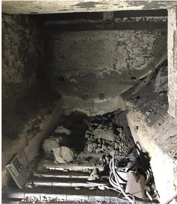
Figura 11. Parrilla IKN del enfriador
