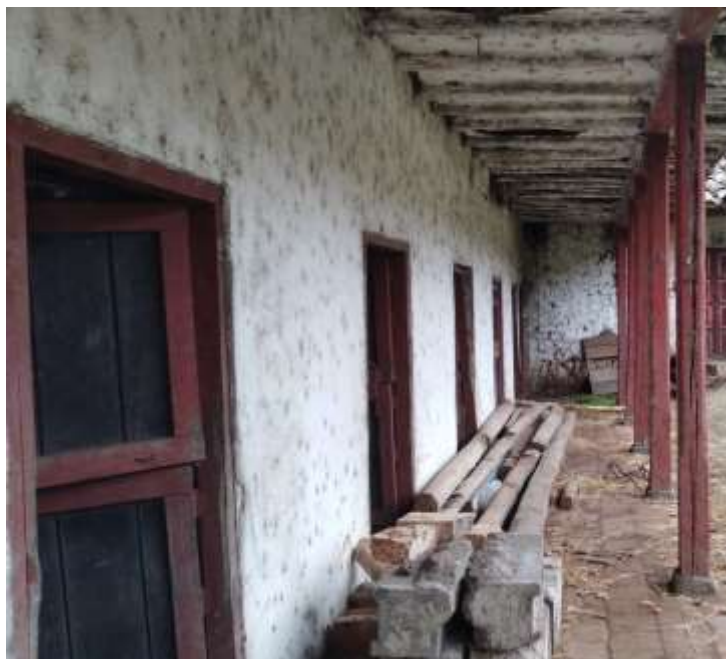
Foto 5- Madera en estructura- Fotógrafo Mike Dylan Vélez
