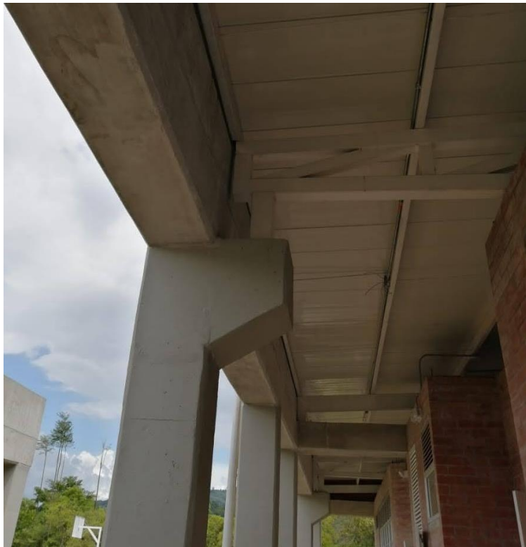
Figura 24. Conexión "ménsula - cercha" en plano
