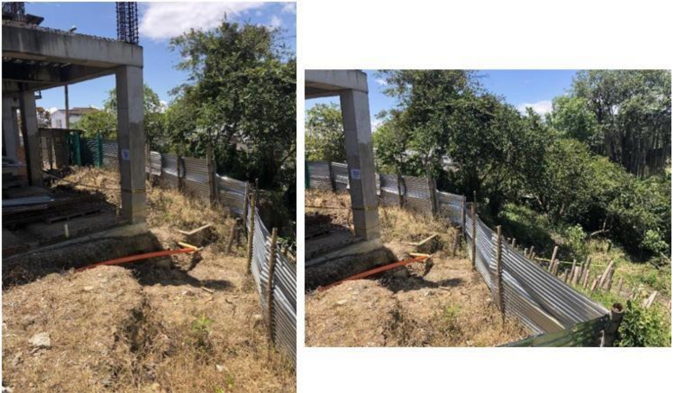
Figura 36. Visita de obra OC Chitaraque
