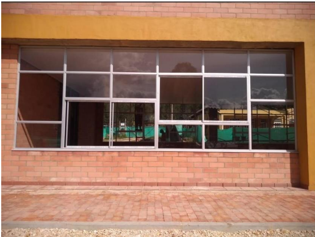
Figura 31. Ventana instalada en I.E SILVA PLAZAS
