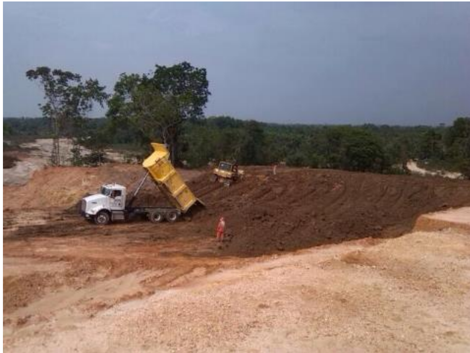
Figura 5. Descarga de material: capote, por empresa Ruta del Sol.
