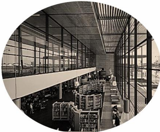
AMPLIO ESPACIO DE DOBLE ALTURA, ACCESO DESDE EL PUENTE.
