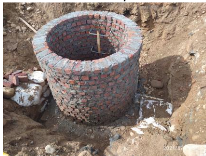
Figura 41. Pozo de inspección doble calzada
