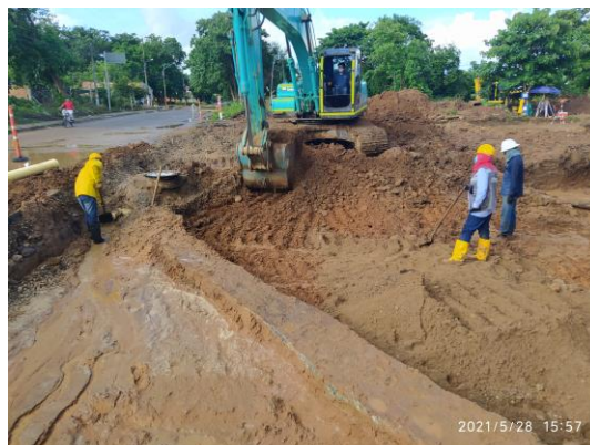
Figura 36. Excavación y descapote
