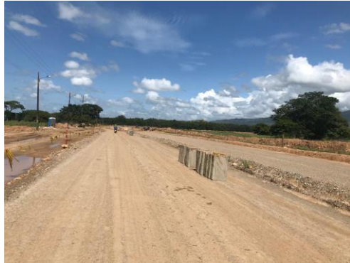
Figura 42. Excavación doble calzada
