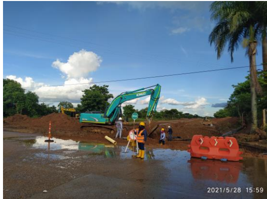
Figura 35. Excavación y descapote
