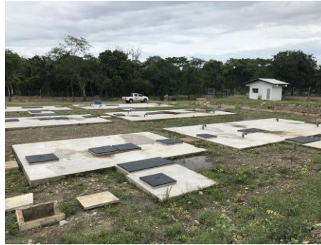
Figura 15. PTAR, vereda Cupiagua
