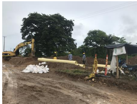
Figura 22. Excavación tubería agua lluvias
