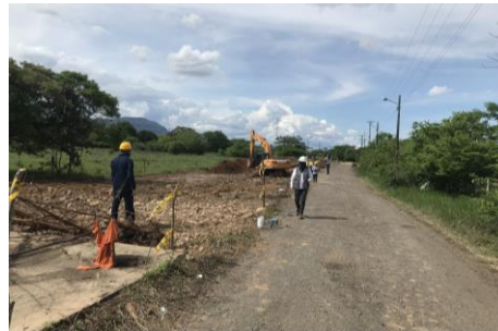
Figura 16. Trabajo de maquinaria en descapote vía doble calzada
