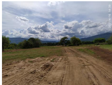
Figura 19. Descapote de doble calzada
