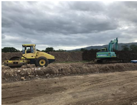
Figura 29. Descapote y nivelación vía doble calzada
