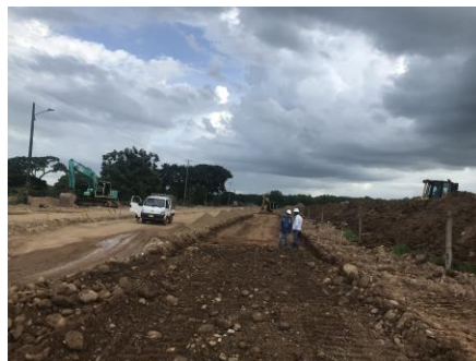
Figura 32. Material de suelo para compactación
