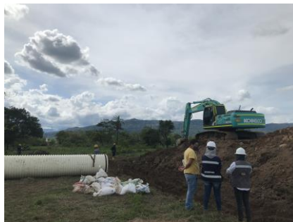
Figura 17. Excavación tubería sanitaria construcción doble calzada
