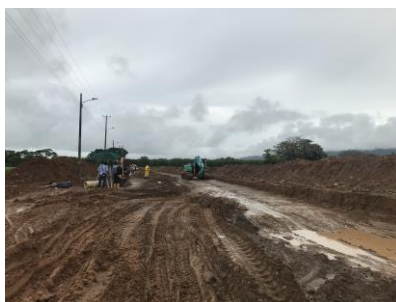
Figura 20. Excavación y descapote proyecto doble calzada
