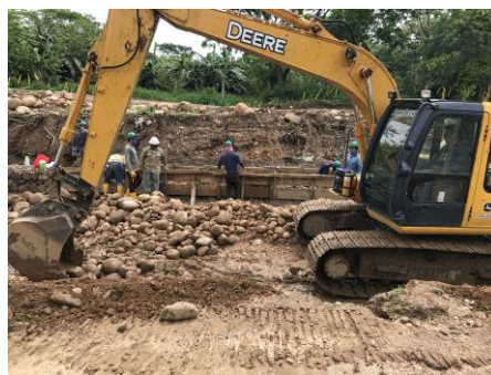
Figura 14. Trabajo maquinaria en obras de protección río Únete
