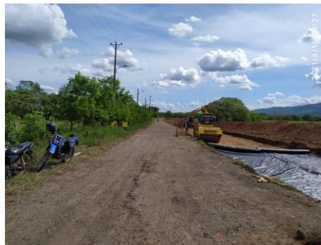
Figura 19. Descapote de doble calzada
