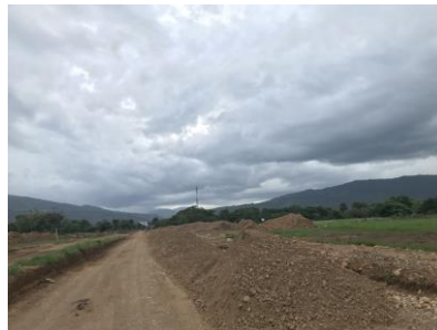
Figura 31. Material de suelo para compactación
