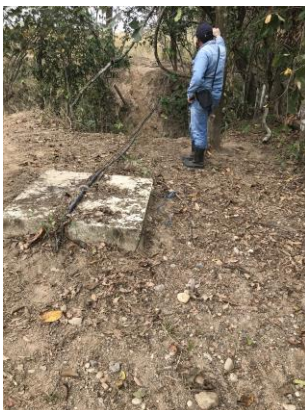
Figura 7. Tubería de 3" para el bastecimiento con valvula de salid, vereda Guaduales
