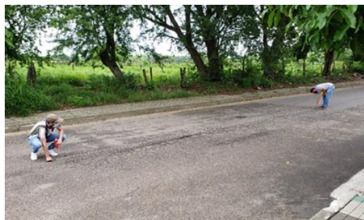
Figura 34. Medida proyecto reparcheo
