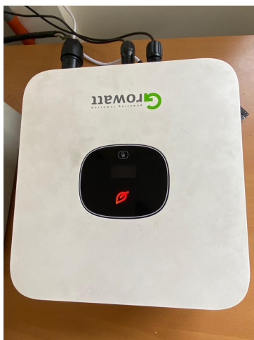
FIGURA 20: Estado del inversor sin sincronización por falta de tensión o irradiancia (indicador rojo). Fuente: Autores.
