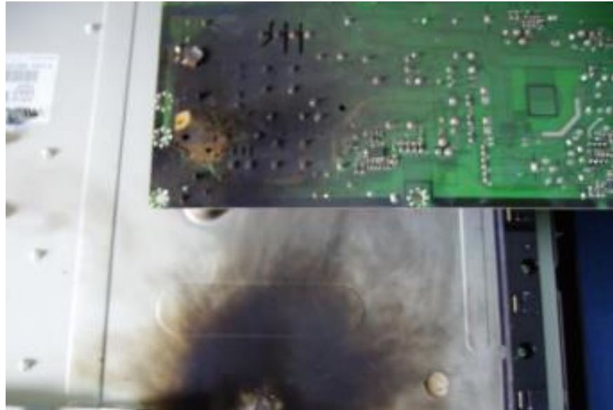
Figura 24. Descarga atmosférica (Rayo) 1
