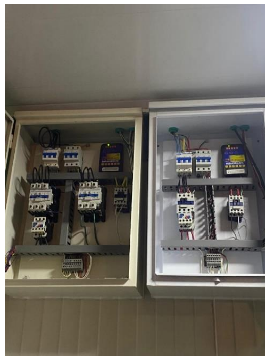
Figura 9. Verificación de funcionamiento del protector electrónico instalado
