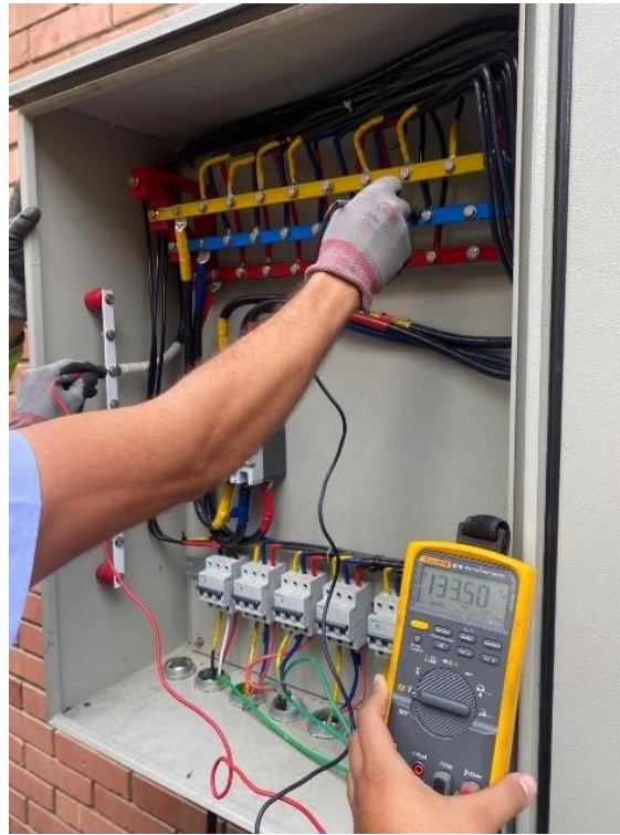
Figura 8. Verificación de instalaciones eléctricas en empresas
