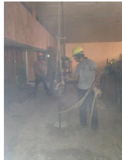
Imagen 13: Sondeo para estudio de geotécnico.
