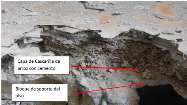
Detalle del sistema de Piso encontrado en los ensayos exploratorios.
