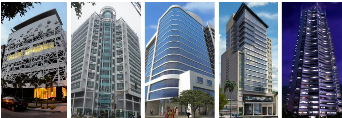
Figura 30. Nuevas edificaciones construidas a través de los años.
