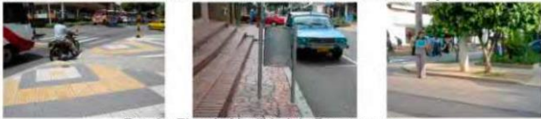
Gráfica N° 70. Situación actual: inadecuado ubicación de mobiliario y arborización
