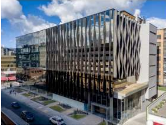
Figura. 22 Fachadas edificio Terranum.
