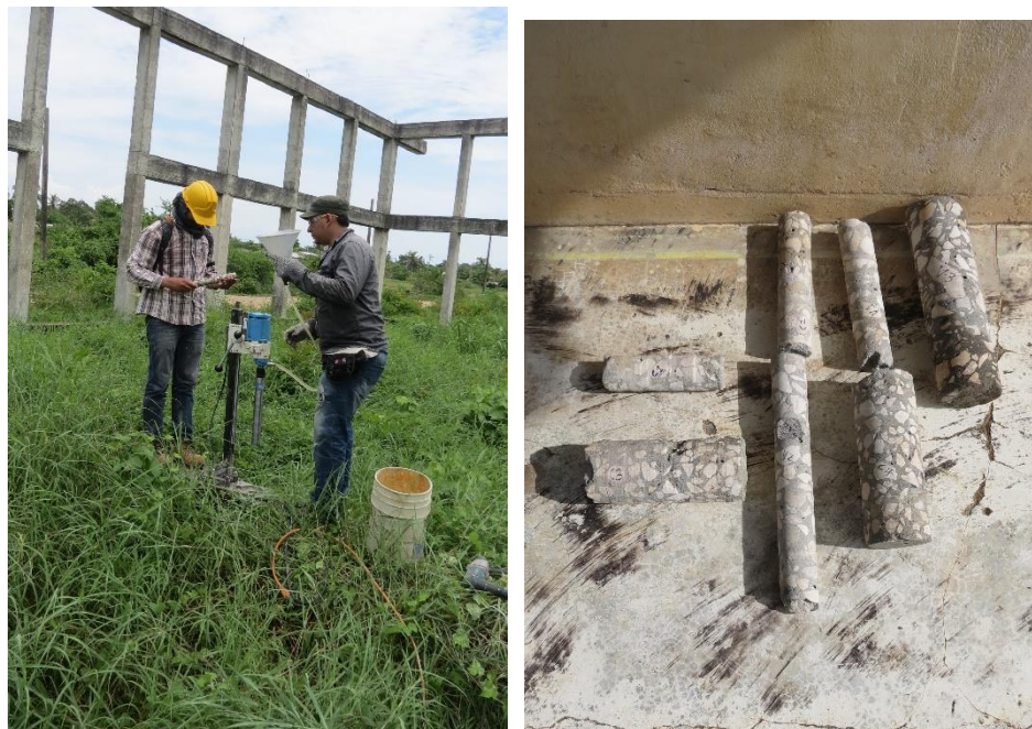
Figura 18 Extracción de núcleos de concreto
