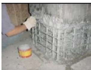
Figura 65 Procedimiento de tratamiento: puente de adherencia (Registrocdt.cl, 2013, pág. s.n)
