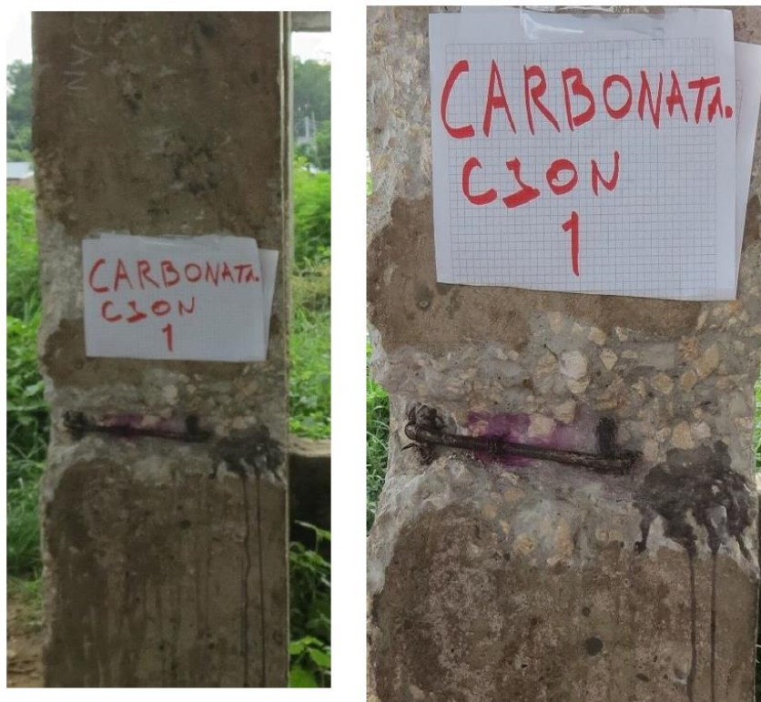
Figura 27 Registro fotográfico- Ensayo de carbonatación
