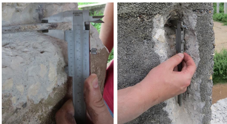
Figura 21 Regata para medición del diámetro del acero de refuerzo
