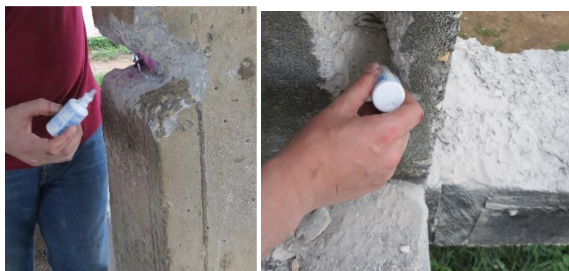
Figura 22 Ensayo para determinación de cloruros
