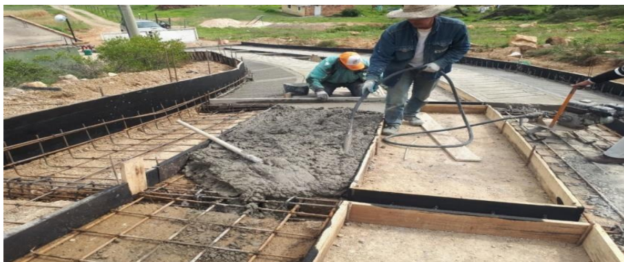
Ilustración 64: Vaciado de concreto.
