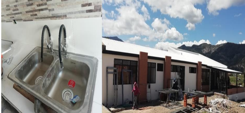
Ilustración 19: Instalación de accesorios y terminación de acabados.
