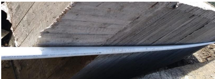
Ilustración 28: Suministro e instalación tubería PVC presión D = 2"
