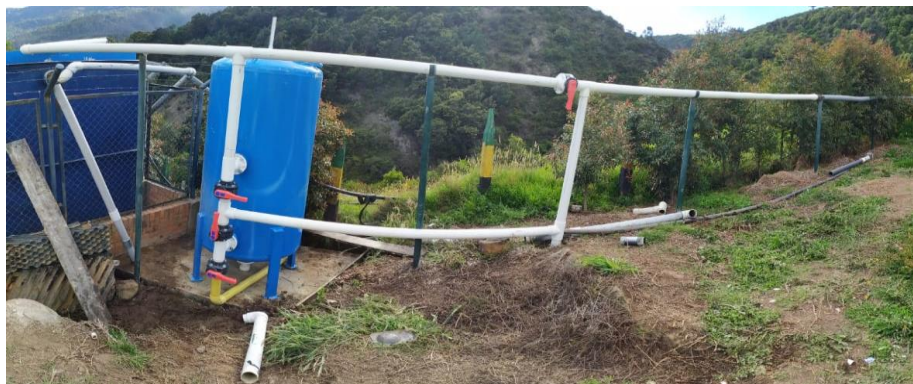
Ilustración 60: Sedimentador de flujo ascendente.
