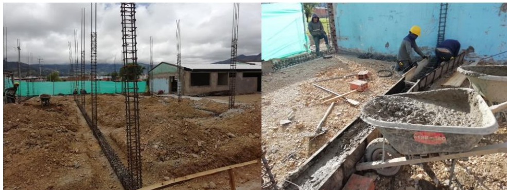
Ilustración 9: Vigas de cimentación y formaleta metálica.
