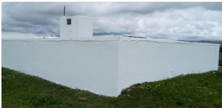
Ilustración 30: Mejoramiento de tanque sector La Cumbre acueducto Cartagena.
