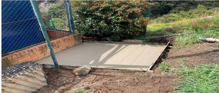
Ilustración 59: Placa de piso en concreto de 21.1 MPa.
