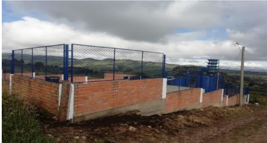
Ilustración 42: Mejoramiento acueducto el Gacal.
