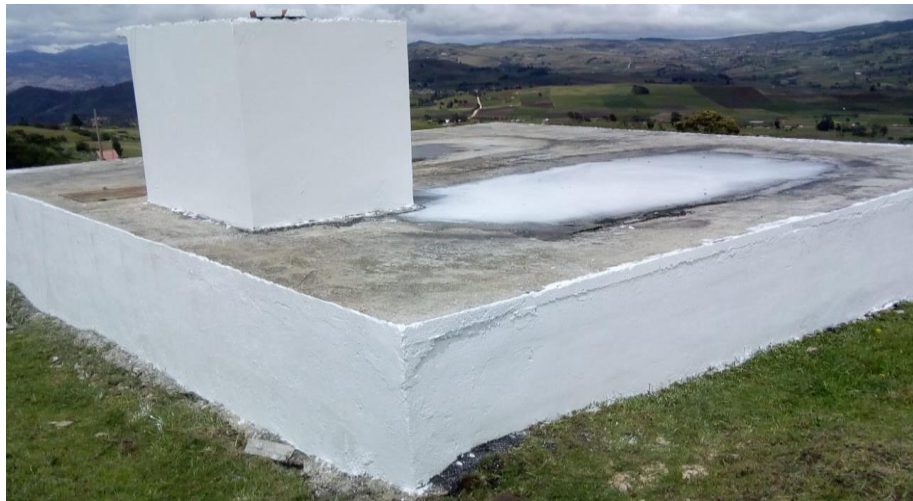
Ilustración 29: Mejoramiento de tanque 1 acueducto Cartagena
