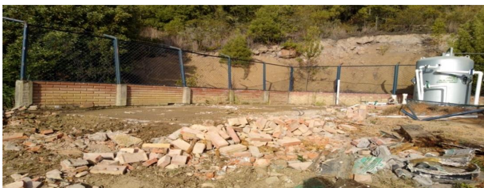
Ilustración 48: Demolición de obras en concreto y tanque en fibra de vidrio.
