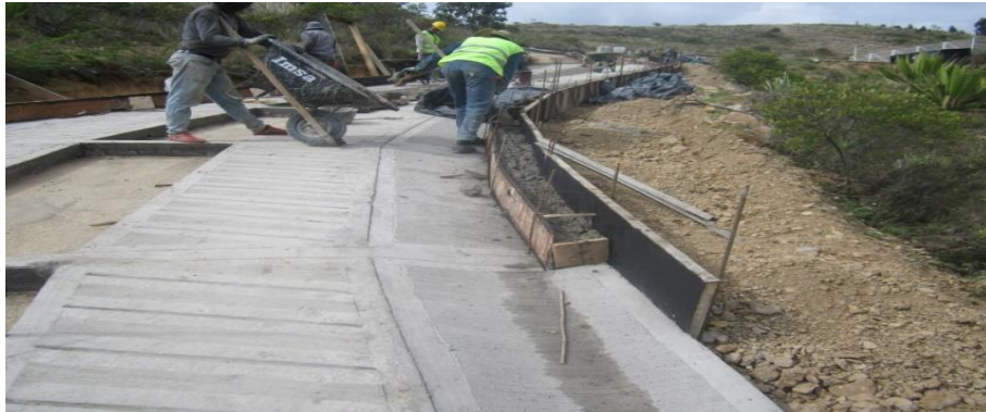
Ilustración 65: Vaciado de concreto en los bordillos.
