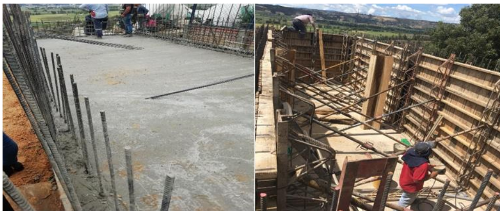
Ilustración 50. placa y formaleta para fundir muros
