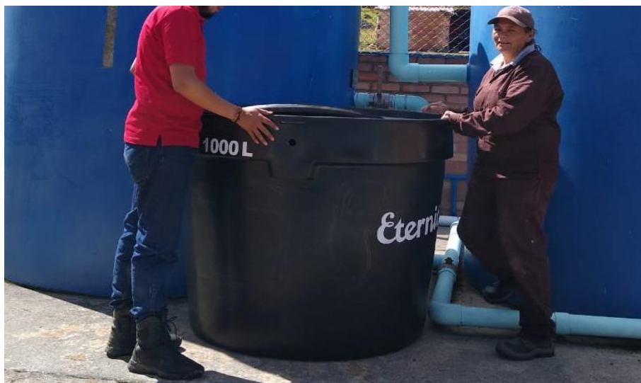
Ilustración 45: Acueducto Quebraditas 1 Suministro de tanque.
