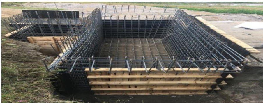
Ilustración 26: Suministro figurado y armado de acero de refuerzo.
