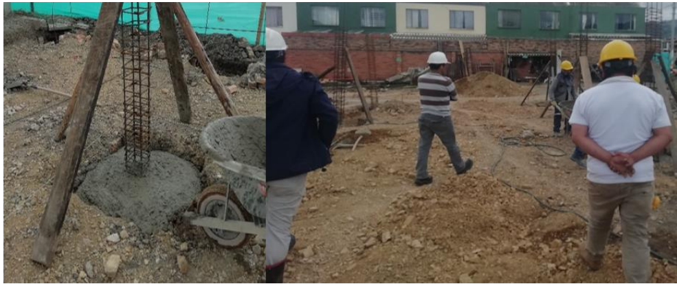
Ilustración 8: Zapatas con concreto de 3060.3 PSI.
