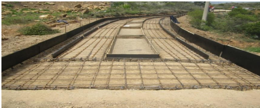
Ilustración 63: Suministro de acero para contrahuellas y rampa.
