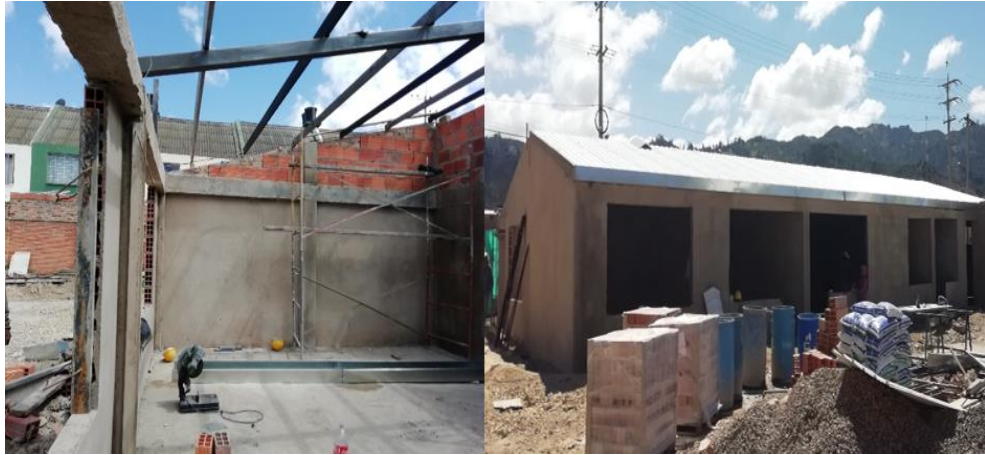
Ilustración 13: Pañetes y cubierta
