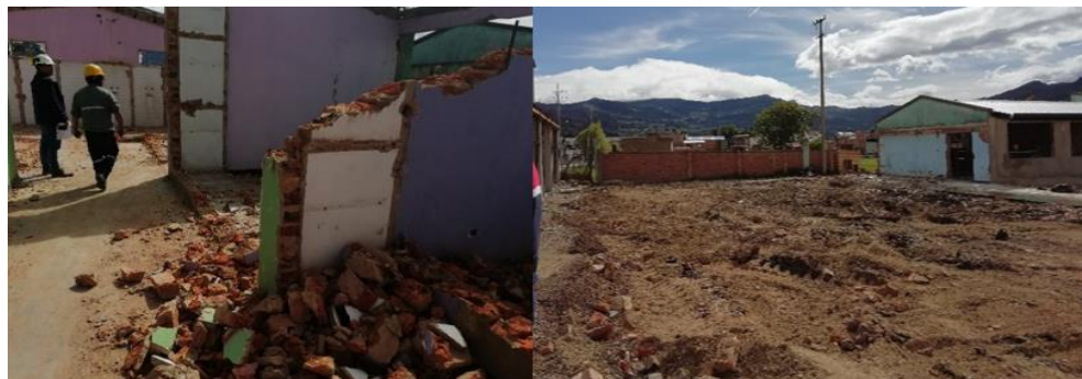
Ilustración 5: Demolición de bloque 1.
