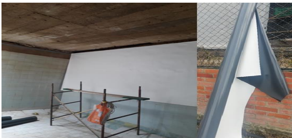
Ilustración 47: Acueducto el Venado mejoramiento de tanque enchape y membrana en PVC.
