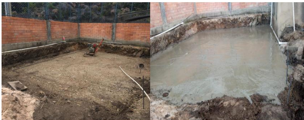
Ilustración 34: Demolición de obras en concreto y tanque en fibra de vidrio.
