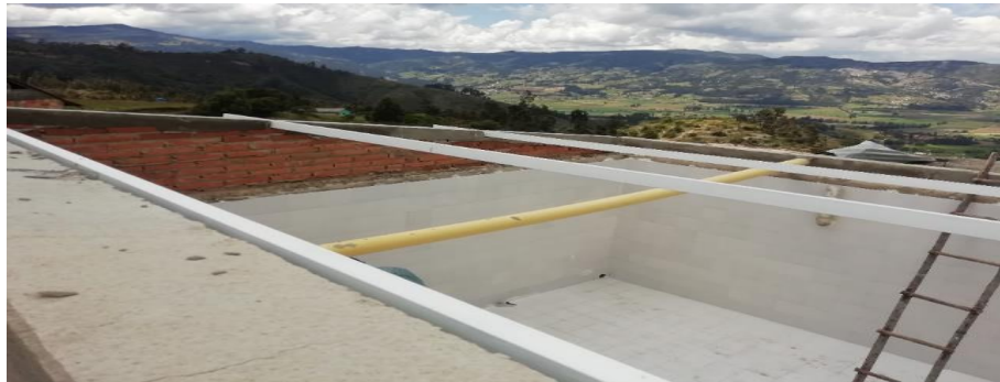
Ilustración 22: Mejoramiento de acueducto el Rabanal
