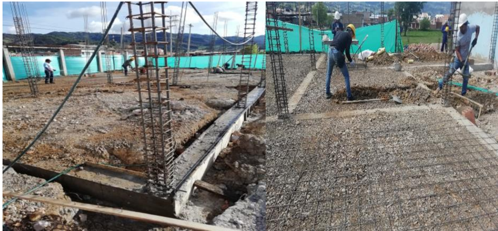
Ilustración 11: Comparación de material afirmado e instalación de redes hidrosanitarias y eléctricas.
