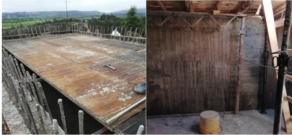
Ilustración 36: Formaleta para fundir placa y desmonte de formaleta.
