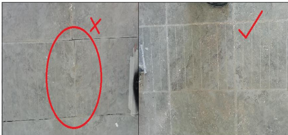
Ilustración 20: Juntas del enchape de porcelana.
