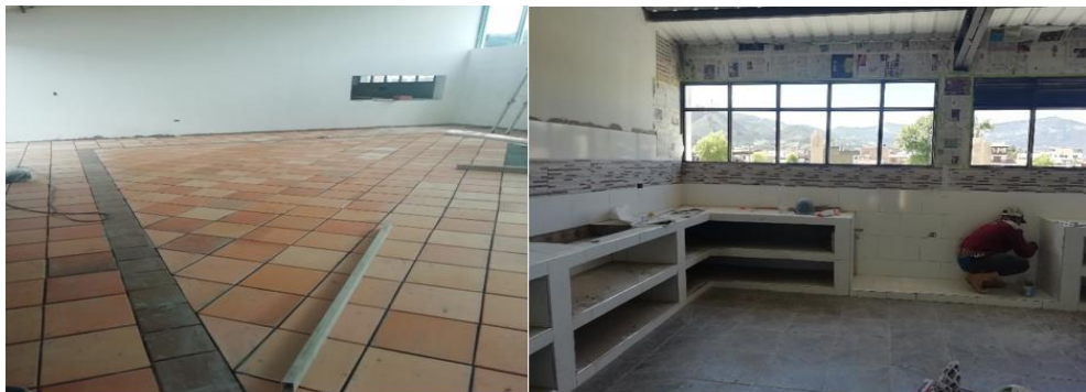
Ilustración 18: Enchape de pisos y mesones.
