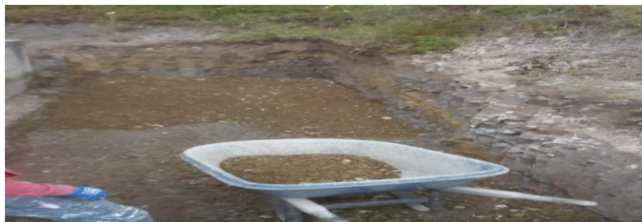
Ilustración 25: Base material de afirmado compactado
