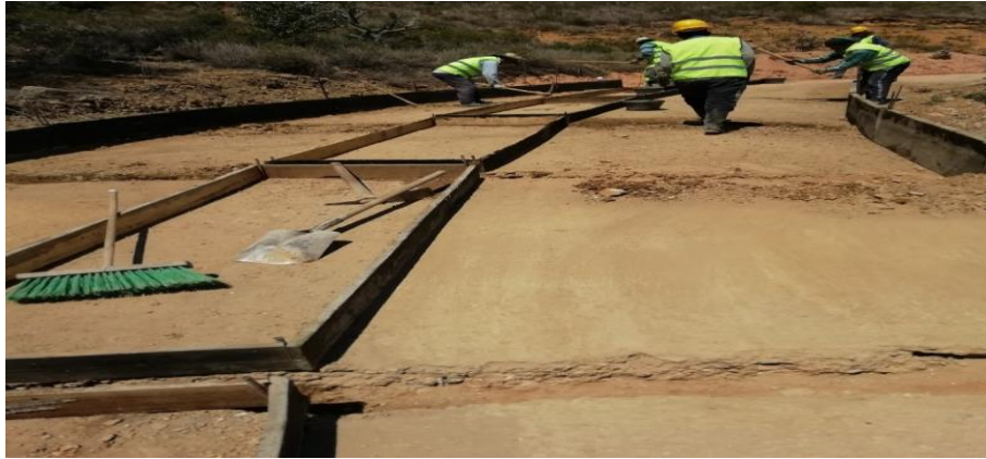
Ilustración 62: Formaleta en madera y metálica para contrahuellas.
