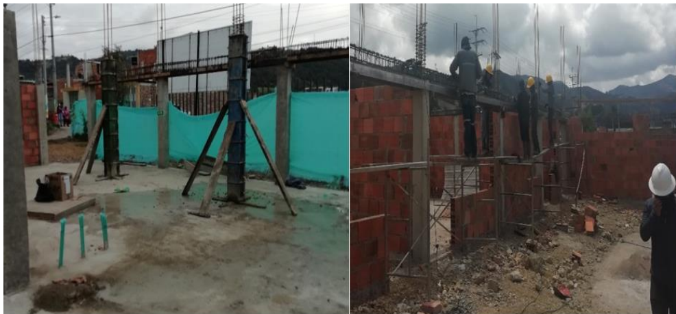
Ilustración 12: Mampostería, vigas y columnas.
