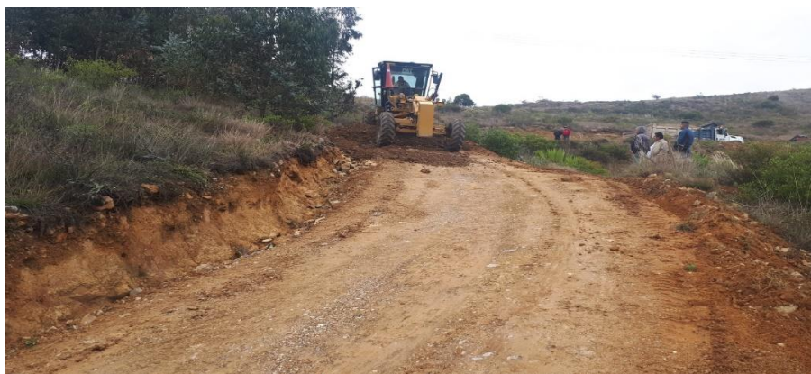
Ilustración 61: Suministro de material y extendido con la motoniveladora.
