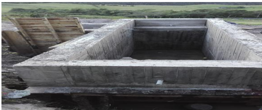
Ilustración 27: desarenador, concreto simple de 28 MPa.
