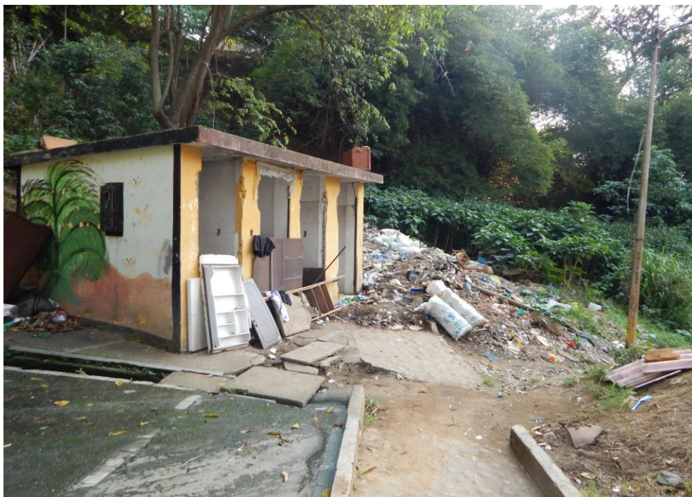
Figura 74. Baños en desuso.
