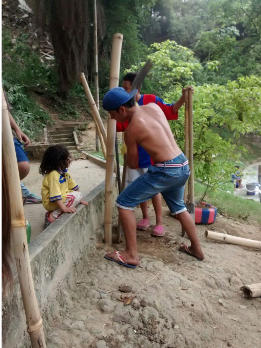
Figura 101. Construcción parque fase III. Imagen proporcionada por ALMA BAMBU
