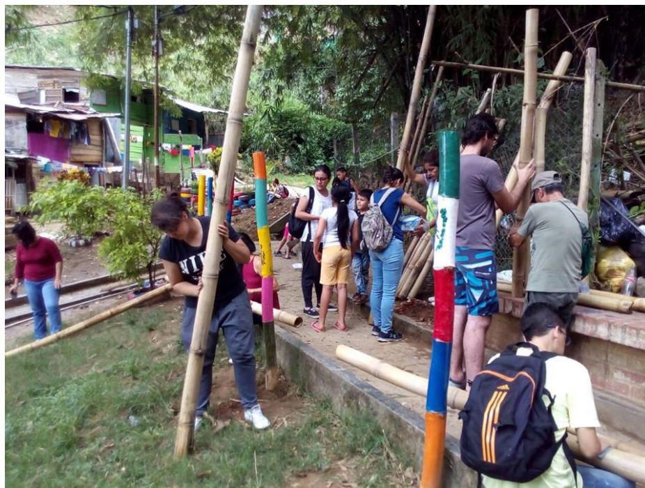
Figura 100. Construcción parque fase III. Imagen proporcionada por ALMA BAMBU
