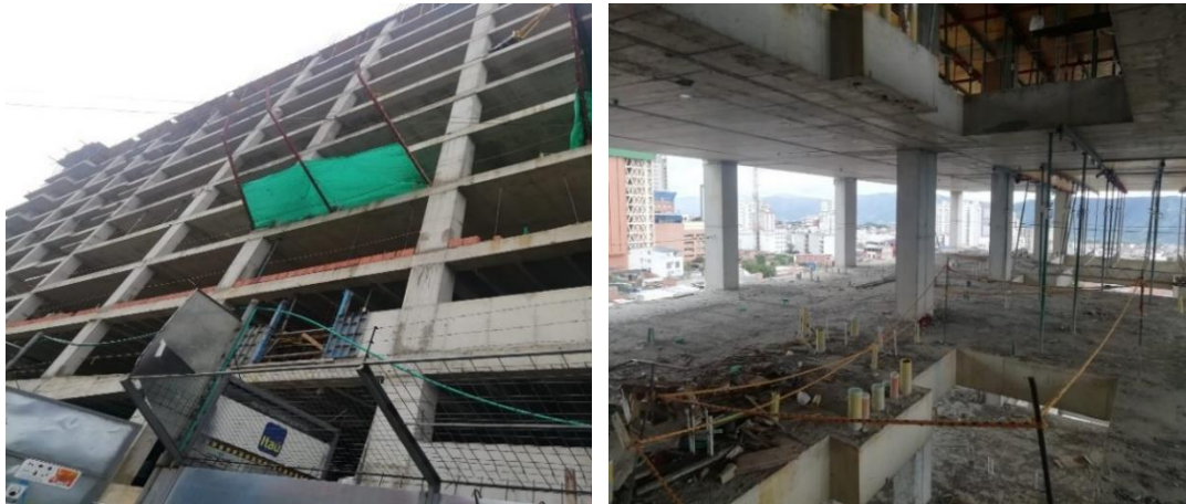
Figura 35. Construcción vertical Akau 25
