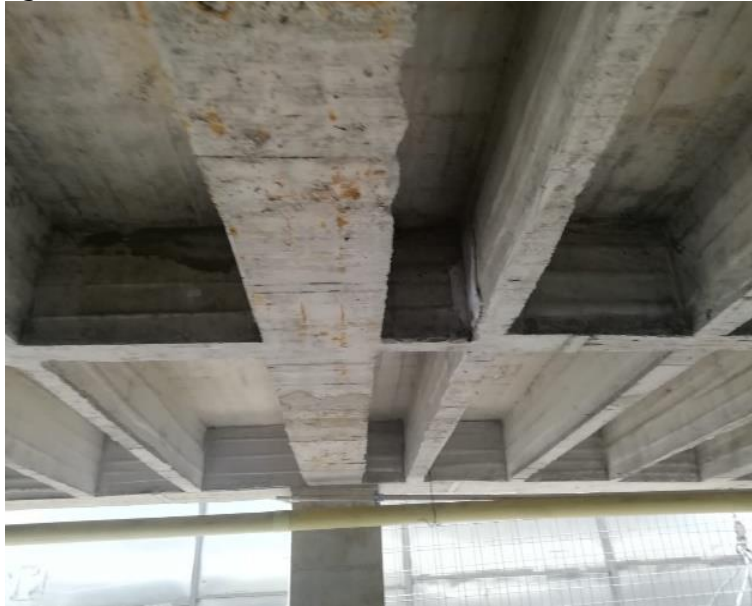
Figura 38. Placa aligerada construida
