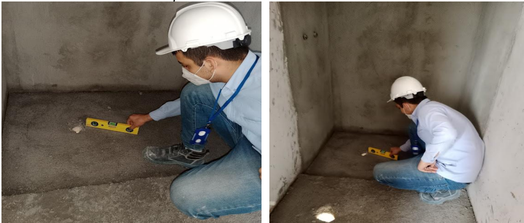
Figura 51. Control de calidad de pendientes en duchas
