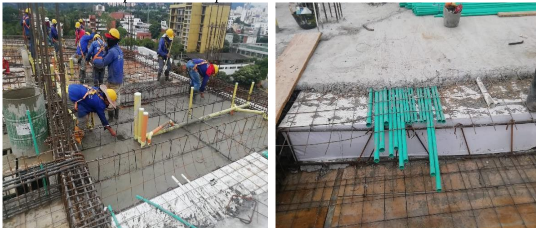
Figura 37. Construcción placa de entrepiso
