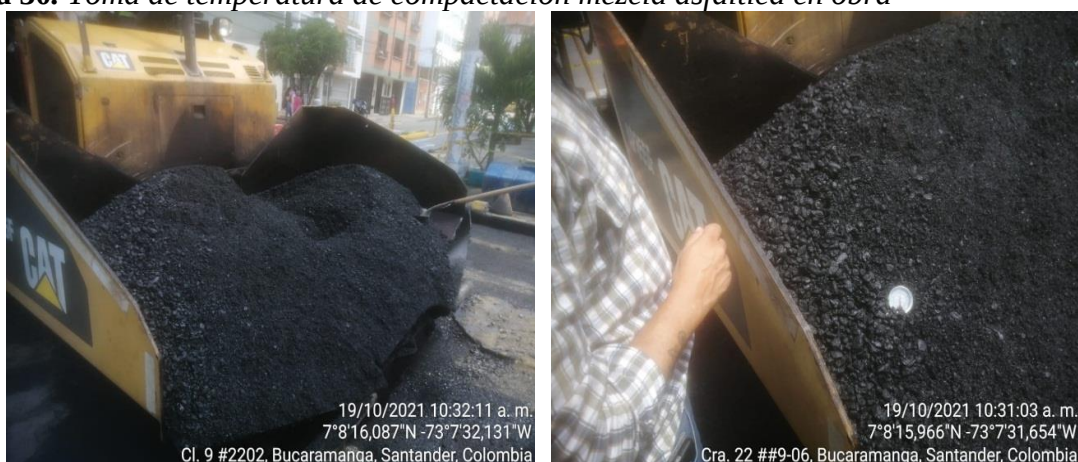
Figura 30. Toma de temperatura de compactación mezcla asfáltica en obra
