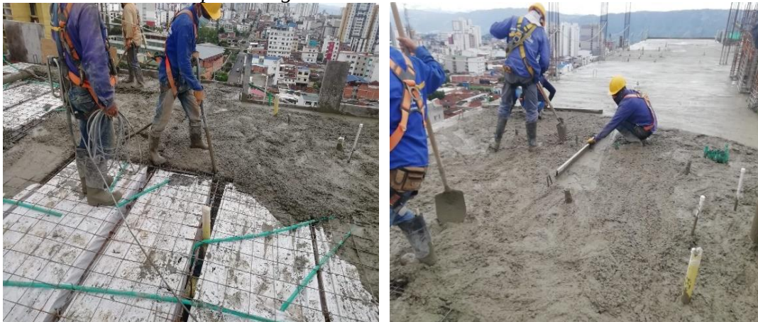
Figura 39. Construcción de placa aligerada de concreto
