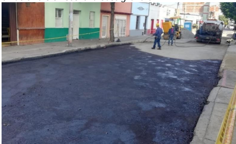
Figura 29. Irrigación de emulsión sobre la base granular
