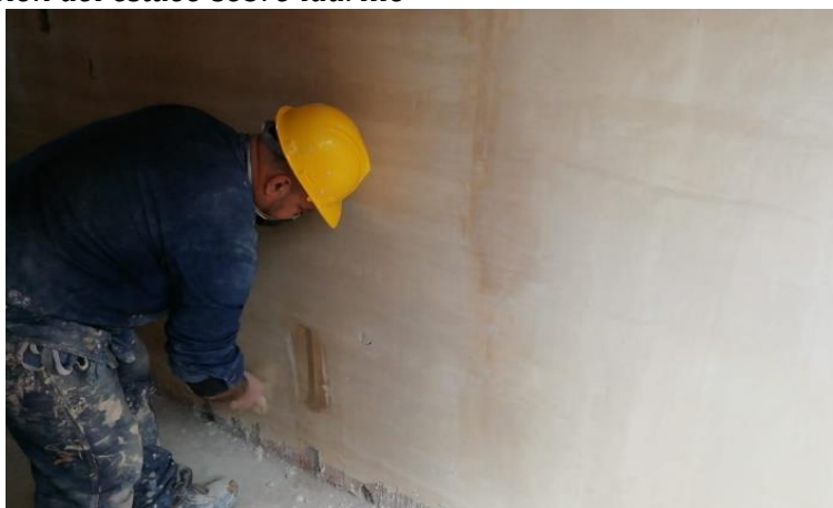
Figura 46. Aplicación del estuco sobre ladrillo
