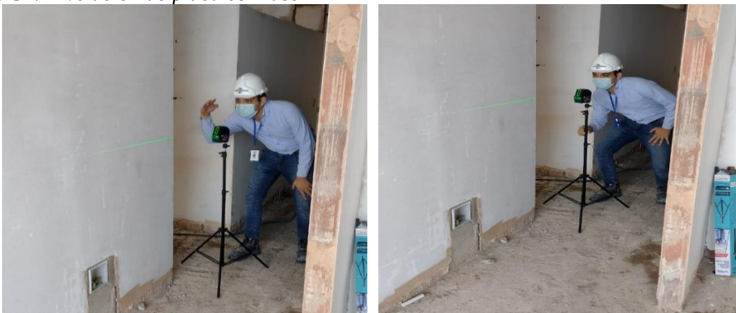
Figura 52. Nivelación de placa con láser
