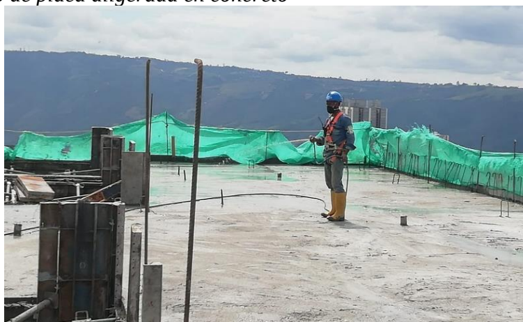
Figura 40. Curado de placa aligerada en concreto
