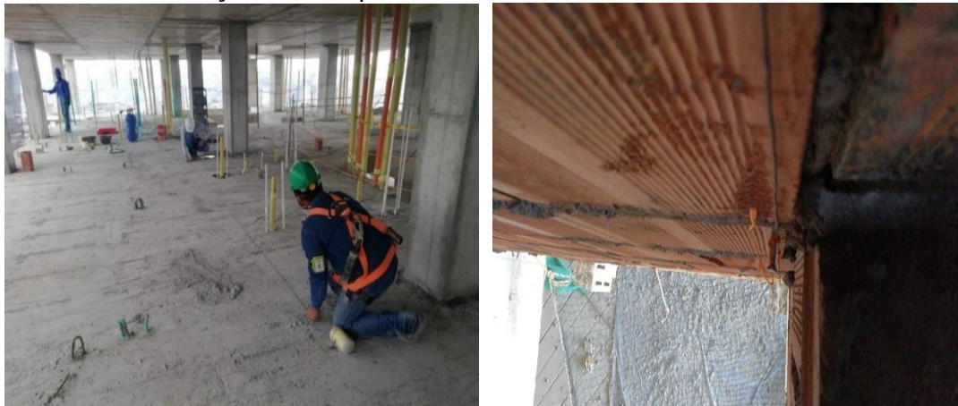
Figura 42. Calandros o ejes de la edificación
