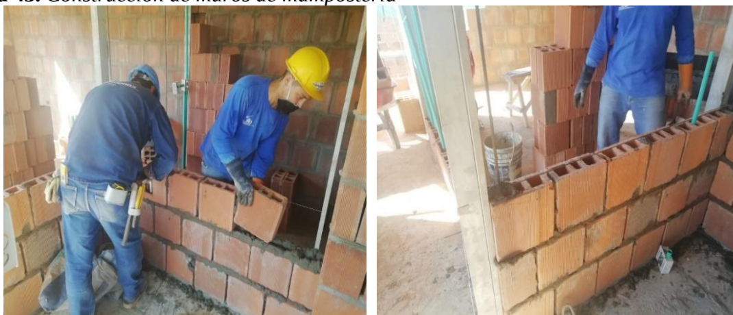
Figura 43. Construcción de muros de mampostería
