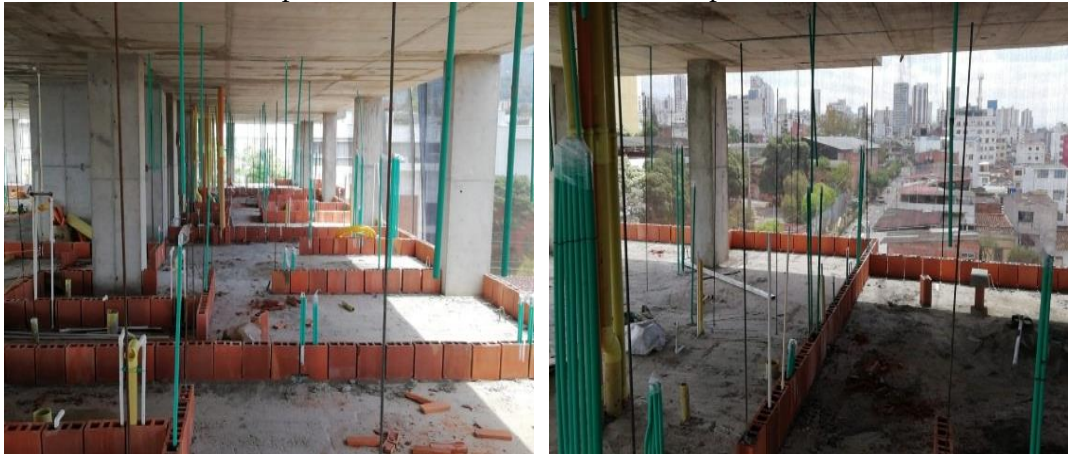
Figura 41. Construcción de primera hilada de muros de mampostería
