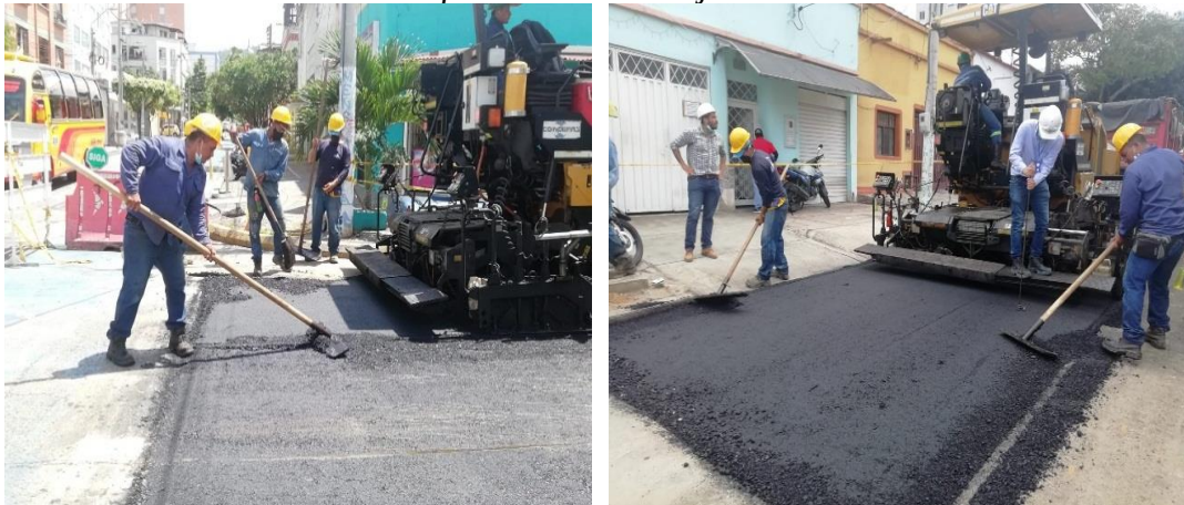
Figura 31. Distribución de mezcla asfáltica sobre la caja de la vía
