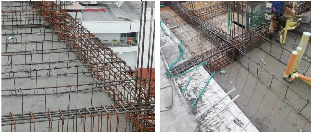
Figura 36. Vigas y viguetas con acero de refuerzo
