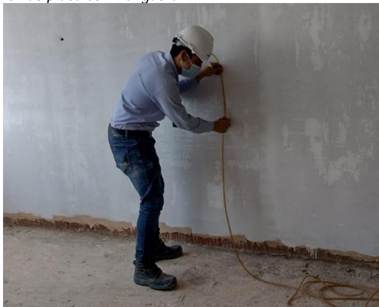
Figura 49. Nivelación de placa con manguera
