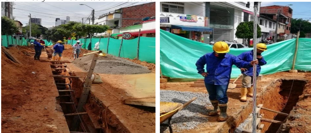
Figura 34. Línea y nivel de la tubería instalada
