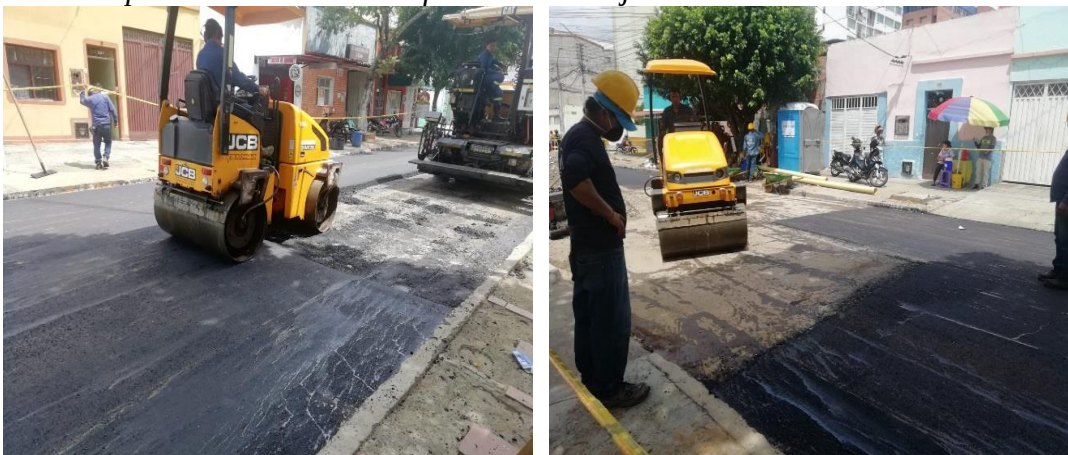
Figura 32. Compactación de mezcla asfáltica sobre caja de la vía
