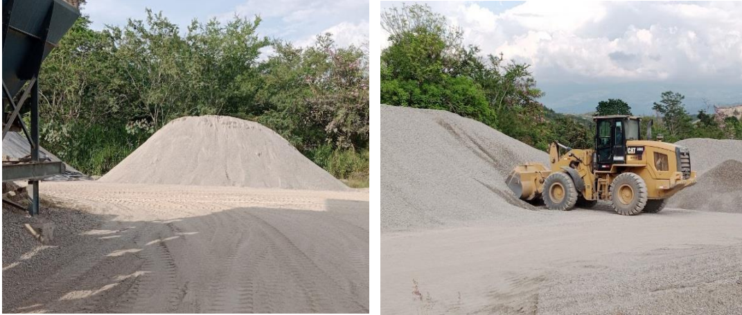
Figura 9. Acopio de agregados en la planta de producción de pavimentos
