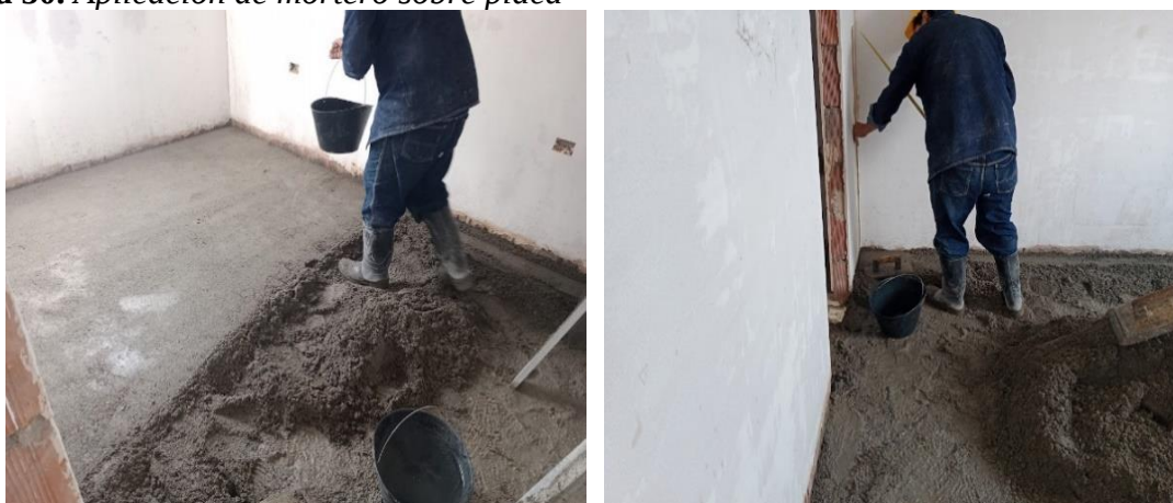
Figura 50. Aplicación de mortero sobre placa
