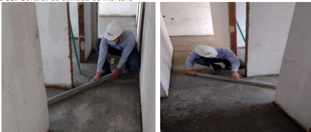
Figura 53. Control de calidad de mortero
