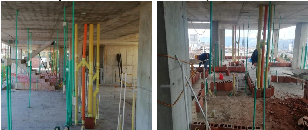
Figura 55. Aliviadero y cámaras de caída construida en los bajantes
