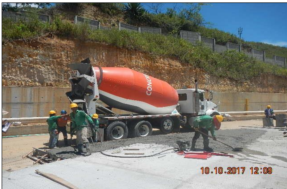
Figura 49. Vaciado de concreto losa de pavimento parqueadero Fuente: Autor
