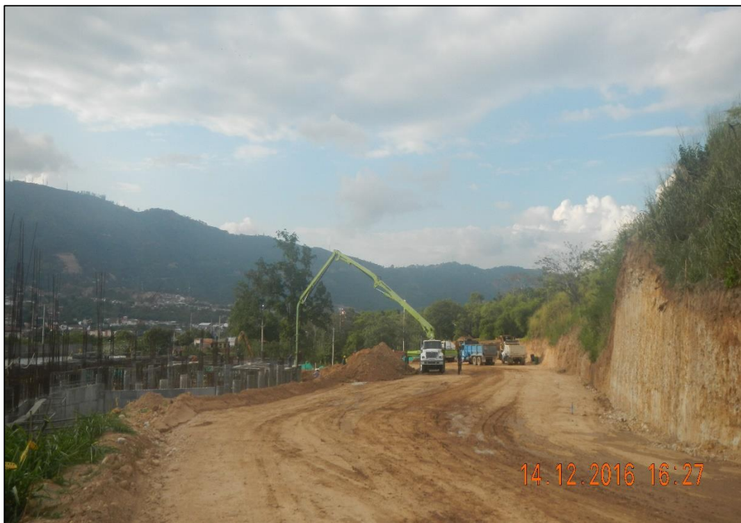
Figura 48. Subrasante de fundación patio parqueadero Fuente: Autor
