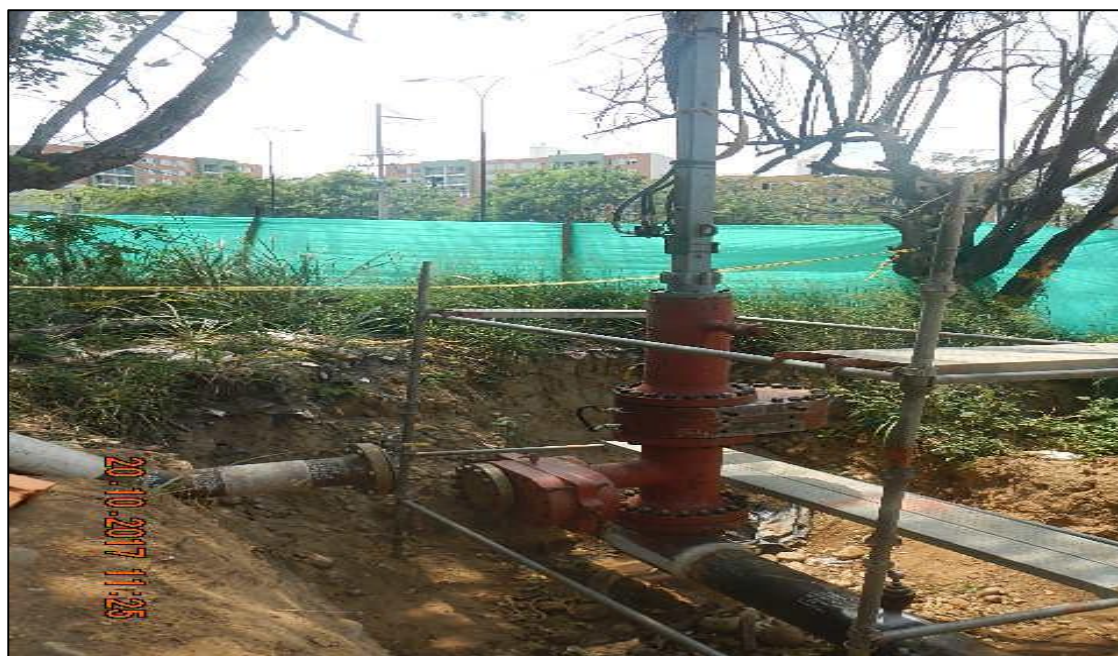
Figura 32. Hot Tap Tubería de 12" Gasoducto Fuente: Autor
