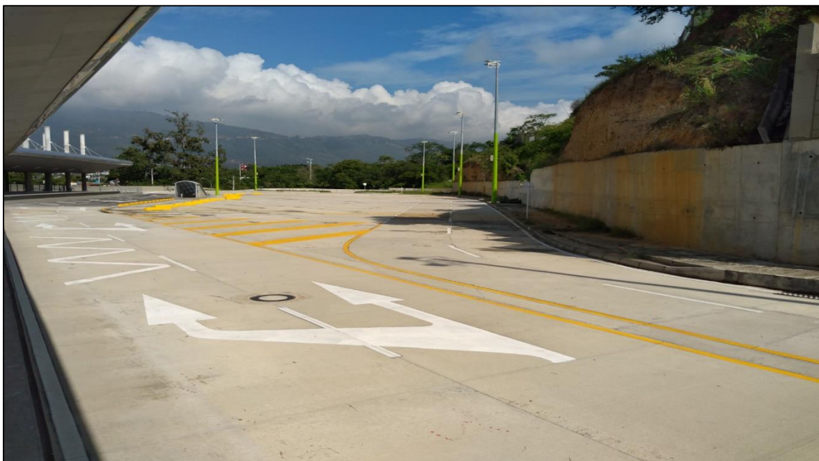
Figura 33. Obras civiles y traslado de gasoducto terminado Fuente: Autor
