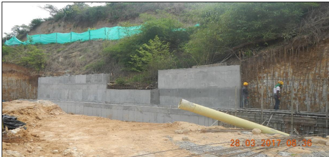
Figura 28. Construcción Muro de Contención Gasoducto Fuente Autor
