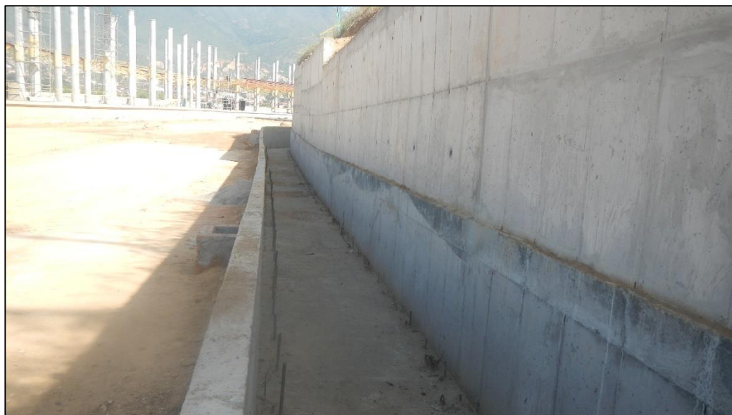
Figura 29. Muro de contención y cárcamo gasoducto terminado Fuente: Autor
