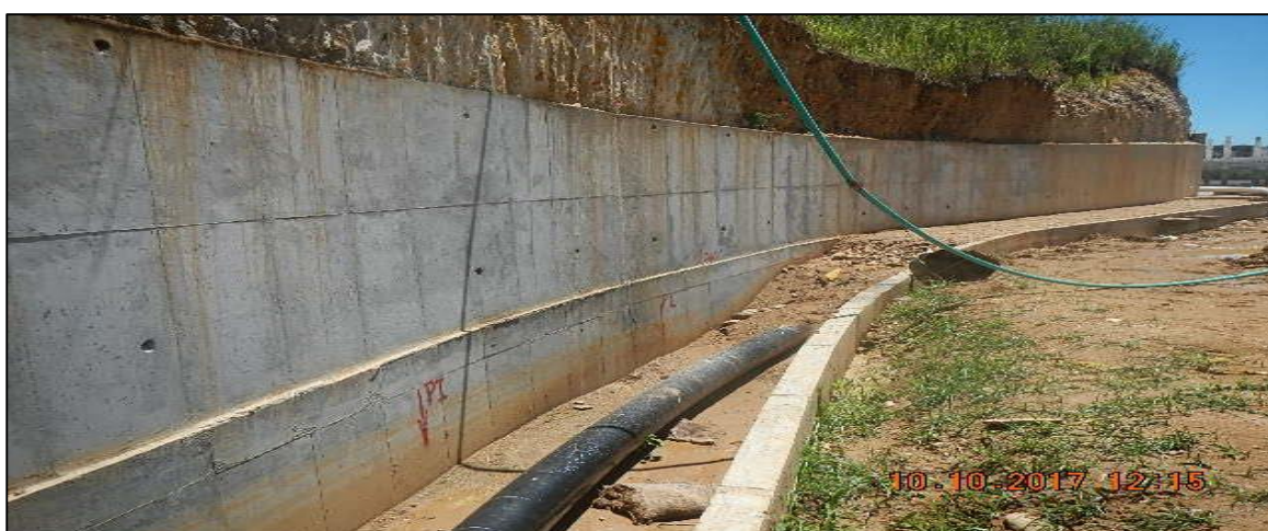
Figura 30. Tubería de 12" Gasoducto Instalada Fuente: Autor
