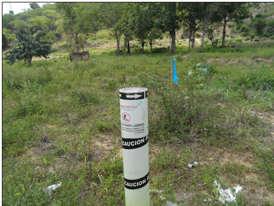
Figura 23. Señalización Gasoducto. Fuente: Metrolínea (2016)
