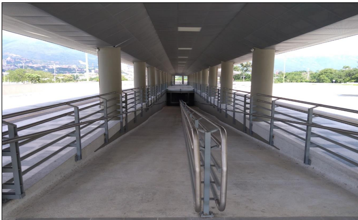
Figura 44. Rampa de Acceso Ejes 1 – 13 terminadas Fuente: Autor
