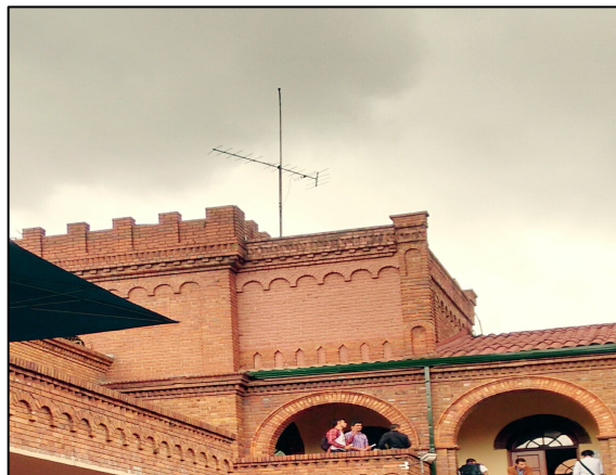
Figura 84 Antena tipo Yagui, usada para la captura de información de la banda del dividendo digital.
