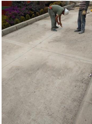
Sellado de juntas en placas de concreto. Alisos 1
