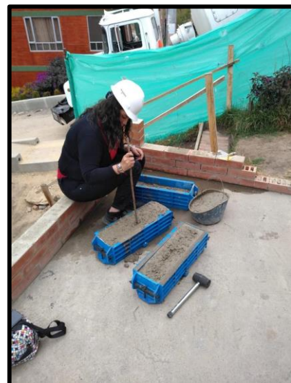
Figura 16. Realización de vigas.
