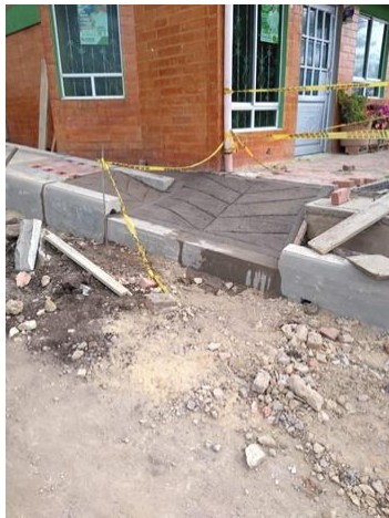
Construcción de rampa en concreto estriado 2500 PSI E=0.15m
