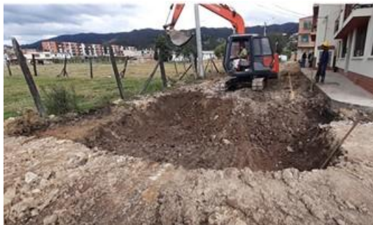
Excavación mecánica
