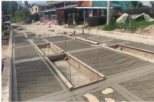
Concreto Clase D con f'c = 3000 psi, las placa huellas con. Espesor 20cm, estriado y escobiado.
