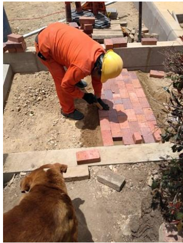
Suministro e Instalación de adoquín de arcilla en anden- Alisos 1
