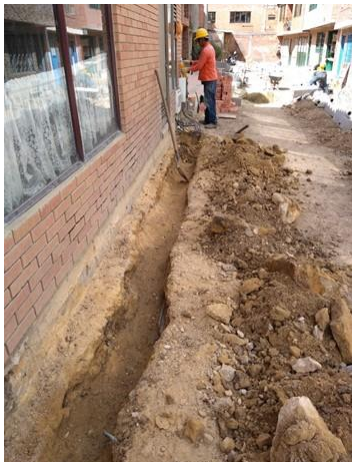
Excavación manual para instalación de sardinel, cañuelas y bordillos en concreto prefabricado. Técnico Industrial 3
