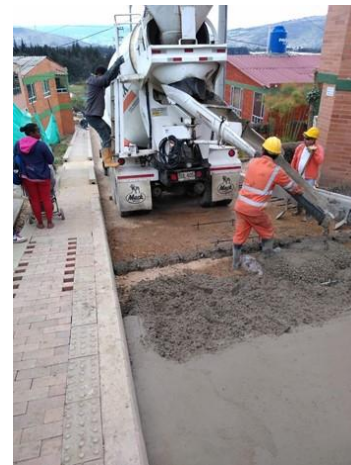
Concreto para pavimento rígido MR-41, incluye acero de transferencia y unión
