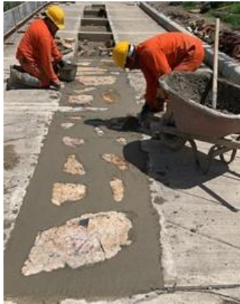
Concreto Ciclópeo Clase G, 3000 Psi 40% Y 60% Piedra Rajón para Base
