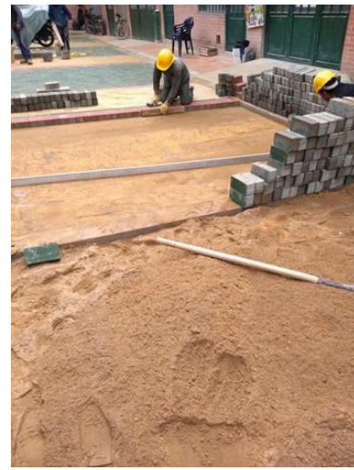
Base arena cemento para instalación de adoquín en concreto. Técnico 1,2 y 3
