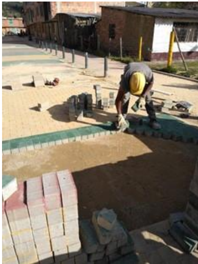
Base arena cemento para instalación de adoquín en concreto. Técnico 1,2 y 3
