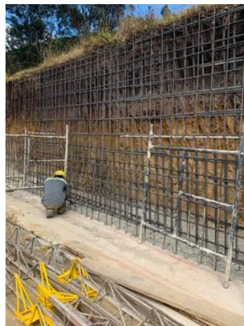
Suministro figurado y armado de acero de refuerzo 60000 psi
