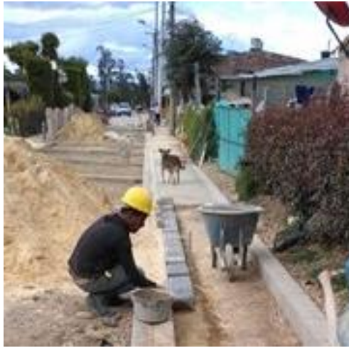
Instalación de tableta en concreto prefabricado
