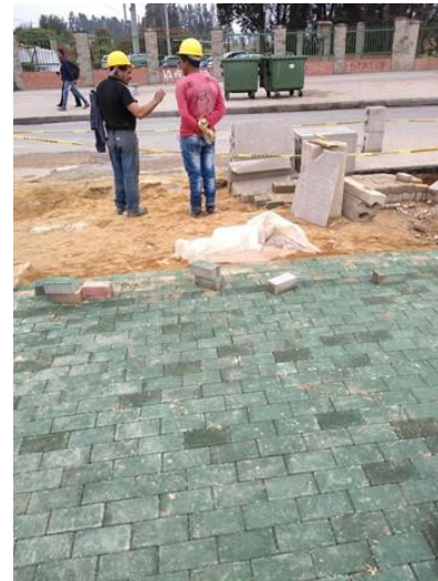
Intalación de adoquín en concreto de color.
