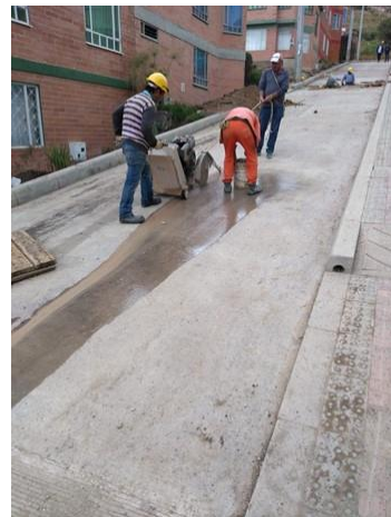
Corte de concreto con disco diamantado. Alisos 1
