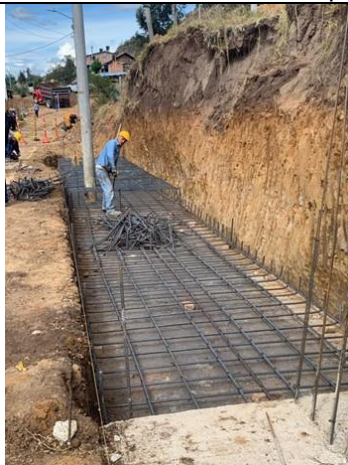
Concreto de limpieza para muro de contención. Alisos 1
