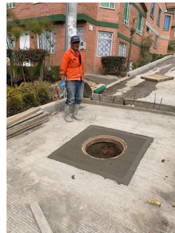
Nivelación de pozo en ladrillo. Alisos 1
