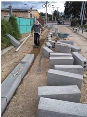
Excavación manual para instalación de sardinel, cañuelas y bordillos en concreto prefabricado. Técnico Industrial 3
