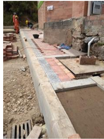
Suministro e Instalación de adoquín de arcilla en anden- Alisos 1
