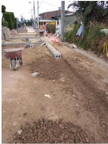
Excavación manual para instalación de sardinel, cañuelas y bordillos en concreto prefabricado Técnico Industrial 1 y 2
