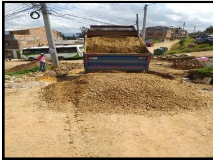
Figura 12. Disposición de materiales en obra.
