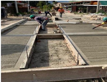
Viguetas intermedias en concreto premezclado clase D de resistencia 3.000 psi
