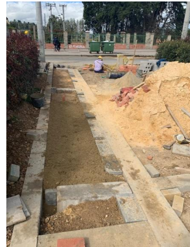
Instalación de tableta en concreto prefabricado
