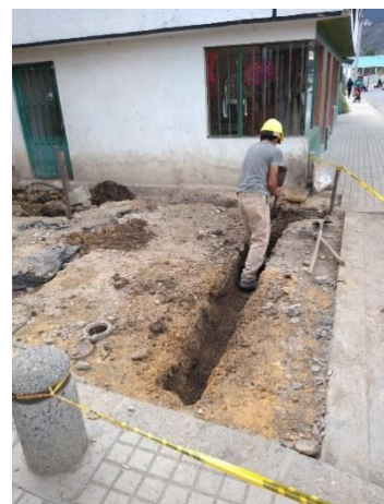
Excavación manual para instalación de sardinel, cañuelas y bordillos en concreto prefabricado. Técnico Industrial 3
