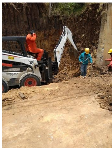
Excavación para mecánica y manual para muro de contención. Alisos 2
