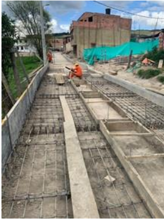
Armado de formaleta metálica y en madera para placa huella en concreto
