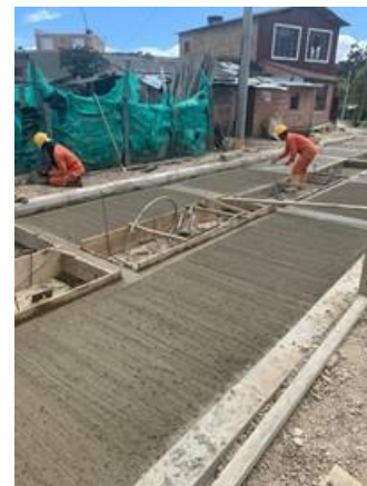
Viguetas intermedias en concreto premezclado clase D de resistencia 3.000 psi
