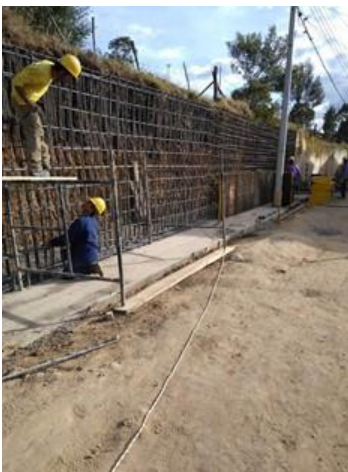
Suministro figurado y armado de acero de refuerzo 60000 psi
