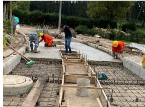
Armado de formaleta metálica y en madera para placa huella en concreto
