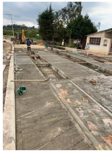
Concreto Ciclópeo Clase G, 3000 Psi 40% Y 60% Piedra Rajón para Base
