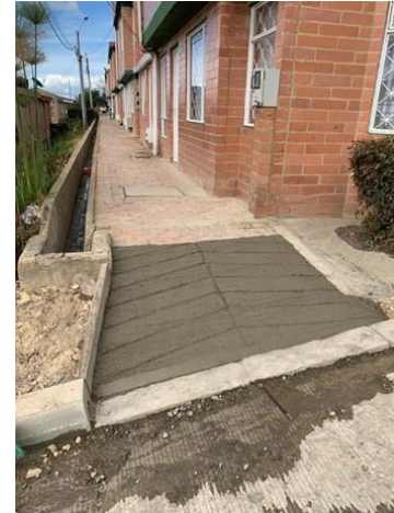
Construcción de rampa en concreto estriado 2500 PSI E=0.15m
