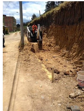
Excavación para mecánica y manual para muro de contención. Alisos 2
