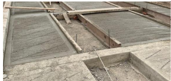
Viguetas intermedias en concreto premezclado clase D de resistencia 3.000 psi
