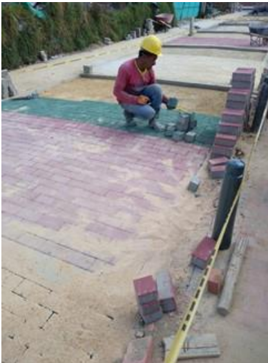
Intalación de adoquín en concreto de color.
