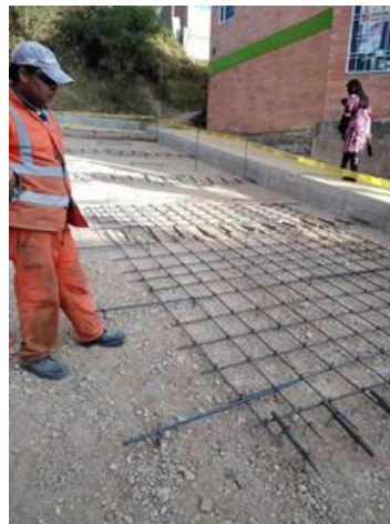
Suministro figurado y armado de acero de refuerzo 60000 psi para placa de concreto en bahía Alisos 1
