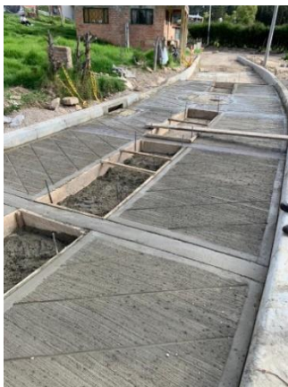
Viguetas intermedias en concreto premezclado clase D de resistencia 3.000 psi
