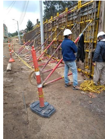
Encofrado para Muro de Contención
