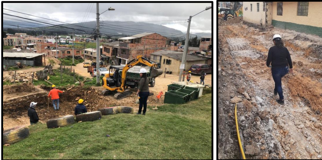
Figura 19. Inspección de las actividades en obra.
