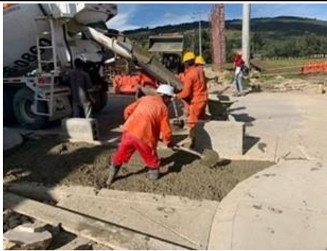
Concreto Clase D con f'c = 3000 psi, las placa huellas con. Espesor 20cm, estriado y escobiado.
