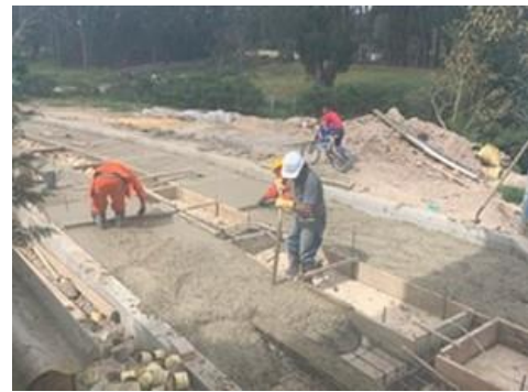
Concreto Clase D con f'c = 3000 psi, las placa huellas con. Espesor 20cm, estriado y escobiado.
