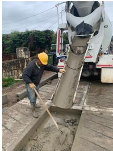
Concreto Ciclópeo Clase G, 3000 Psi 40% Y 60% Piedra Rajón para Base
