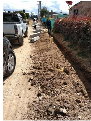
Excavación manual para instalación de sardinel, cañuelas y bordillos en concreto prefabricado Técnico Industrial 1 y 2
