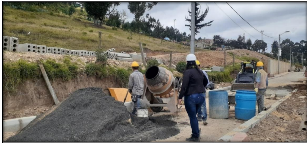
Figura 18. Supervisión de calidad de materiales.
