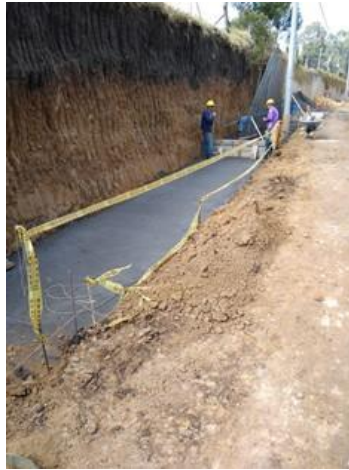
Concreto de limpieza para muro de contención. Alisos 1
