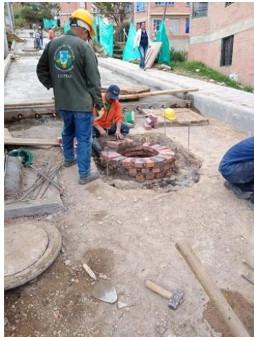
Nivelación de pozo en ladrillo. Alisos 1
