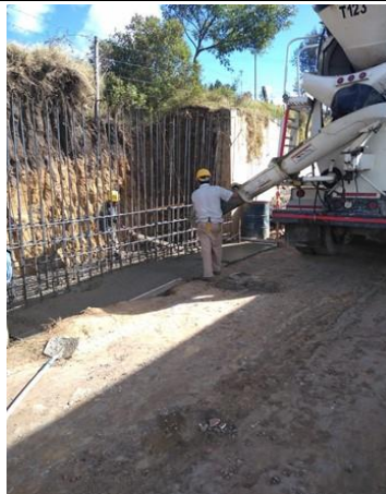
Fundida de zarpa de Muro de Contención concreto 3500 PSI premezclado
