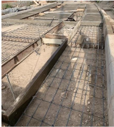
Armado de formaleta metálica para placa huella en concreto
