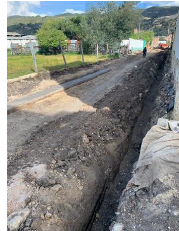
Excavación manual y nivelación de terreno
