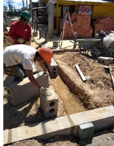
Excavación manual para instalación de sardinel, cañuelas y bordillos en concreto prefabricado. Técnico Industrial 3
