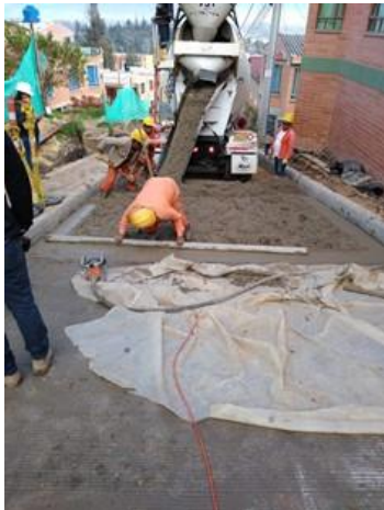
Concreto para pavimento rígido MR-41, incluye acero de transferencia y unión
