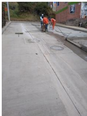
Corte de concreto con disco diamantado. Alisos 1
