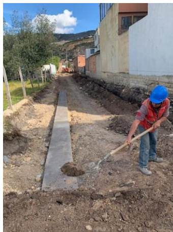
Excavación manual y nivelación de terreno
