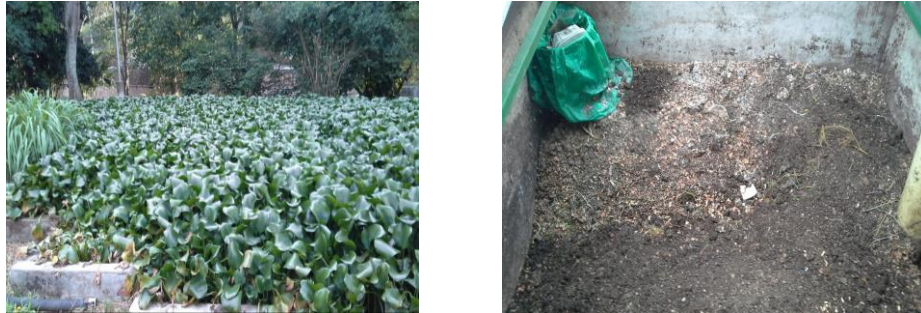
Figura 2. Sistema secundario- terciario de tratamiento y el lecho de secado que brinda las condiciones necesarias para realizar su compostaje.
