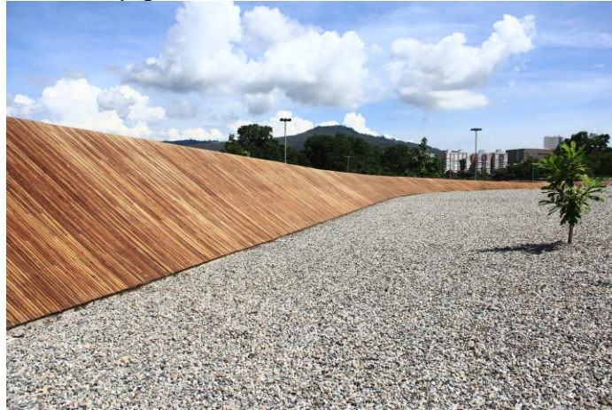
Figura 15. Talud de madera y gravilla
