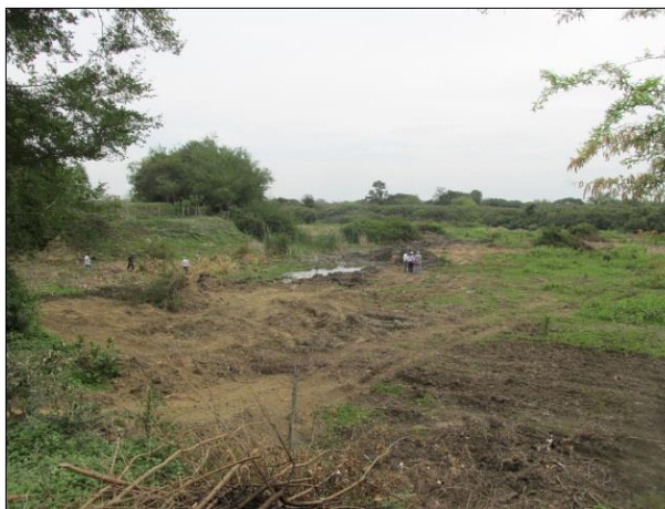
Figura 22. Cubeta lacustre terminada y adecuada sin montículos de tierra ni plantas invasoras, lista para el llenado de agua. Fuente: Fotografía de la autora.
