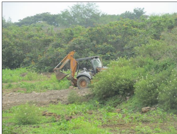
Figura 19. Trabajos con retroexcavadora para mover el material más pesado (montículos con escombros). Fuente: Fotografía de la autora.
