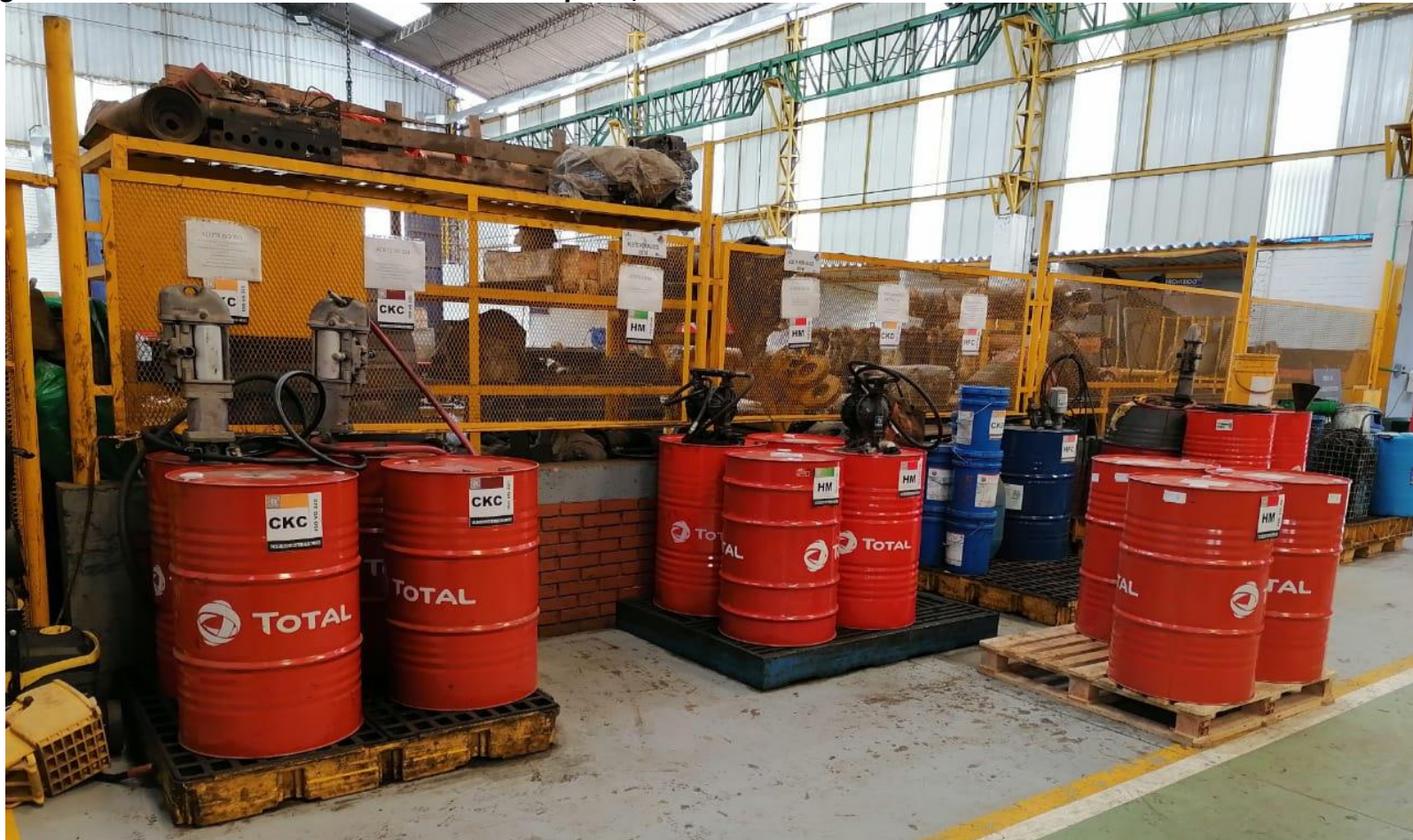
Figura. 47. Área de Lubricación donde se Aplicó, el Sistema de Identificación de Lubricantes.
