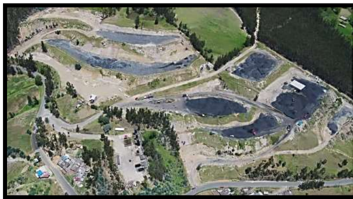
Fotografía 15. Panorámica del centro de acopio 3
