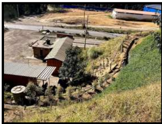
Fotografía 16. Centro de acopio 4
