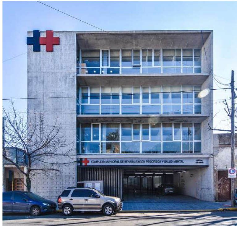
Figura 16. Complejo municipal de rehabilitación psicofísica. Fachada
