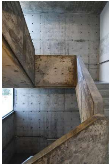
Figura 20. Complejo municipal de rehabilitación psicofísica. Componente técnico
