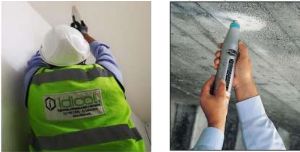
Ilustración 17. Toma de muestras con esclerómetro (Mosquera, 2020).
