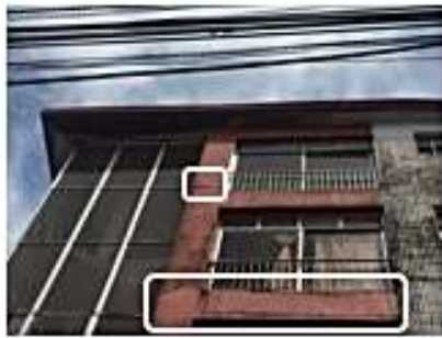
Ilustración 11. Planimetría y fotografía de lesión fisuras y desprendimiento (Mosquera, 2020).
