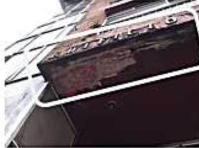
Ilustración 11. Planimetría y fotografía de lesión fisuras y desprendimiento (Mosquera, 2020).
