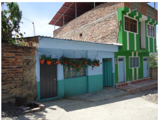
Imagen 4. Estructura de vivienda en el municipio de La Uvita, Boyacá.
