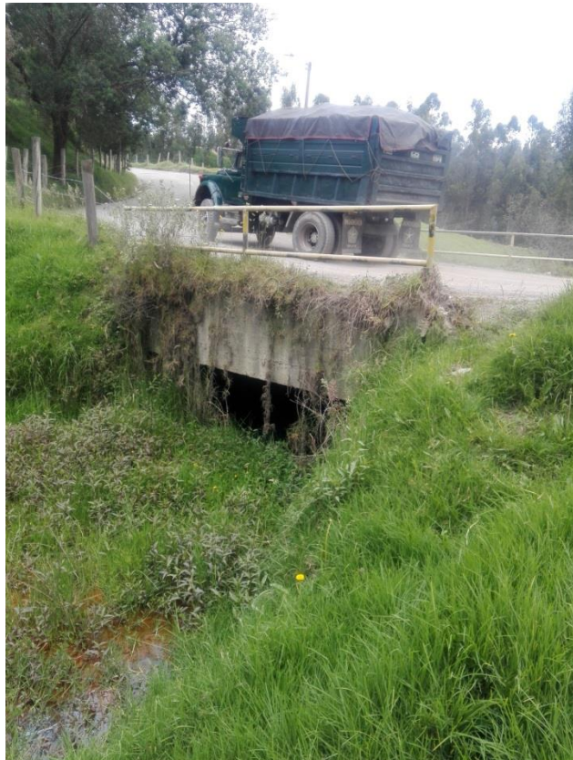
Figura 9: Vista parcial Pontón
