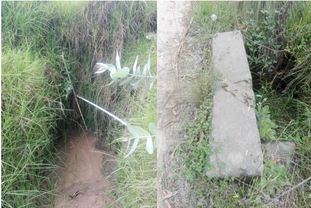
Figura 21: Encole y descole alcantarilla K2+050
