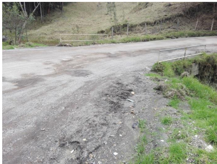
Figura 1. Pontón de la vía Morca-Sogamoso K1+100
