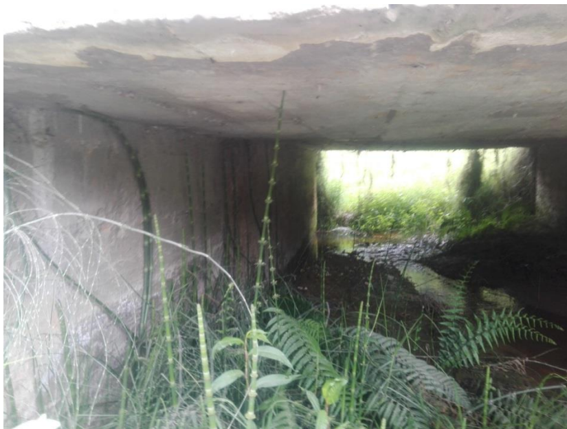
Figura 10: Vista de dovelas y placa del Pontón
