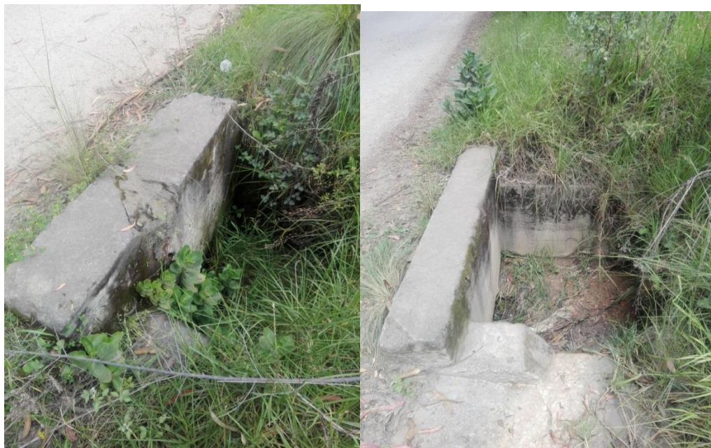
Figura 8: Encole y descole alcantarilla K0+750
