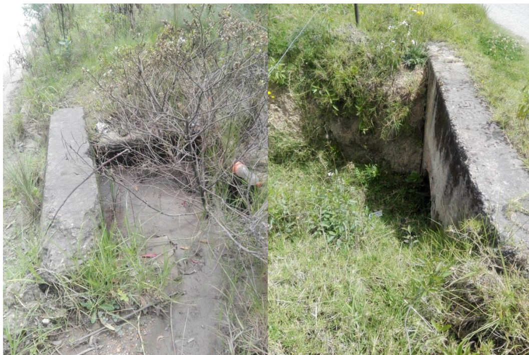
Figura 20: Encole y descole alcantarilla K1+000
