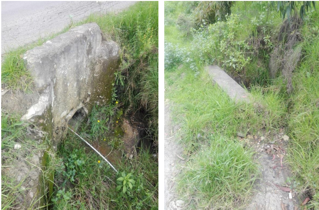
Figura 7: Encole y descole alcantarilla K0+400
