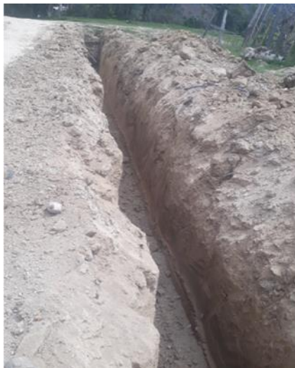
Ilustración 4 Excavación de zanja para tubería de alcantarillado en urbanización Alta Mira.
