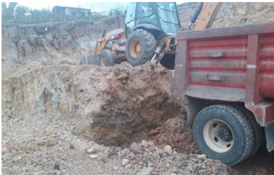
Ilustración 4 Excavación de zanja para tubería de alcantarillado en urbanización Alta Mira.
