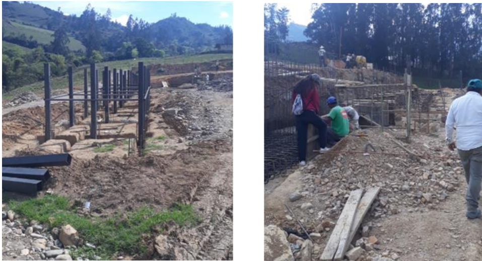
Ilustración 5 Inspección a la nueva Plaza de Ferias.
