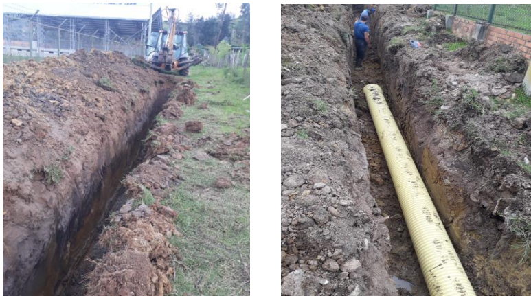
Ilustración 6 Excavación e instalación de tubería para alcantarillado en vía aledaña al Estadio Municipal del municipio de Tibaná.
