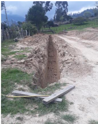
Ilustración 4 Excavación de zanja para tubería de alcantarillado en urbanización Alta Mira.
