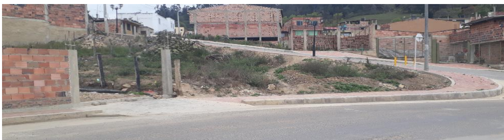
Ilustración 8 Lote a construir.
